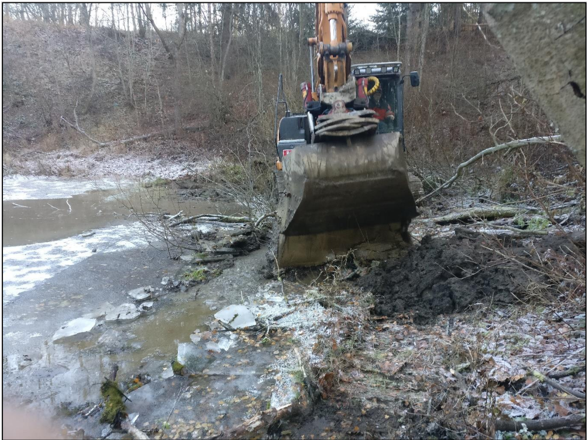
Kuva 4. Koekuopitus tehtiin kaivinkoneella.
