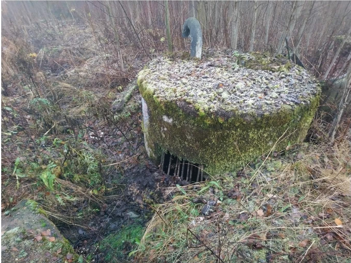
Kuva 2.2. Pääradan alittava rumpu ja sisäänotto kaivoon suunnittelualan länsiosassa.
