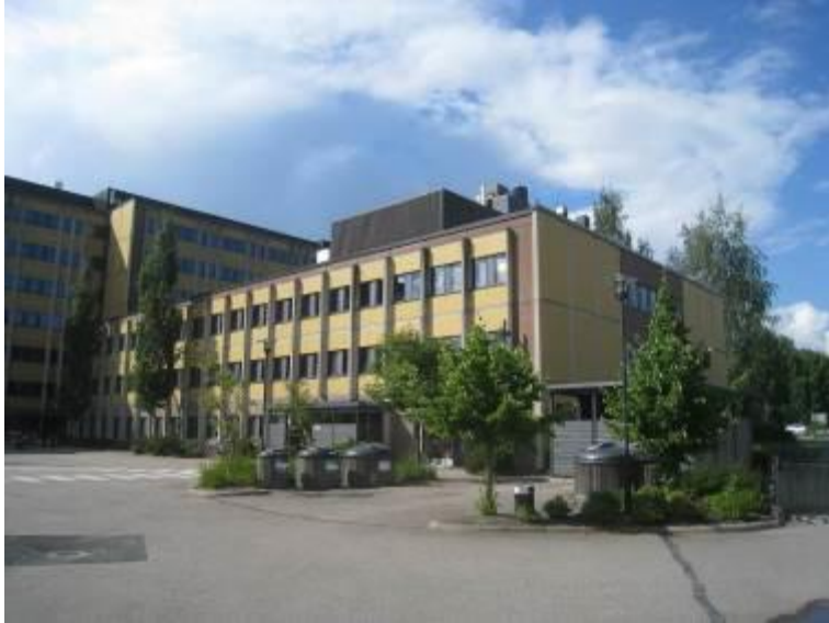
Kuva 24. Hippotalon pohjoinen julkisivu vuodelta 2012. /9/
