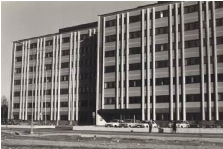
Kuva 15. Hippotalon julkisivu länteen v. 1980. Kuvaaja Jukka Marttila. /7/
