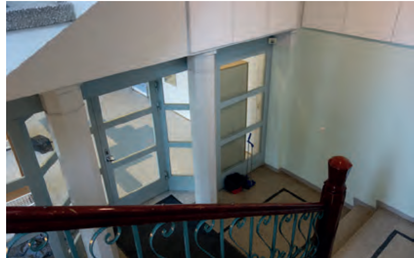
Oppilaiden porrashuoneen ja ensimmäisen kerroksen välisen aukon porrasaiheet. Lasiseinä on peröisin vuoden 1990 muutostöistä.
