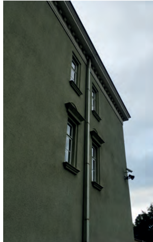
Asunto- ja keittiösiiven aukotusta. Keittiökerroksessa ei ole ikkunoita päädyssä.
