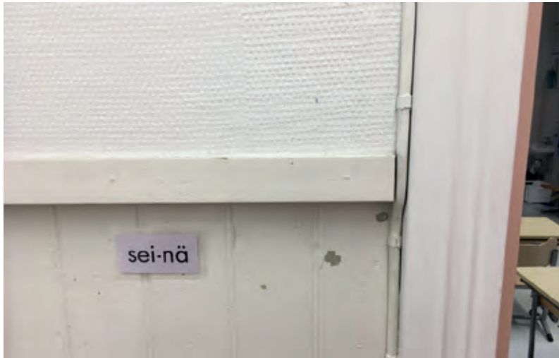
Oppilaseteisen puolipaneli on alkuperäinen ja useaan kertaan maalattu. Yläosan pinkopahvipinnat ovat uusittu ja ovat nykyään päällystetty lasikuitutapetilla.
