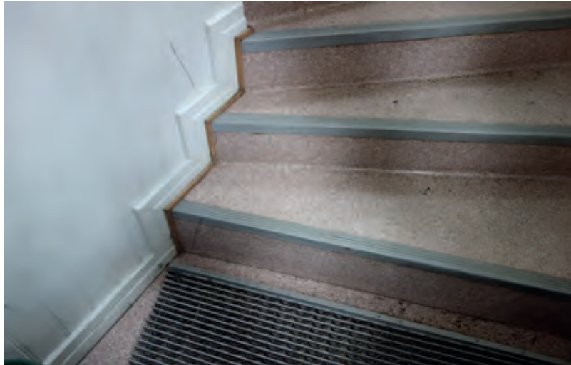
Kaikki lattian pintamateriaalit ovat talossa muovimattoa. Kuistin lattialistoitus on tyypiltään 1920-luvun tyylinen.
