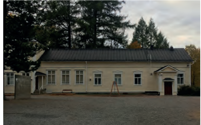
Julkisivu pihalle päin. Oikealla vanhin rakennusvaihe, joka käsitti alun perin voimistelu- ja käsityösalin, leivintuvan ja kamarin
