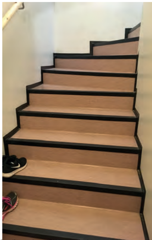
Oppilaseteisestä lahteva vanna porrashuone on uudistettu täysin pinnoiltaan
