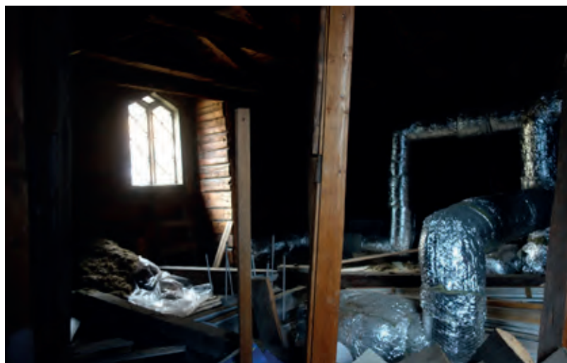
Talon ullakko on rakentamaton. Uudet ilmanvaihtotekniikan asennukset ovat näkyvissä tilassa
