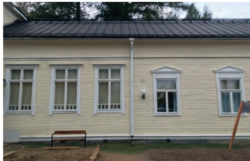
Heikki Tiitolan jugendosan ja ensimmäisen rakennusvaiheen liitoskohta julkisivussa
