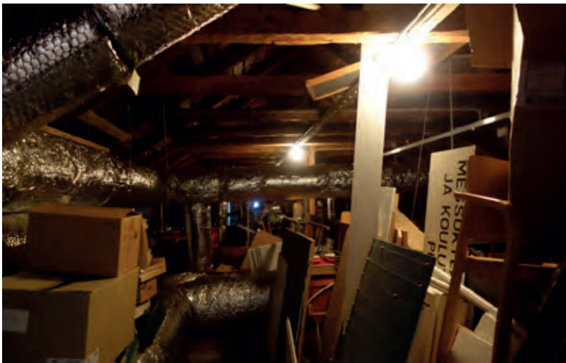
Rakentamaton ullakkotila, jossa ilmanvaihdon asennuksia
