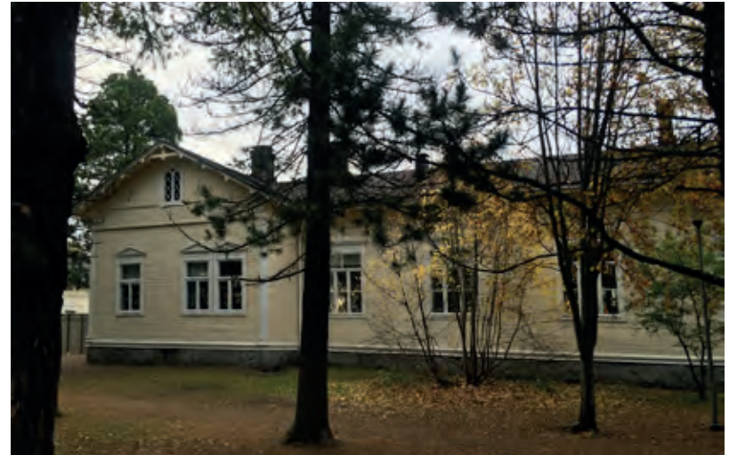
Takajulkisivu. Alkuperäisten suunnitelmien mukainen käynti asuntoihin on tapahtunut poikkiharjan kohdalta. Laudoituksessa on luettavissa laudoituksen täydennyksen jäljet.
