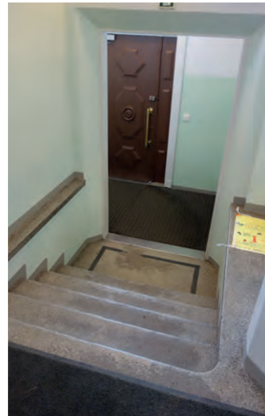
Asunto- ja keittiösiiven porrashuoneen pohjakeroksen tason alkuperäinen mosaiikkibetonilattia.
