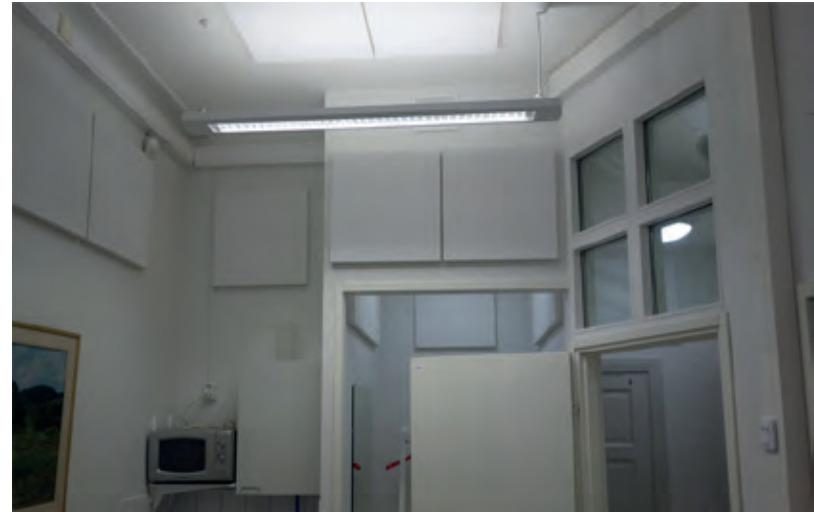
Rehtorin ja kanslian toimistotilat on tehty jakamalla alunperin ruokailuhuoneena ja myöhemmin luonnontieteenluokkana toiminut tila pienempiin osiin.
