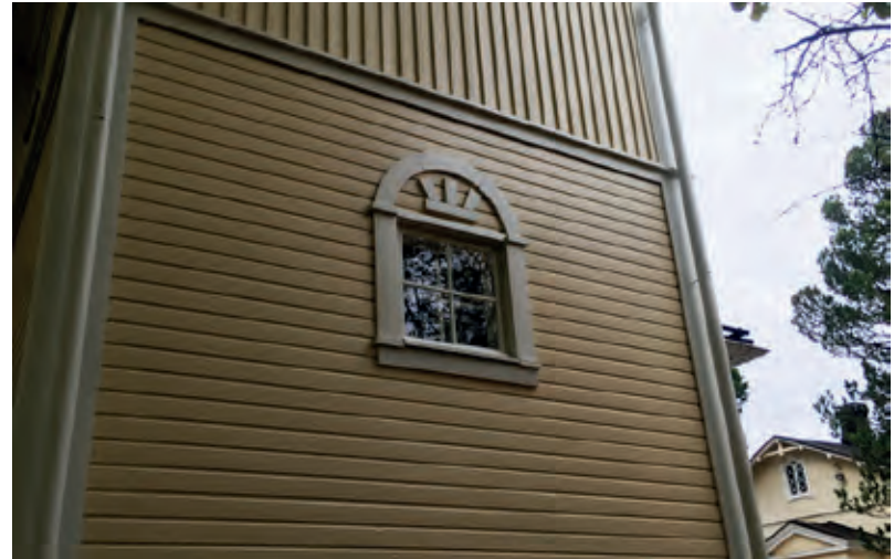
Eteläpäädyn kuistin laajennuksessa uusittiin vuoden 1922 klassistisen laajennuksen ikkunoiden verholautoituksen yksityiskohdat vanhan mallin mukaiseksi.
