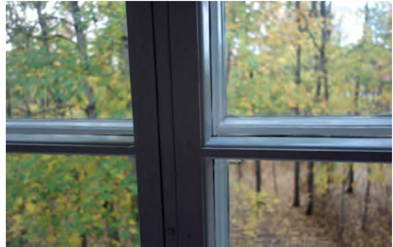
920-luvulle tyypillistä profilointia toisen kerroksen ikkunoissa.
