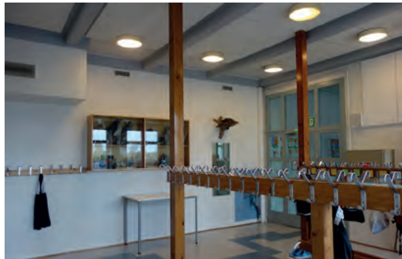
Oppilasteteisen katossa näkyvät vielä juhlasalin palkisto. Porrashuoneen vuoden 1990 korjauksessa lisätty teräslasiseinä erottaa aulan porrashuoneesta
