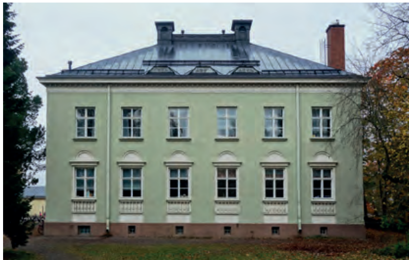
Julkisivu Messukylänkadun suuntaan
