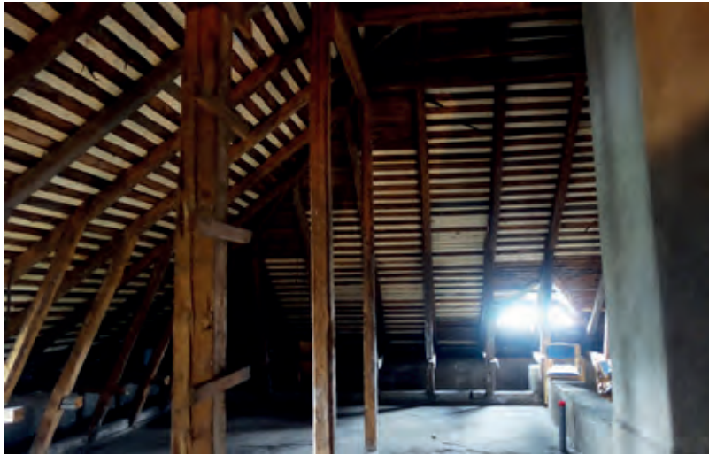
Ullakkotila on vuoden 1990 korjauksessa tehtyä ilmanvaihtokonehuonetta lukuunottamatta rakentamaton
