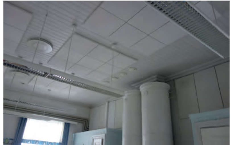
Isojen luokkahuoneiden kattopinta on alkuperäistä puupanelointia.
