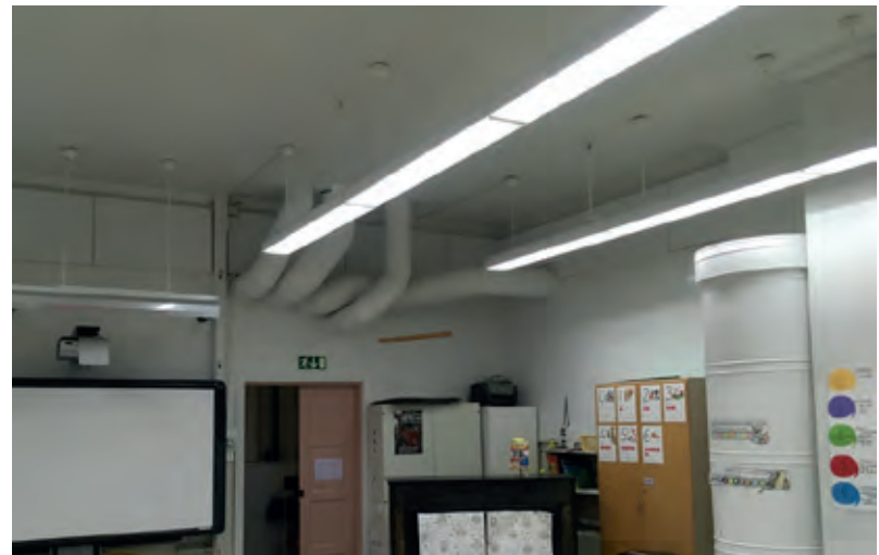
2000-luvun ilmanvaihtokorjauksen jäljiltä luokkatilassa on näkyvissä ilmanvaihdon asennuksia.
