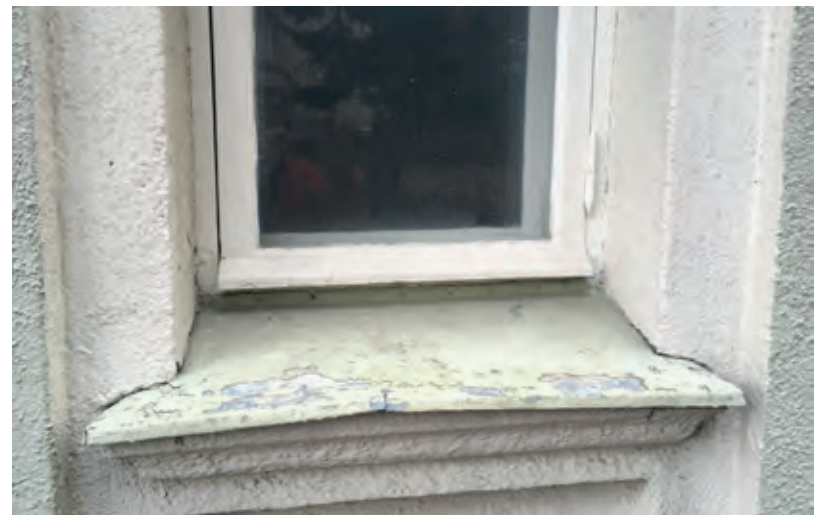
Julkisivun pinnoite on mahdollisesti Kenitexiä tai vastaavaa ruiskupinnoitetta.
