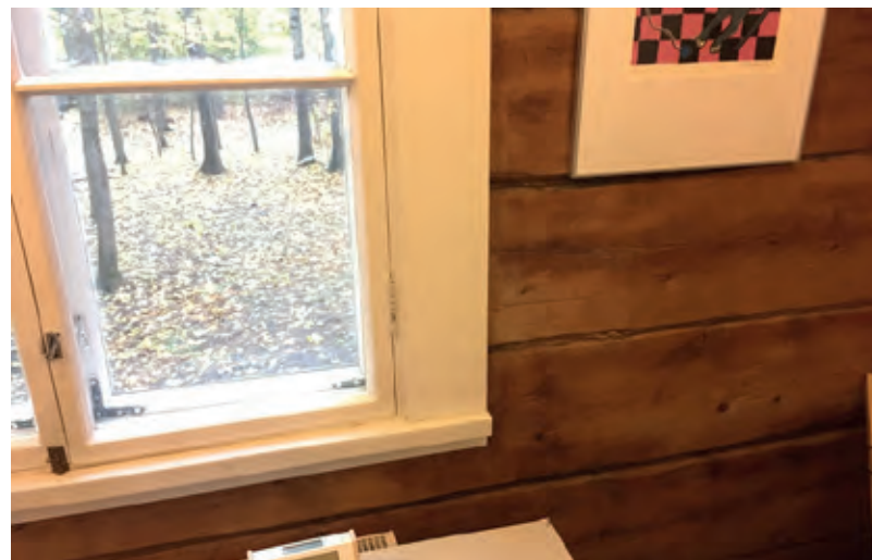
Vanha hirsirunko on paljastettu näkyviin esiopetuksen tiloissa. Hirret ovat poikkeuksellisen kookkaita ja taitavasti veistettyjä.
