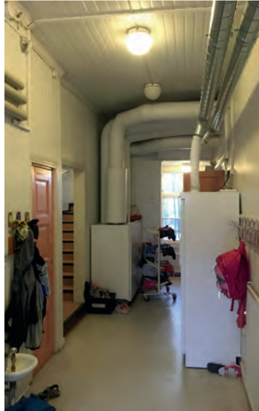
Oppilaseteinen on säilynyt vuoden 1906 muodossa. Tilassa on alkuperäisiä pintamateriaaleja seinissä ja katossa. Ilmanvaihtokoneet ovat 2000-luvun IV-korjauksen jäljiltä.
