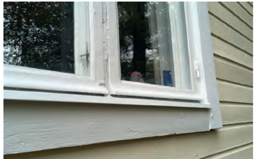
Vanhat ikkunat ovat pasun maalikerroksen peitossa. Ikkunoiden profiili täsmää 1880-1910 -lukujen ajoitukseen.
