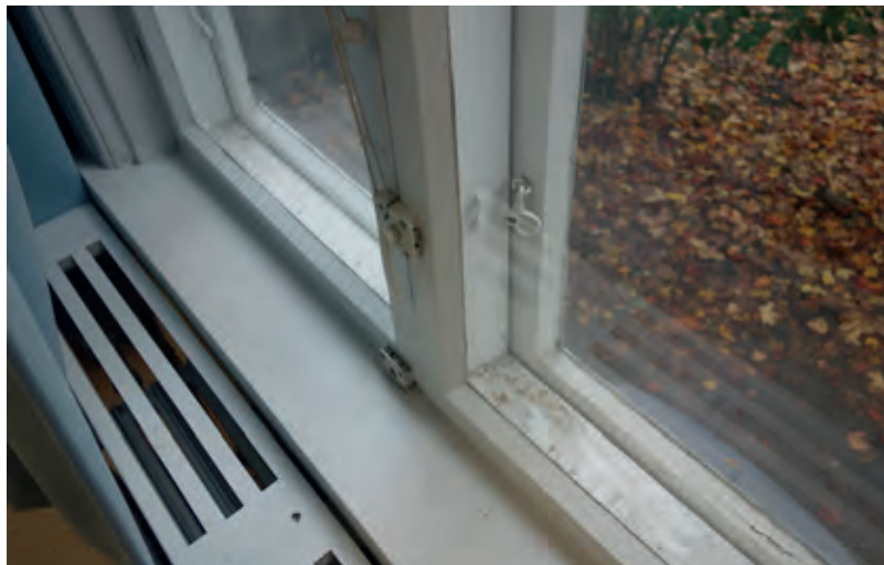
Asuntosiiiven takajulkisivun puoleiset sisään-ulos-aukeavat ikkunat on uusittu jossain vaiheessa, todennäköisesti vuoden 1960-luvun muutosten aikoihin yksinkertaisimmin profilein.
