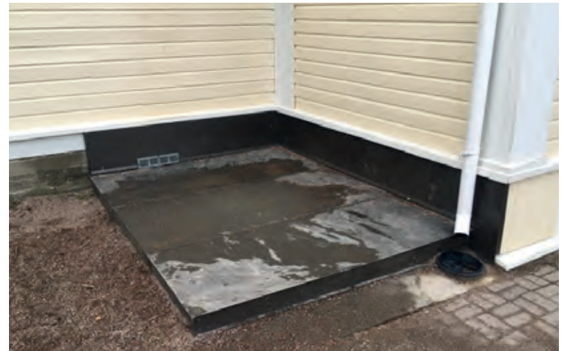
Oletettavasti 1933 kuistin viereen rakennetun ruokakellarin portaat on suljettu ylläpitosyistä teräskannella.
