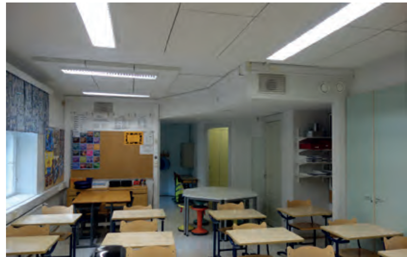
Ruokalan keittiötilat muutettiin vuoden 1990 muutostöissä terveydenhoitajan tiloiksi. Tilat toimivat nykyään opetustiloina. Vanhat rakennusvaiheet näkyvät tilojen epäsuotuisina muotoina.
