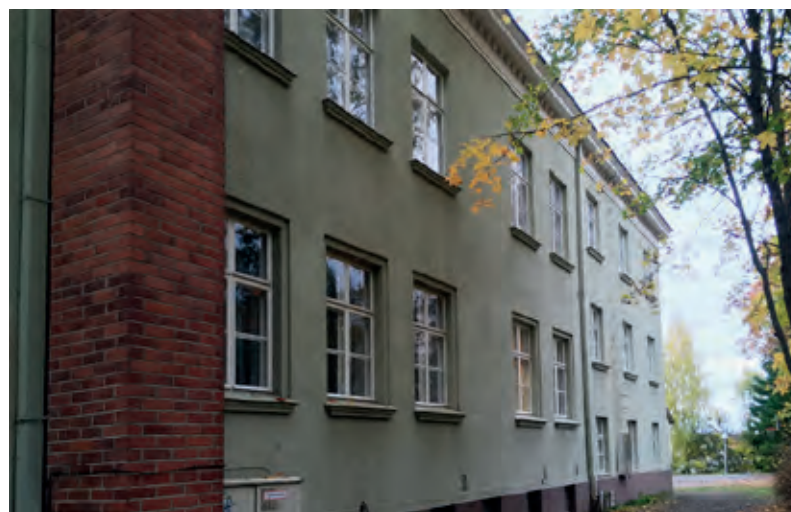
Itäjulkisivun puhtaaksi muurattu tiilipiippu on peräisin alueelle vuonna 1965 toteutetusta keskuslämmityksestä. Talon kaksi- ja kolmekerroksisest siivet näkyvät selvästi julkisivun aukotuksessa.
