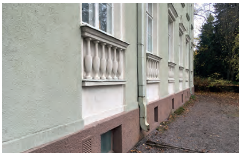
Messukylänkadun puolella ensimmäisen kerroksen ikkunoiden pystysuuntaa on korostettu puisilla balusteri-aiheilla.
