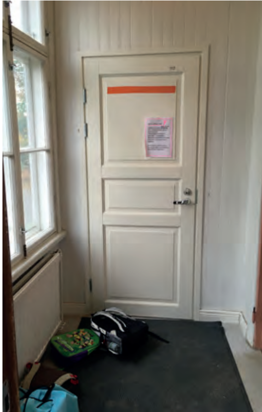
Tuulikaappi TK116:ssa on säilynyt alkuperöistä panelointia ja ikkunadetaljontia. Peiliovi listoituksineen on uusinta 2000-luvun kerrostumaa.
