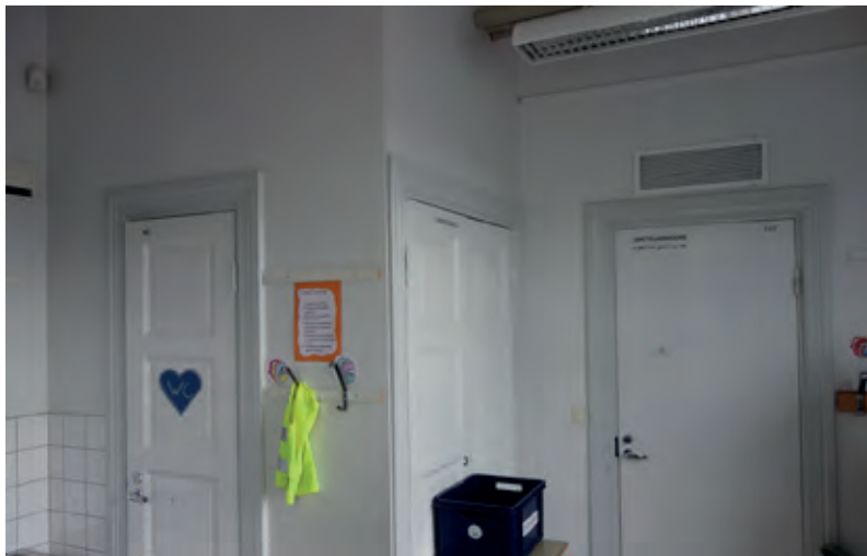
Enstisen asuntosiiven eteistilojen materiaalit ovat moderneja, valkoisia, levytettyjä pintoja. uudet ovet ovat vanhaan henkeen toteutettuja peiliovia 1990-luvulta ja vanhempia, moderneja laakaovia 1960-luvulta.
