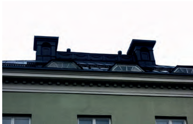
Vesikatto on uusittu onnistuneesti 2014. Katon harjan ja piippujen koristeaiheet antavat rakennukselle 1920-luvun klassismin luonnetta
