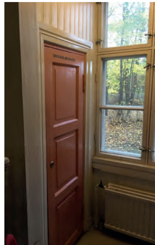
Portaiden alla sijaitseva komero on nykyään siivousskomerokäytössä. Ovet ja ikkunat alkupe- röiset, myös säilyneitä listoituksia
