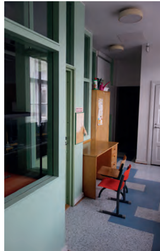
Vuoden 1990 muutostöissä toteutettiin toisen kerroksen tilamuutosten yhteydessä uuden kirjastotilan lasiseinäinen sivukäytävä. Lattiassa uutta vinyylilaatoilla toteutettua kuviointia.
