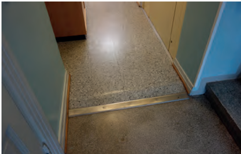
Vuoden 1990 hissilisäys on vaatinut asunto- ja keittiösiiven porrashuoneen laajentamisen entisen asunnon puolelle.
