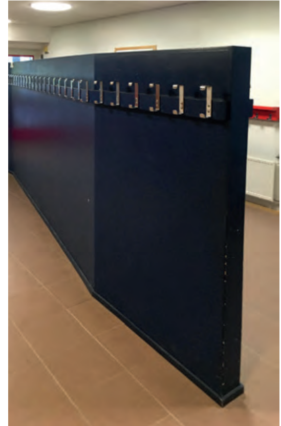
Ala-aulan syvän sininen betoniseinä, joka toimii naulakkona.
