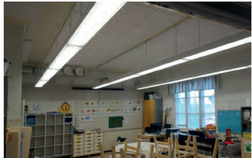
Toisen kerroksen 1922 luokkahuoneeksi rakennettu tila on edelleen opetusikäisessä. Kattopinnoissa näkyvissä alkupeöristä puupanelikattoa.
