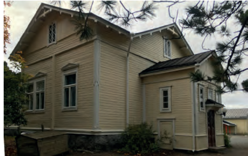
Itäpääty takajulkisivun puolelta. Käytöstä poistunut käynti kellariin näkyy kuistin sivulla. Kuistin laajennus- ja muutostyöt voidaan ajoittaa vuosiin 1927...1933.
