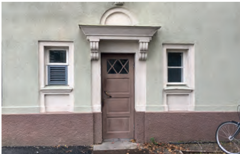
Kellarin käynti on muita sisäänkäyntejä pienempi, mutta merkitty klassismin muotokielen mukaisesti voluuttikonsolien kannattamalla palkkiaiheella.
