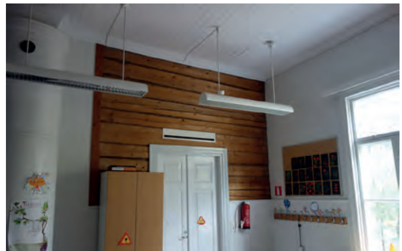
Keskellä sijaitsevassa oppilaseteisessä on myös säilynyt tulisija ja kattopaneloinnit. Seinän yläosa on paljastetu hirsipinnalle, alaosassa on puolipanelointi.
