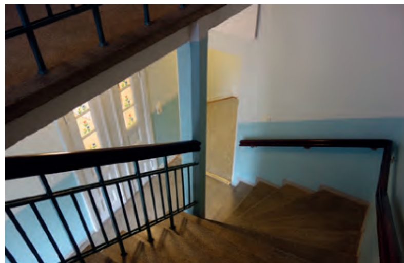
Asunto- ja keittiösiiven porrashuoneessa on aistittavissa alkuperäinen materiaalivaikutelma. Askelmat ja lepotaso ovat mosaiikkibetonia, kaiteet rautaa ja käsijohde kuullotettua puuta. Ovet ovat alkuperäisiä lasipuuovia. Porrashuoneen laajennus hissien takia näkyy lattiamateriaalin vaihtumisena.
