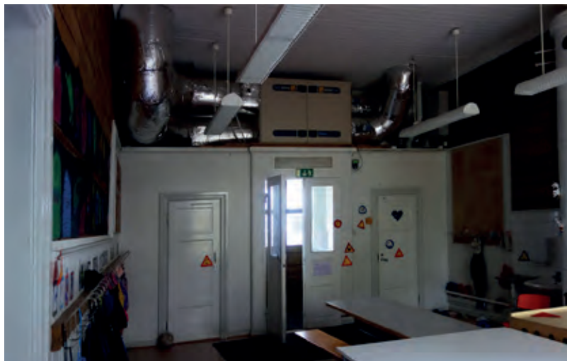
Oppilaseteisen tuulikaapin molemmin puolin vuoden 1990 muutostöissä tehdyt wc-tilat. Katon IV-asennukset ovat 2000-luvun ilmanvaihtotöiden ajalta.
