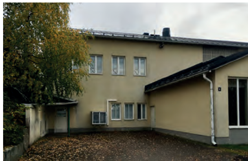
Takajulkisivu, keittiön huoltopiha
