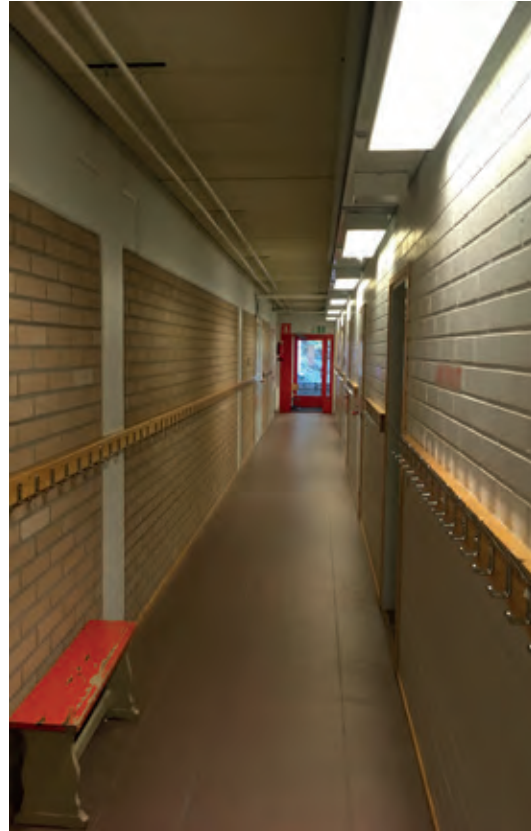
Liikuntahallin sivukäytävä, johon aputilat avautuvat.
