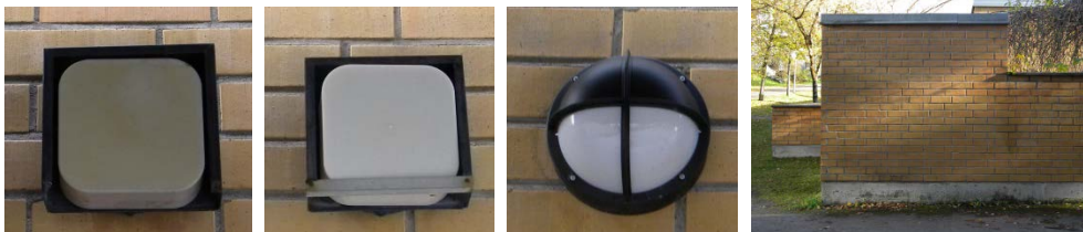
Vasemmalla koulun alkuperäinen ulkovalaisin, toisena korjattu, kolmantena uusittu. Oikealla kuva entisestä vahtimestarin varastosta, jonka kattolista on sirompi kuin muualla rakennuksessa.
