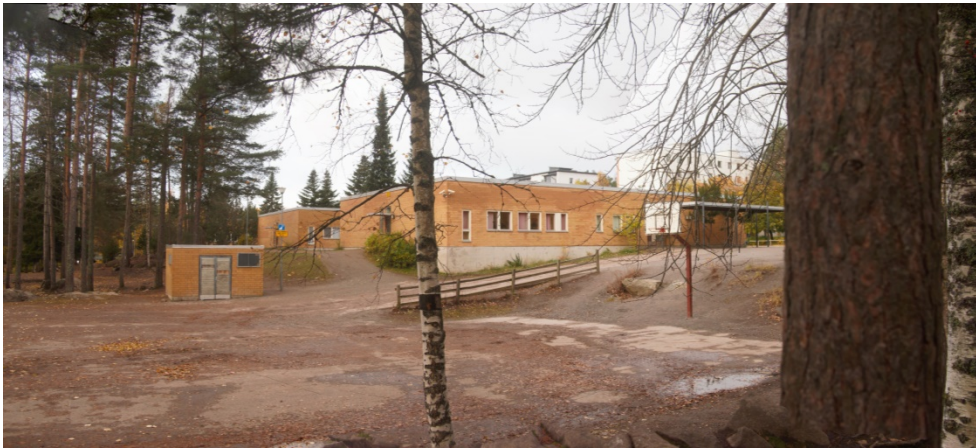
Mäkipuistosta kohti koulun itäjulkisivua.
