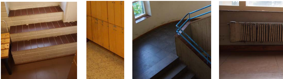
Kuvissa rakennuksen materiaaleja: maalattua tiiltä, vinylilaattaa, keraamista laattaa, mosaiikkibetonia, sekä alkuperäinen lämpöpatteri.
