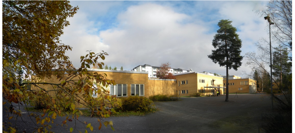
Yläkoulun puoleista pihaa rakennuksen lounaiskulmasta kuvattuna
