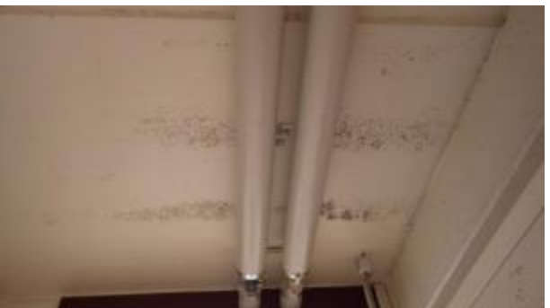
Kuvat 45 a ja b. Tiivistämättömiä reikiä ja läpivientejä yläpohjaan (a). Ontelolaattaston maali hilseilee. Rakenteessa ei todettu kohonnutta kosteutta pintakosteusilmaisimella (GANN 60) (b).
