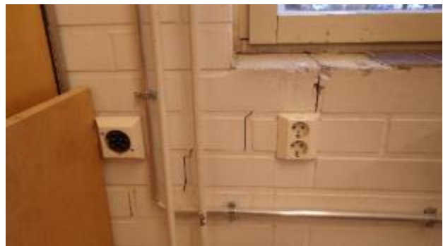
Kuvat 65 a ja b. Nuppineulataulu on vaurioitunut. Esimerkkikuva tiiliverhouksessa olevasta rakenteellisesta halkeamasta.
