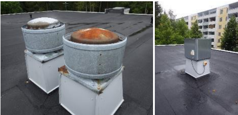
Kuvat 78 a ja b. Rakennuksessa on alkuperäisiä huippumureita (a) ja uusittuja huippumureita (b).
