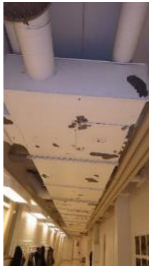
Kuvat 66 a-c. Roiskapinnoitetta turmeltu ilkivaltaisesti. Teknisen työn käytävällä maali hilseillyt iv-kanavasta ja ontelolaatasta.
