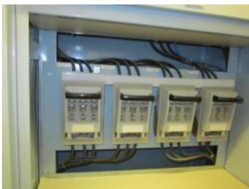
Kuva 121. Lähtöjä pääkeskuksella.
