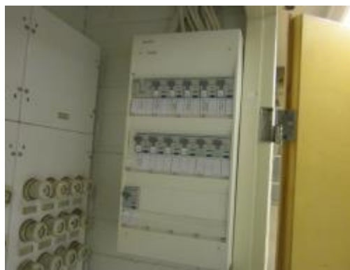
Kuva 122b. Ryhmäkeskus 109 tilaan lisätty RK 109.1 vikavirtasuojatuilla lähdöillä.
