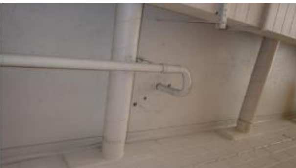
Kuvat 45 a ja b. Tiivistämättömiä reikiä ja läpivientejä yläpohjaan (a). Ontelolaattaston maali hilseilee. Rakenteessa ei todettu kohonnutta kosteutta pintakosteusilmaisimella (GANN 60) (b).
