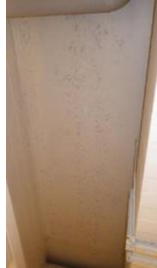
Kuvat 66 a-c. Roiskapinnoitetta turmeltu ilkivaltaisesti. Teknisen työn käytävällä maali hilseillyt iv-kanavasta ja ontelolaatasta.
