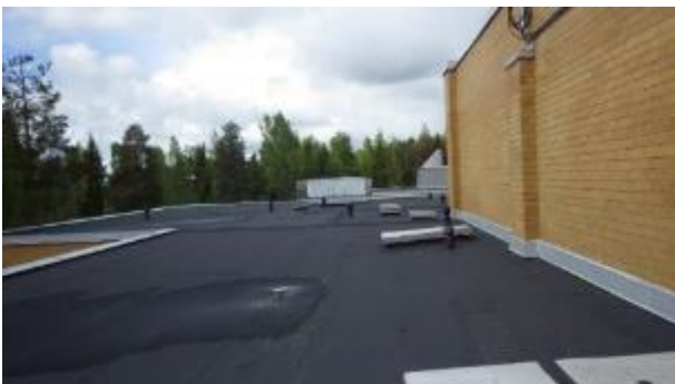
Kuva 6. Vesikatolla on sisäpuolinen sadevedenpoistojärjestelmä.
