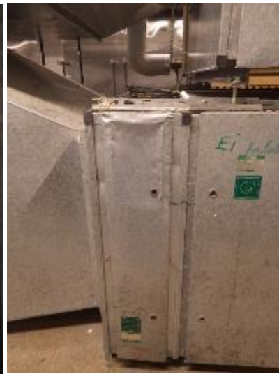
Kuvat 81 a ja b. Kaikissa suodattimissa on epätiivyyttä (a). Koneen luukut ja lukitukset ovat huonokuntoisia, joten ne ovat vaikeasti avattavissa/suljettavissa.
