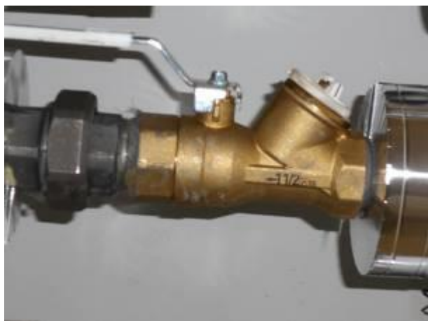
Kuvat 193 a ja b. 2015 uusittu Oraksen linjasäätöventtiili. Danfos termostaattinen patteriventtiili.
