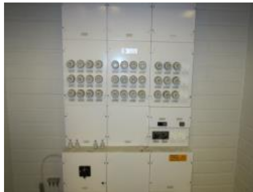
Kuva 123b. Perus ryhmäkeskus, joita kiinteistössä on.
