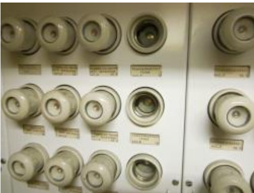
Kuva 174. Sulakekansiä puuttuu.
