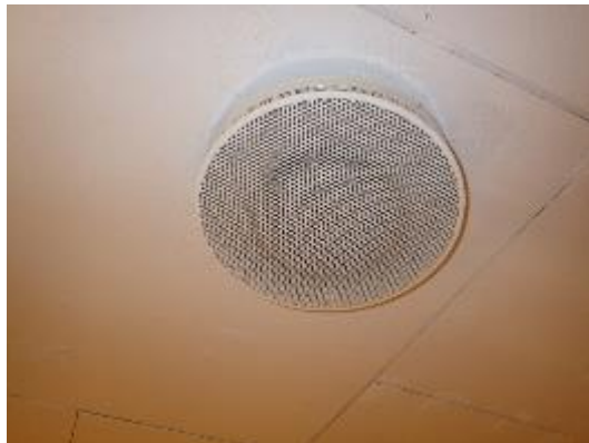
Kuvat 85 a ja b. Ilmanvaihdon runkokanavat on asennettu näkyvillä käytävien katoissa ja ovat pääasiassa suorakaidekanavia (a). Esimerkki käytävän tuloilmapäätelaitteesta (b).
