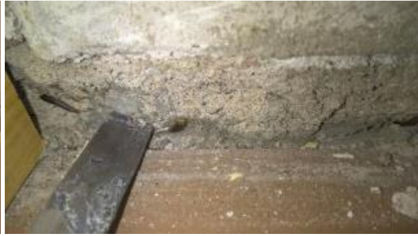
Kuvat 20 a ja b. Esimerkkinä luokan 1021 alapohjan epätiivis liittyminen ulkoseinään. Liittymässä havaittiin maakellarin hajua ja sokeritoukkia (GANN alin tiili 80-90 tarkastuskohdalla, listan yläpuolella muuten GANN: 60-70)
