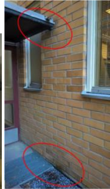
Kuva 26. Kuva luokan 1017 ulkoseinän rakenneavauksesta (a). Ko. kohdalla katokset sadevedet valuvat seinälle (b).
