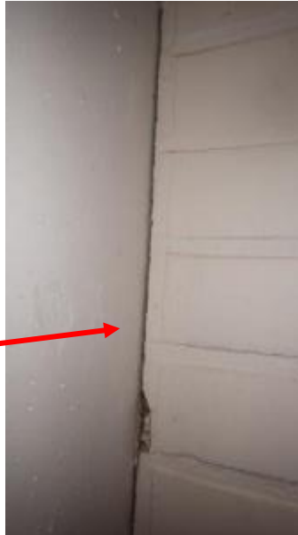
Kuvat 46 a ja b. Ulkoseinän sisänurkassa on halkeama, josta havaittiin alipainetilanteessa tulevan mikrobiperäistä hajua.
