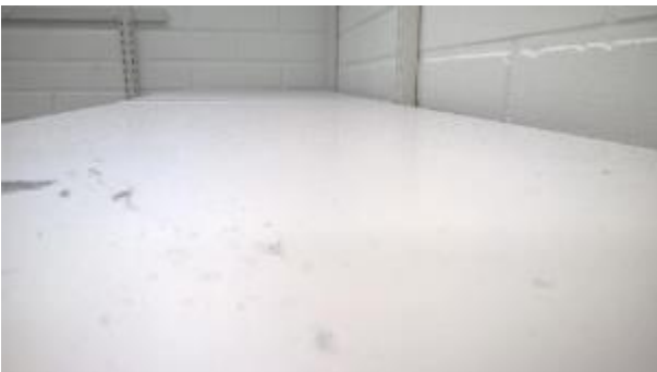
Kuvat 73 a ja b. Yläpinnoilla on runsaasti pölyä.
