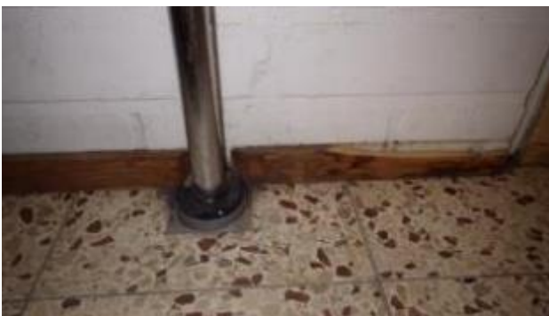
Kuvat 60 a. ja b. Puset lattialistat ovat kuluneita ja ikääntyneitä. Vesipisteiden lähellä puulistoissa näkyy kosteusjälkiä ja osin kosteuden aiheuttamia vaurioita.
