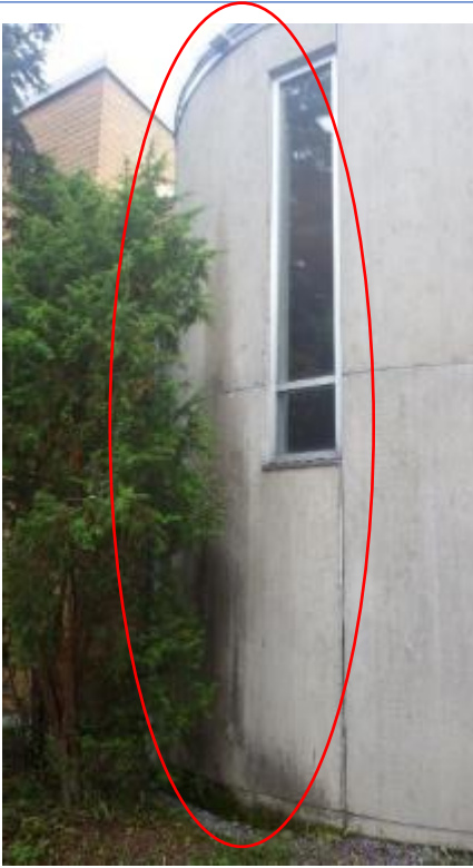
Kuvat 9 a ja b. Porraskäytävien kohdalla sadevedet laskevat suoraan vesikatolta pitäen ulkoseinustaa märkänä (a). Ko.kohdilla on sammaloitumista (b).
