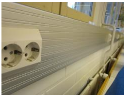
Kuva 130 b. Pistorasioita alumiinikourussa.
