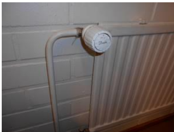
Kuvat 193 a ja b. 2015 uusittu Oraksen linjasäätöventtiili. Danfos termostaattinen patteriventtiili.
