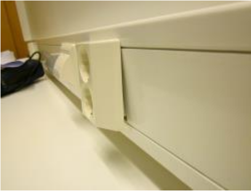
Kuva 167. Pistorasia on irrallaan kourusta.
