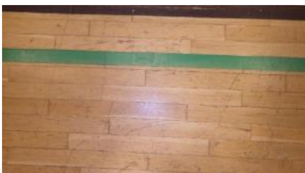
Kuvat 68 a ja b. Pienen salin lattiassa paikoin kuluneisuutta ja naarmuuntuneisuutta.
