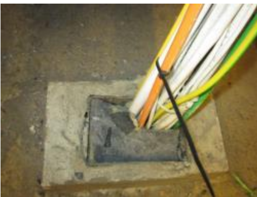
Kuva 119a. Osa läpivienneistä on tiivistetty villalla.
