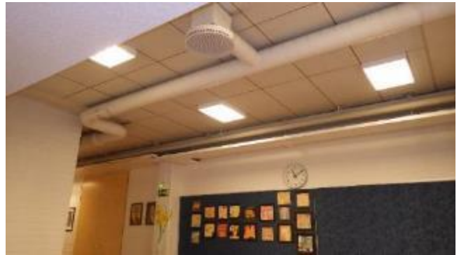
Kuvat 62 a ja b. Käytäviltä on paikoin poistettu reunapinoittamattomia akustiikkakattolevyjä. Osin kattolevyjä on yhä paikallaan.
