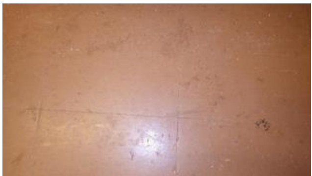
Kuvat 63 a ja b. Liikuntasaumojen kohdalla sekä teknisen työn tiloissa lattiapinnoitteessa on vaurioita.
