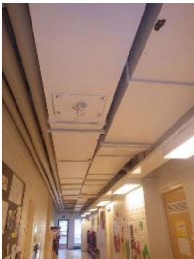
Kuvat 85 a ja b. Ilmanvaihdon runkokanavat on asennettu näkyvillä käytävien katoissa ja ovat pääasiassa suorakaidekanavia (a). Esimerkki käytävän tuloilmapäätelaitteesta (b).
