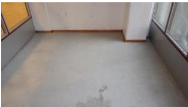
Kuvat 67 a ja b. Tuulikaapin betonin maalipinta on uusimisen tarpeessa. Yksittäisiä tiloja saneerattu pintamateriaalien osalta.
