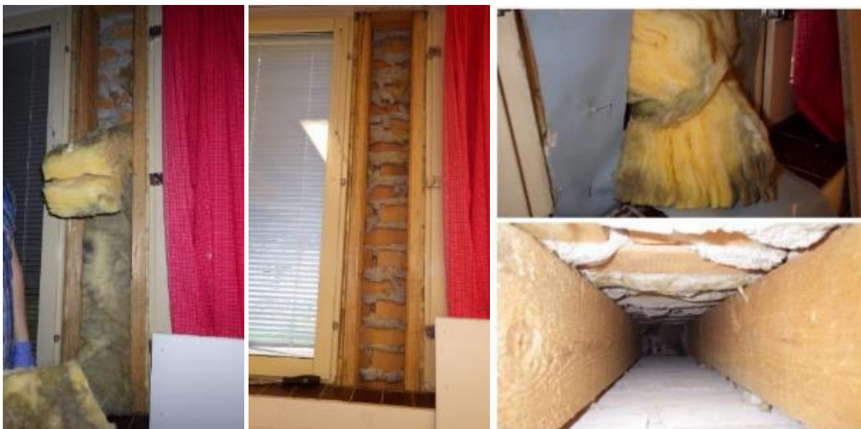
Kuvat 28 a-d. Kuvia luokan 1017 ikkunoiden välisen levytyksen avauskohdasta. Villa on tummunut ilmavuotojen seurauksesta (a ja c). Valokuva välitilasta pystysuoraan alajuoksua kohti (mineraalivilla poistettu ennen kuvan ottamista) (d).
