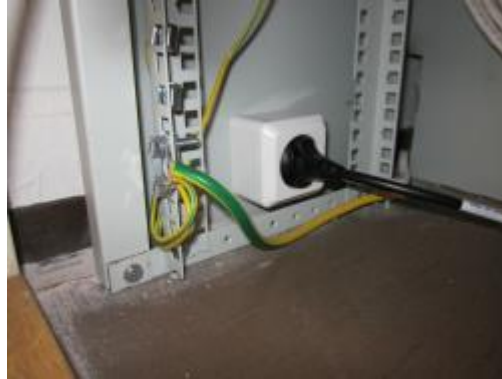
Kuva 127b. Laiteräkin maadoitus.
