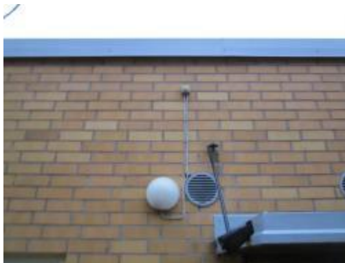
Kuva 138. Valaistusta ohjaava hämäräkytkin
