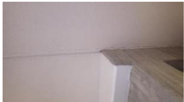
Kuvat 57 a. ja b. Ontelolaattojen saumoissa on halkeilua ja roiskarappaukseen on tullut halkeamia.
