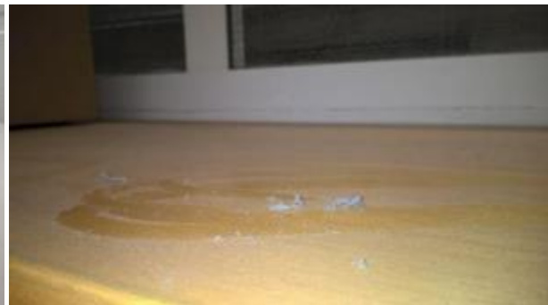
Kuvat 72 a ja b. Luokassa 1052 katossa olevien tasojen päällä on mineraalivillapintaista eristettä, joka on runsaasti pölyntynyt.
