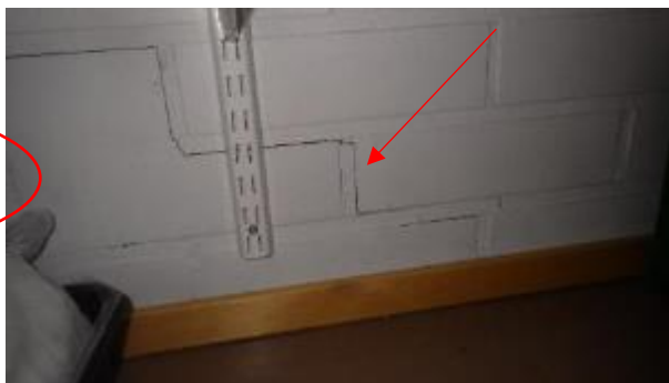
Kuvat 47 a ja b. Varastohuoneen 2052 katossa on haljennut ontelolaattasauma ja kuivunutta valumajälkeä (a). Väliseinissä on halkeamia (b).
