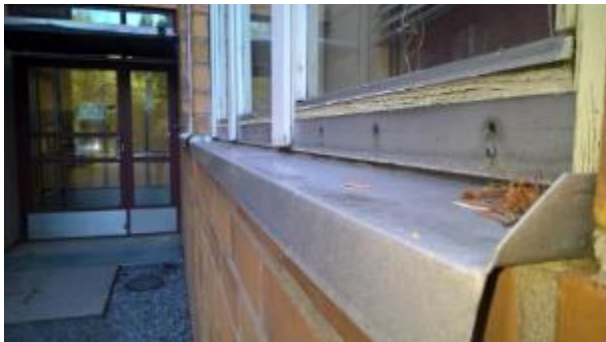
Kuvat 31 a ja b. Ikkunapellit ovat lähes tasaiset (a) ja ikkunaliitoksissa on havaittavissa epätiiveyskohtia (b).
