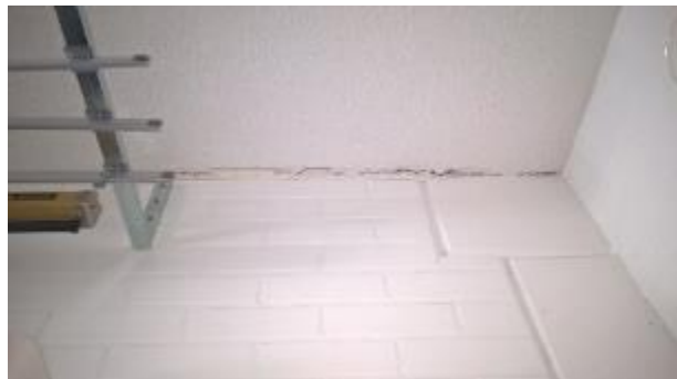
Kuvat 44 a ja b. Useissa ala-asteen luokissa yläpohjan väliseinän viereinen ontelolaattasauma on reilusti haljennut. Esimerkkinä luokka 2090B.
