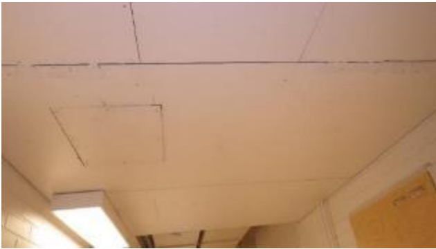
Kuvat 62 a ja b. Käytäviltä on paikoin poistettu reunapinoittamattomia akustiikkakattolevyjä. Osin kattolevyjä on yhä paikallaan.
