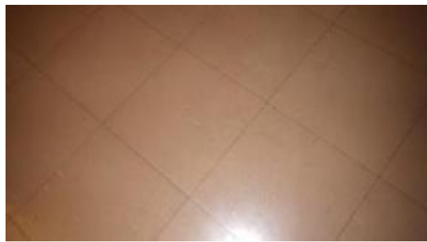
Kuvat 59 a. ja b. Lattioiden muovilaatat ovat yleisesti tyydyttävässä kunnossa. Paikoin on havaittavissa kuluneisuutta ja likaantuneisuutta.
