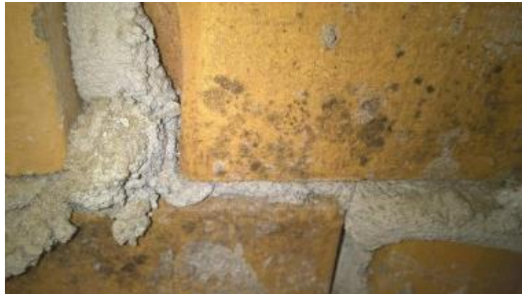
Kuvat 30 a ja b. Luokassa 2095 ikkunoiden välisen tilan ulkomuurauksen sisäpinnalla oli näkyvää mikrobitasvustoa (b).
