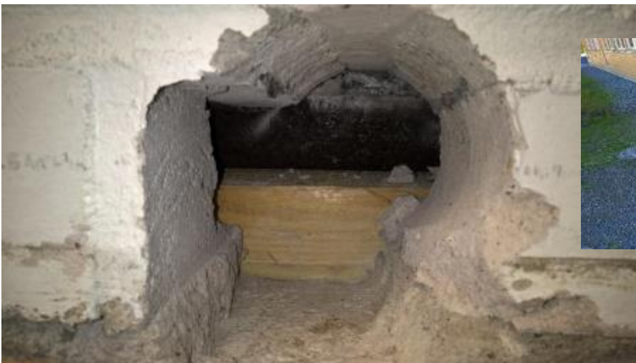
Kuva 27. Kuva luokan 2090A ulkoseinän rakenneavauksesta. Bitumikermi on käännetty alajuoksun päälle.
