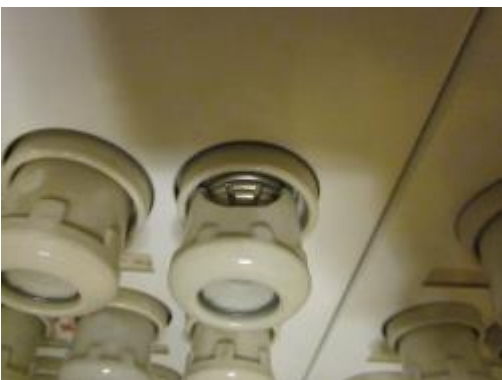
Kuva 175. Sulakekansi rikki.
