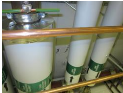
Kuva 128b. Maadoitus jatkamatta muutetuille lämpöputkille.
