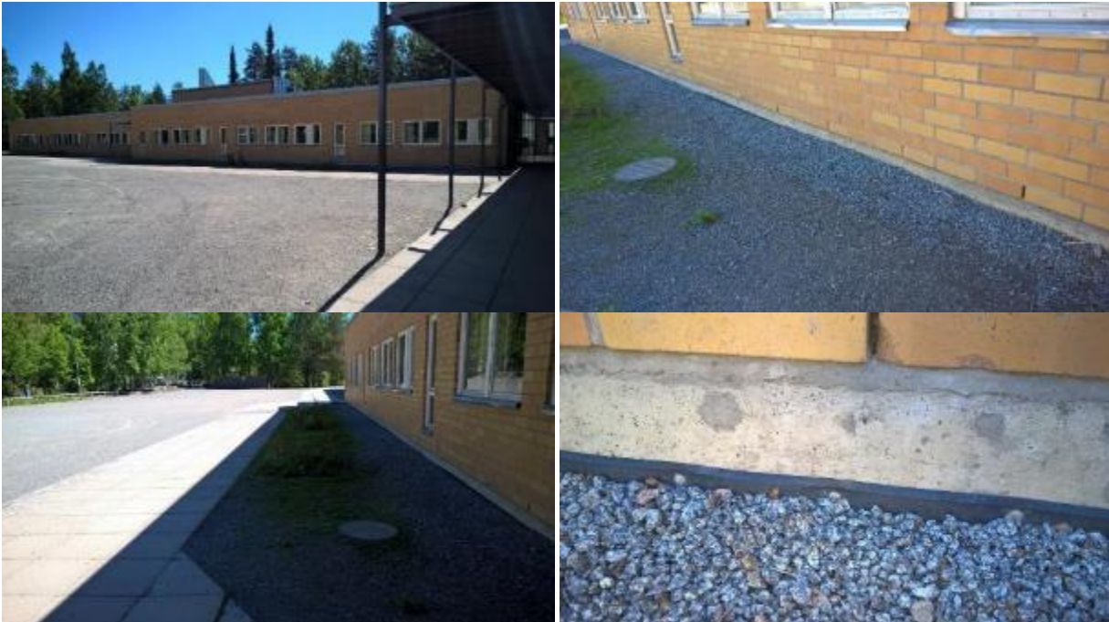
Kuvat 5 a-d. Pohjoispuolella on tasainen hiekkakenttä ja osalla rakennuksen vierustaa havaittiin perusmuurilevy.
