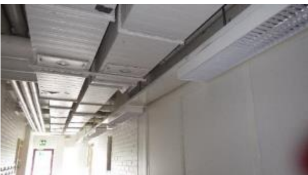
Kuvat 74 a ja b. Joillakin käytävillä on sähköjohtokouruja, ja niissä on runsaasti pölyä.
