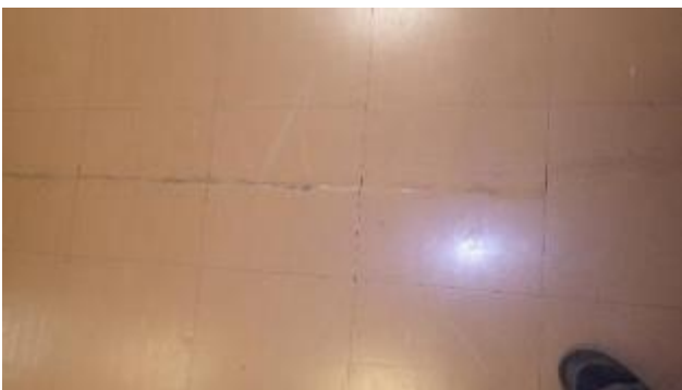
Kuvat 63 a ja b. Liikuntasaumojen kohdalla sekä teknisen työn tiloissa lattiapinnoitteessa on vaurioita.
