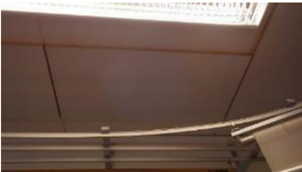
Kuvat 70 a-d. Luokkien ja käytävien katoissa on kuitulähteinä toimivia reunoittamattomia akustolevyjä.
