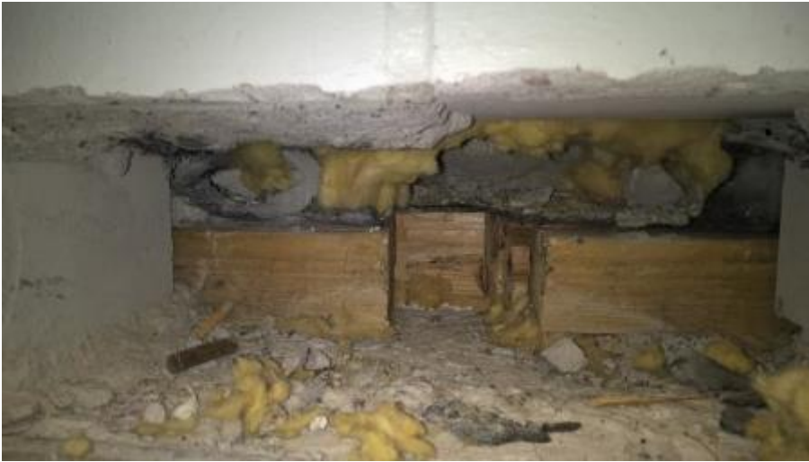
Kuva 26. Kuva luokan 1017 ulkoseinän rakenneavauksesta (a). Ko. kohdalla katokset sadevedet valuvat seinälle (b).
