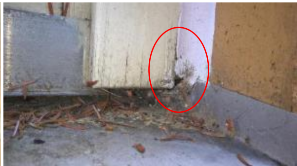
Kuvat 31 a ja b. Ikkunapellit ovat lähes tasaiset (a) ja ikkunaliitoksissa on havaittavissa epätiiveyskohtia (b).
