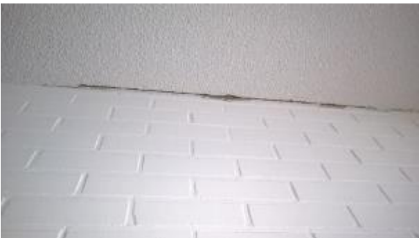
Kuvat 44 a ja b. Useissa ala-asteen luokissa yläpohjan väliseinän viereinen ontelolaattasauma on reilusti haljennut. Esimerkkinä luokka 2090B.
