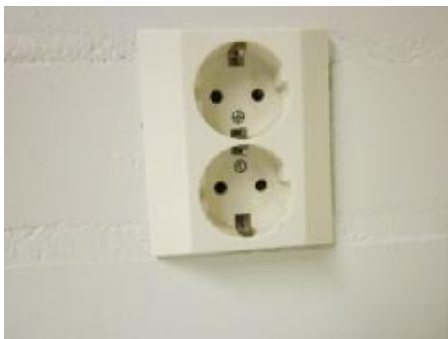
Kuva 130 a. Maadoitettu ja sulkelaitteeton pistorasia.
