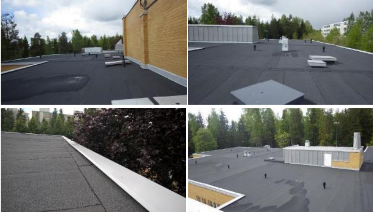
Kuvat 38 a-d. Vesikatteena toimiva bitumikermi on hyväkuntoinen (uusittu vuonna 2015).
