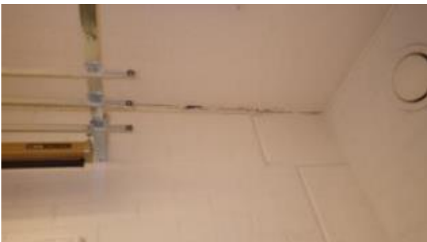
Kuvat 57 a. ja b. Ontelolaattojen saumoissa on halkeilua ja roiskarappaukseen on tullut halkeamia.
