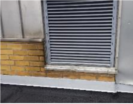
Kuvat 80. Osa raitisilmasäleiköistä on matalalla tasolla kattopintaan nähden, mikä edesauttaa lumen kulkeutumista koneeseen.
