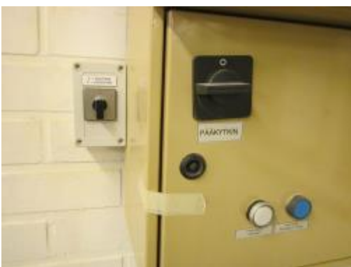
Kuva 163. Kytinkotelo on teipattu kiinni.
