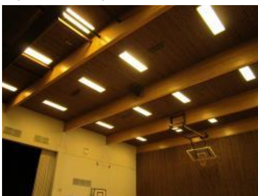
Kuva 132. Liikuntasalin loisteputkivalaisimia.
