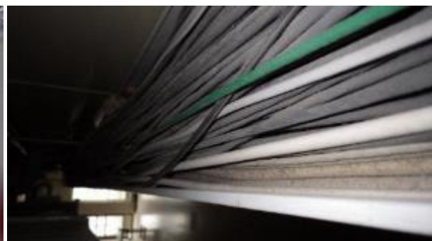
Kuvat 74 a ja b. Joillakin käytävillä on sähköjohtokouruja, ja niissä on runsaasti pölyä.
