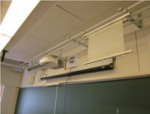
Kuva 182. Asennukset roikkuvat.
