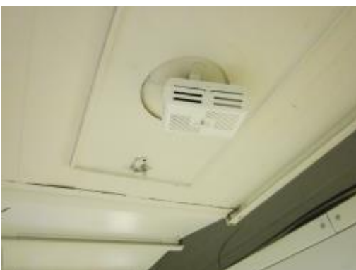
Kuva 147 a. Palovaroitin
