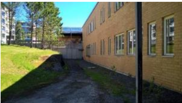
Kuvat 4 a ja b. Osittain rakennuksen pohjoispuolella maanpinta on rakennuksen lattianpintaa korkeammalla, tosin ihan rakennuksen vierellä on matalampi ja tasaisempi osuus.
