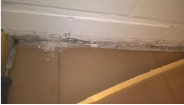
Kuvat 20 a ja b. Esimerkkinä luokan 1021 alapohjan epätiivis liittyminen ulkoseinään. Liittymässä havaittiin maakellarin hajua ja sokeritoukkia (GANN alin tiili 80-90 tarkastuskohdalla, listan yläpuolella muuten GANN: 60-70)
