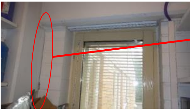
Kuvat 46 a ja b. Ulkoseinän sisänurkassa on halkeama, josta havaittiin alipainetilanteessa tulevan mikrobiperäistä hajua.
