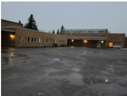
Kuva 137. Pihan valaistus on toteutettu seinä ja tolppavalaisimin.
