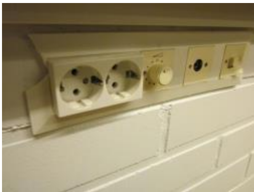
Kuva 131 a. Pistorasiat ja niiden peitelevyt alkavat olla elinkaarensa päässä.
