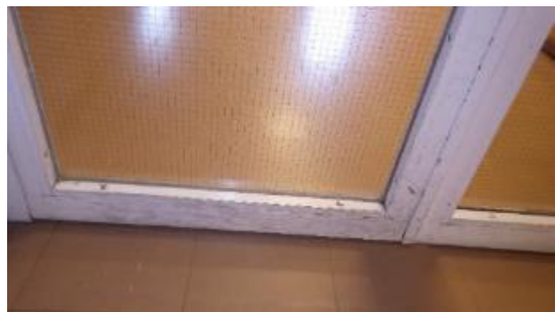
Kuvat 63 a ja b. Liikuntasaumojen kohdalla sekä teknisen työn tiloissa lattiapinnoitteessa on vaurioita.
