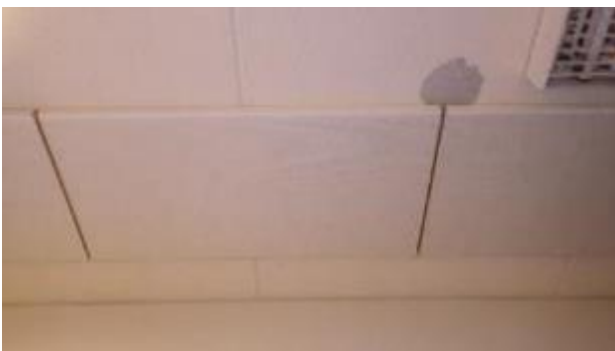
Kuvat 58 a. ja b. Joitakin reunapinoittamattomia akustiikkalevyjä on uusittu, mutta pääosa on uusimatta.
