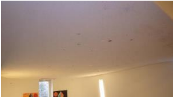
Kuvat 66 a-c. Roiskapinnoitetta turmeltu ilkivaltaisesti. Teknisen työn käytävällä maali hilseillyt iv-kanavasta ja ontelolaatasta.
