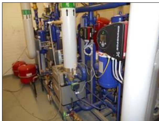
Kuva 192. Lämmönsiirrinpaketti.
