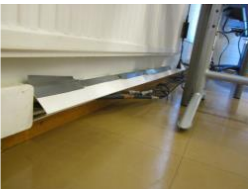
Kuva 184. Kouru on kiinnitetty teipillä.
