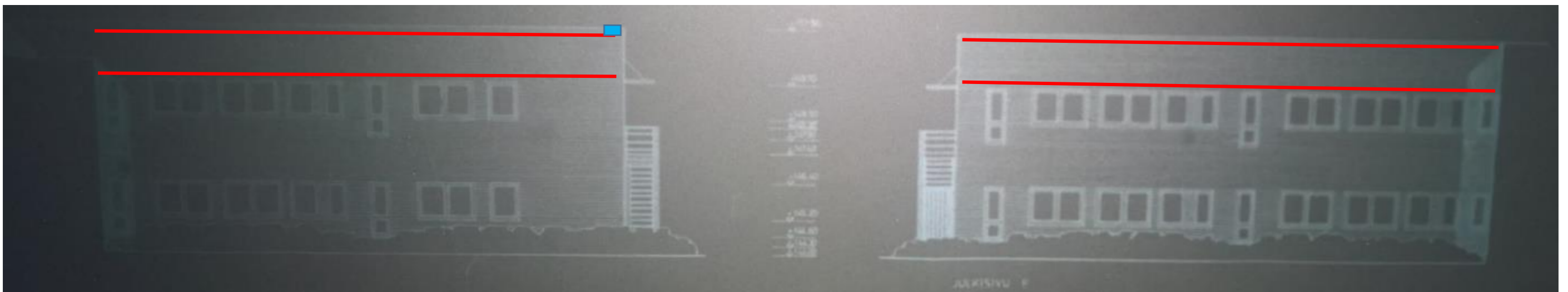
Havaintoja lounas- ja koillisjulkisivuilta. Punaisilla viivoilla on merkitty halkeamat tiiliverhouksen laastisaumoissa
