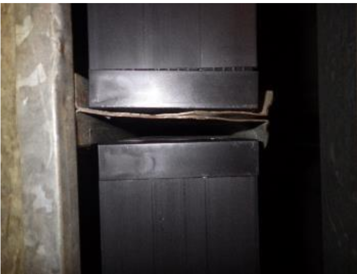
Kuvat 81 a ja b. Kaikissa suodattimissa on epätiivyyttä (a). Koneen luukut ja lukitukset ovat huonokuntoisia, joten ne ovat vaikeasti avattavissa/suljettavissa.
