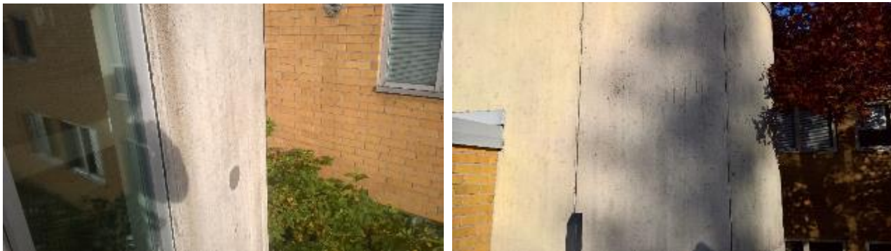
Kuvat 34. a. ja b. Yleiskuvia kaarevista betonijulkisivuista.
