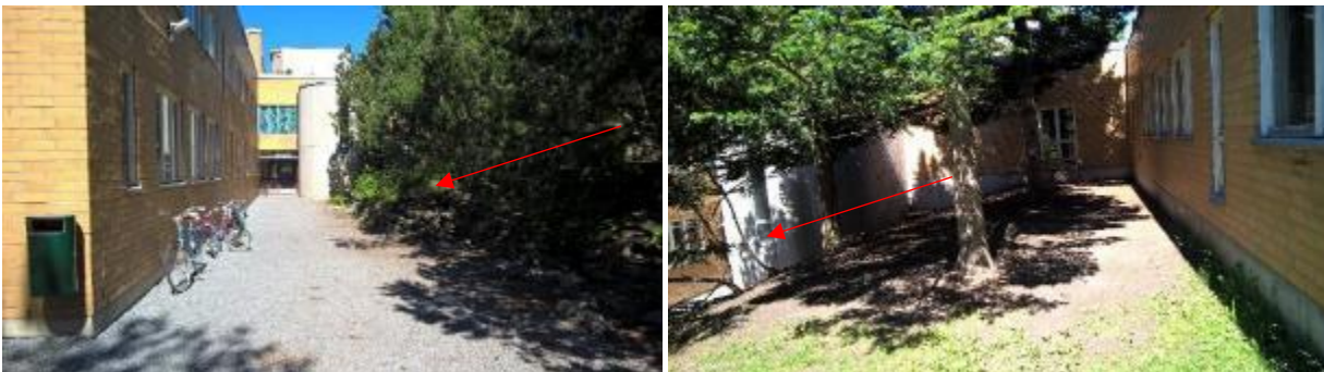
Kuvat 3 a ja b. Rakennuksen eteläpuolella maanpinta viettää osittain kohti rakennusta. Rinteen alla sijaitsevat alasteen alemman kerroksen luokat.
