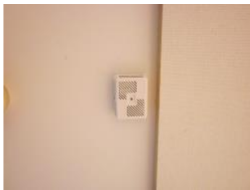
Kuva 147 b. Palovaroitin
