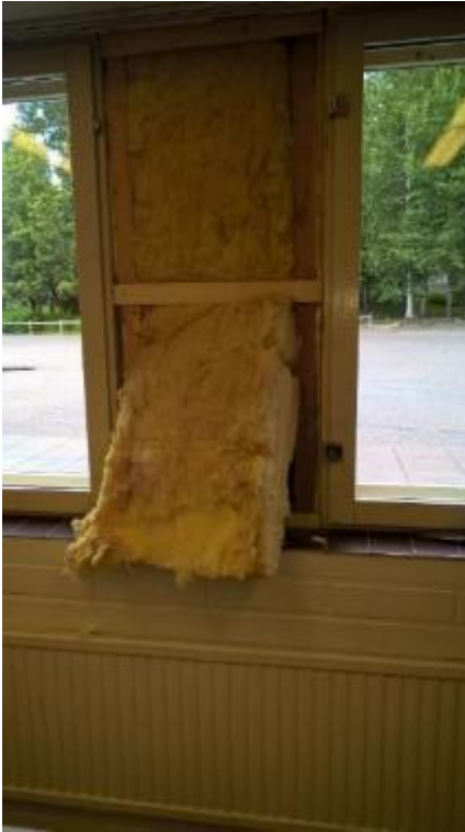
Kuvat 30 a ja b. Luokassa 2095 ikkunoiden välisen tilan ulkomuurauksen sisäpinnalla oli näkyvää mikrobitasvustoa (b).
