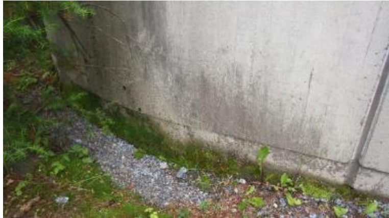
Kuvat 9 a ja b. Porraskäytävien kohdalla sadevedet laskevat suoraan vesikatolta pitäen ulkoseinustaa märkänä (a). Ko.kohdilla on sammaloitumista (b).
