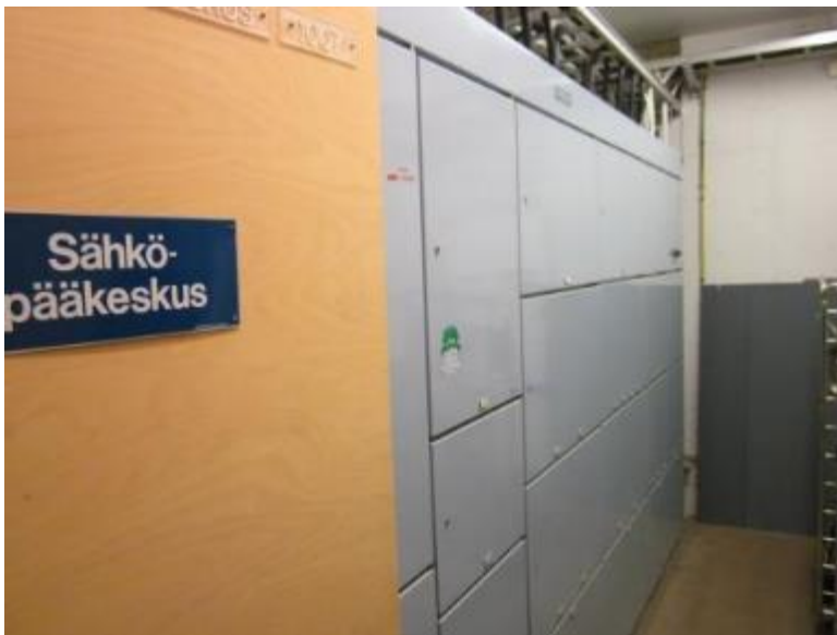
Kuva 120. Pääkeskus on Tatekan valmistama kennokeskus vuodelta 1982.
