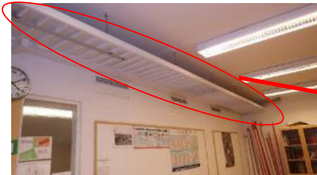
Kuvat 72 a ja b. Luokassa 1052 katossa olevien tasojen päällä on mineraalivillapintaista eristettä, joka on runsaasti pölyntynyt.
