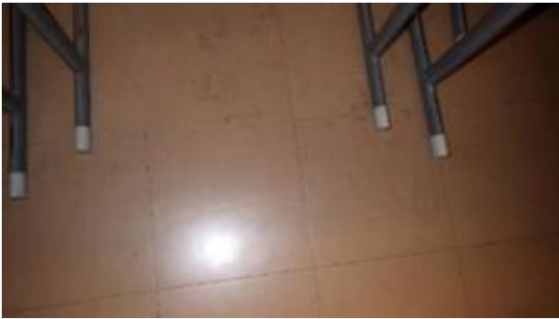
Kuvat 59 a. ja b. Lattioiden muovilaatat ovat yleisesti tyydyttävässä kunnossa. Paikoin on havaittavissa kuluneisuutta ja likaantuneisuutta.
