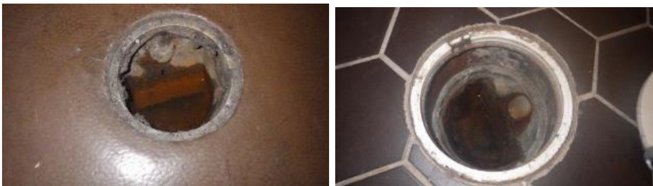
Kuva 47 a. ja b. Yleiskuvat lattiakaivoista
