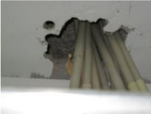
Kuvat 155 a. ja b. Epätiivitä läpivientejä välipohjien läpi.
