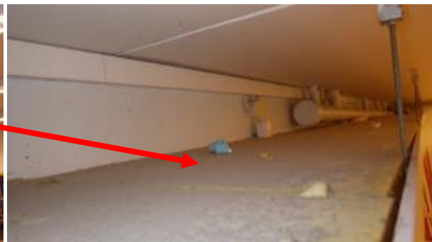
Kuvat 72 a ja b. Luokassa 1052 katossa olevien tasojen päällä on mineraalivillapintaista eristettä, joka on runsaasti pölyntynyt.
