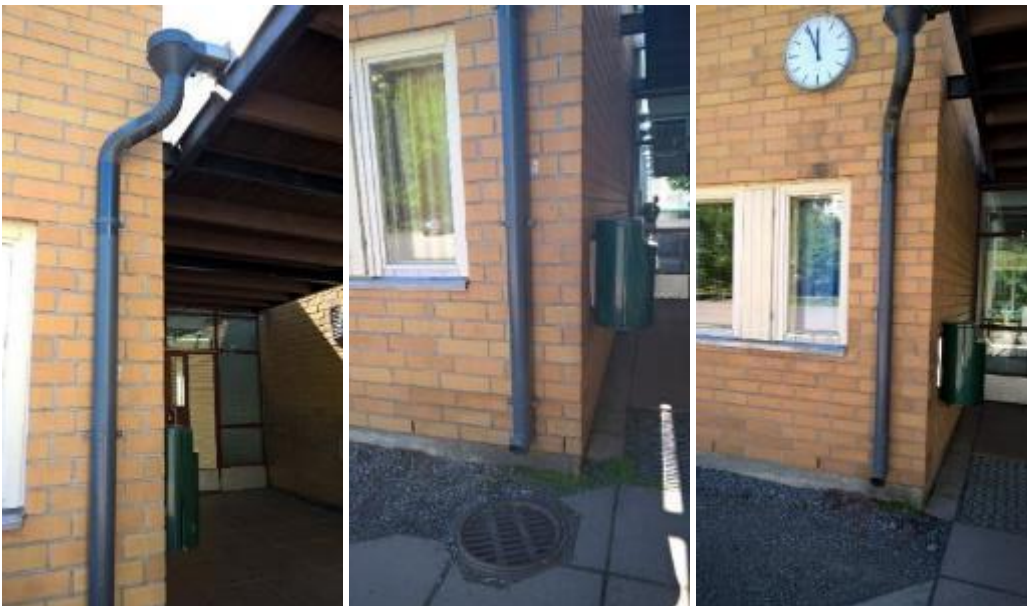
Kuvat 8 a-c. Katosten sadevedet on ohjattu syöksytorvea pitkin sadevesikaivoon (a ja b). Joissain kohdissa vesi on johdettu rakennuksen vierelle (c).
