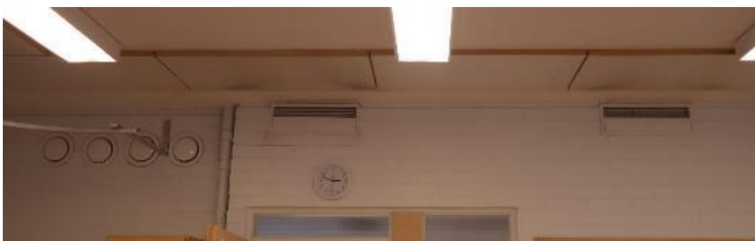
Kuva 87. Esimerkki luokkien päätelaitteista.
