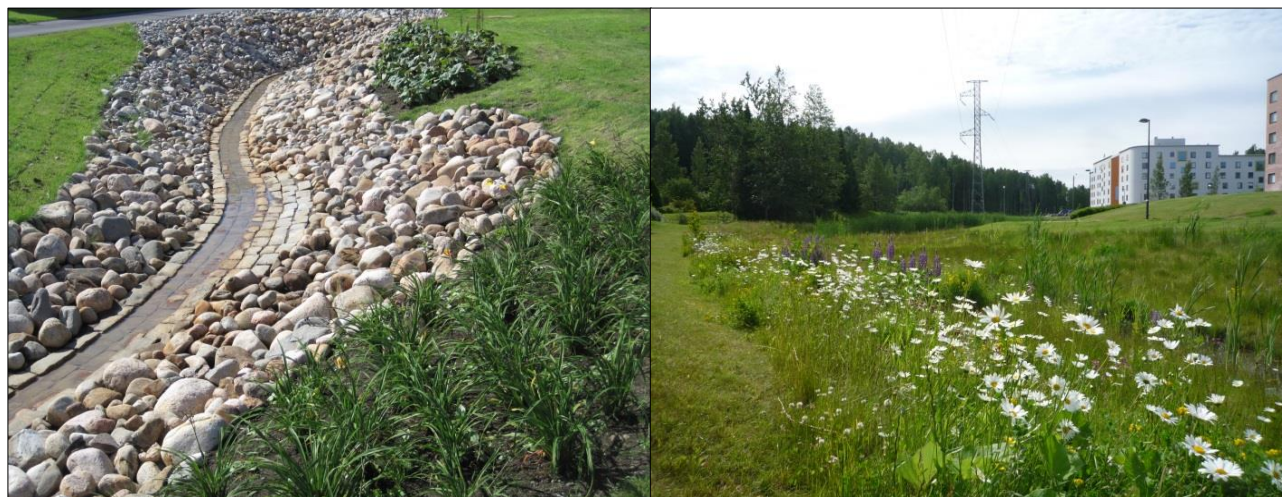
Kuva 15. Vasemmalla Kokkolan asuntomessualueen kivipuro (suunnittelu ja kuva FCG). Oikealla Vantaan Kolmikallionpuiston viivyttävä hulevesipainanne kukkaniittyineen (suunnittelu ja kuva FCG).
