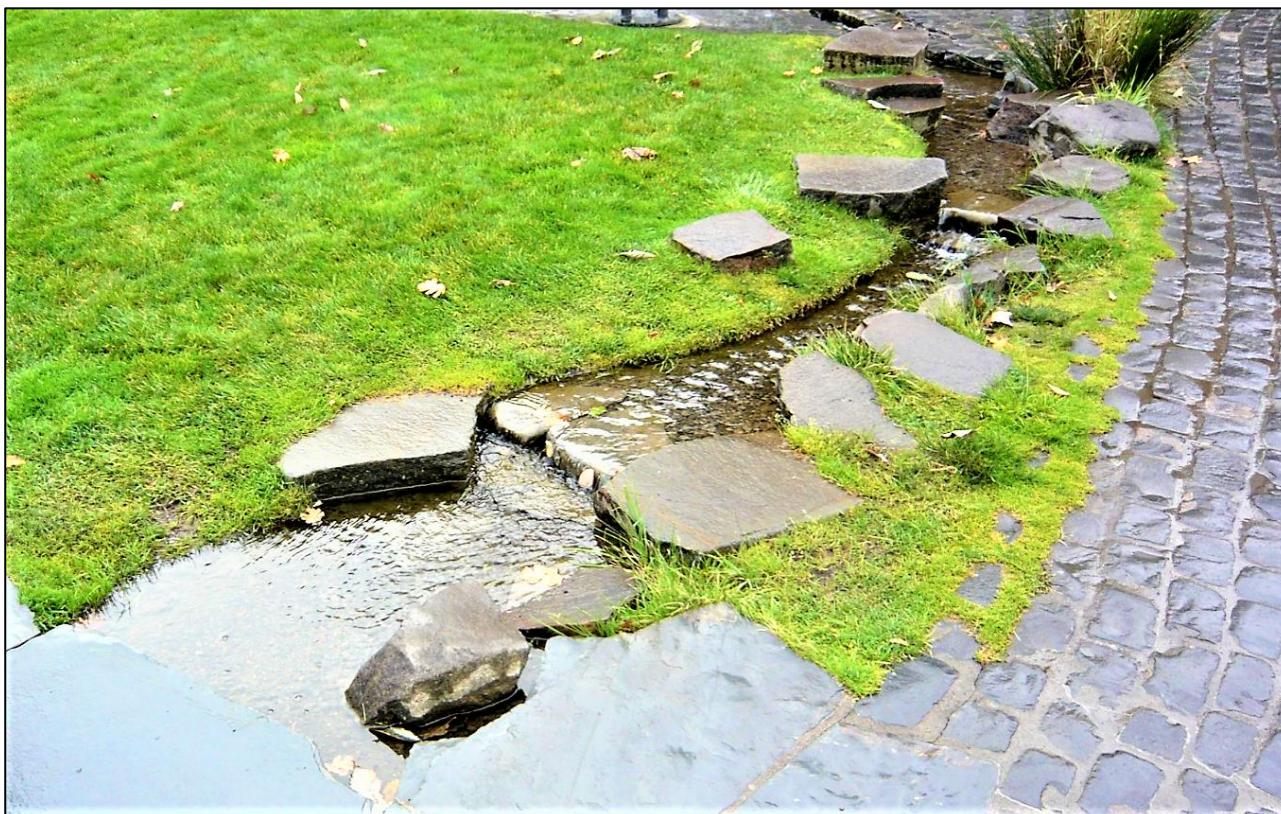
Kuva 18. Hulevesien johtamista varten suunniteltu esteettinen porrastettu rakenne (FCG).
