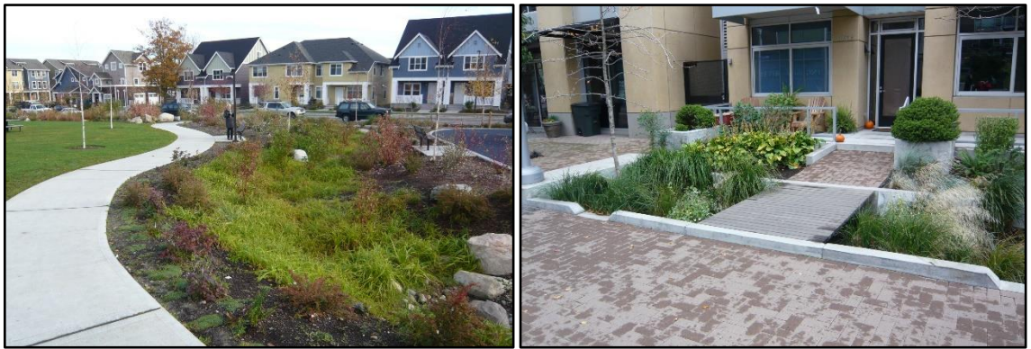
Kuva 5 Hulevesien viivytykspainanteita (Seattle, Portland Yhdysvallat).
