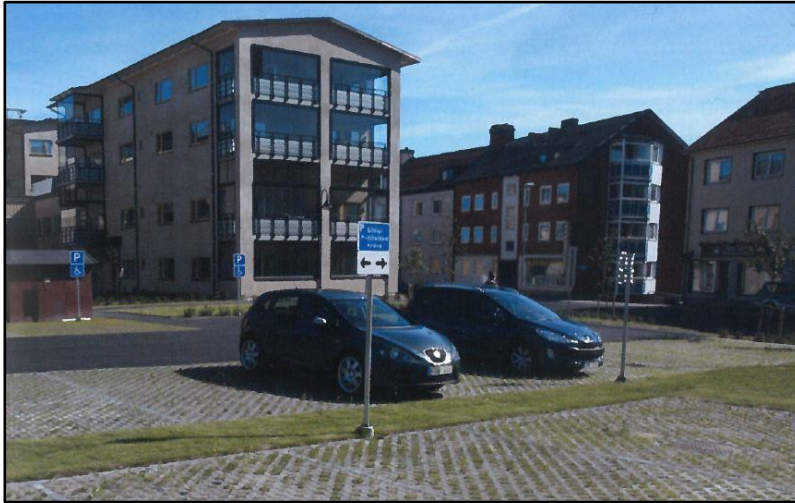
Kuva 9 Lämpäisevän päällysteen käyttö pysäköintialueella (Benders, Ruotsi).
