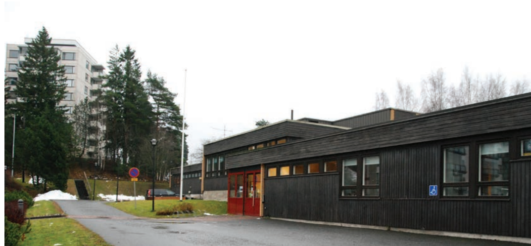
Rakennuksen pääsisäänkäynti ja julkisivu pohjoiseen.
