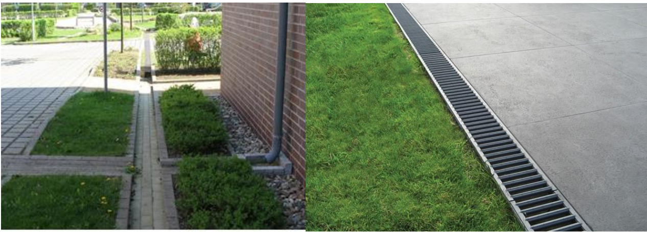
Kuva 3. Hulevesien johtaminen pinnalla avonaisilla kouruilla ja linjakuivatuskouruilla 6 .
