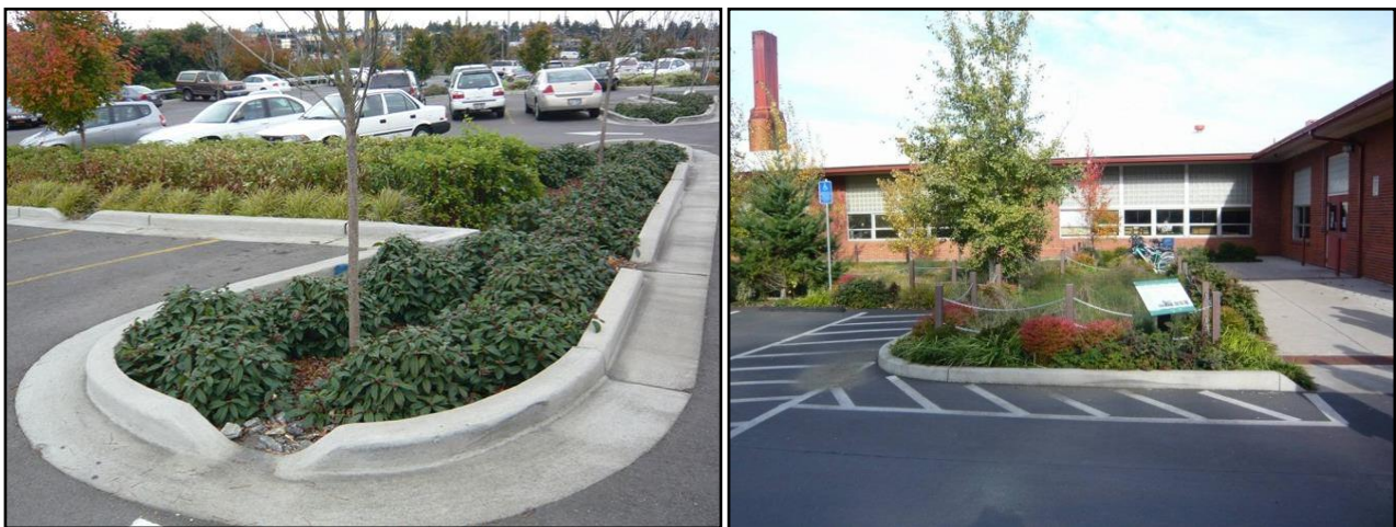
Kuva 4. Pysäköintialueen ja rakennuksen läheisyydessä olevat viherpainanteet.
