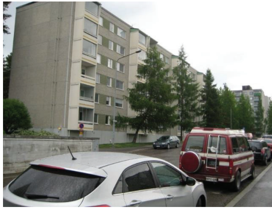
Näkymä pohjoisosan Orivedenkadulta, jossa näkyy Keinupuistokeskuksen kellarin johtavan rampin kaiteet.
