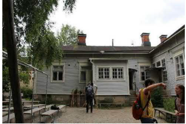
Asunnot vuosilta 1932-1973, sisäpiha, Makasiininkadun sivu Kuvattu pohjoisesta Miia Ryttyläinen
