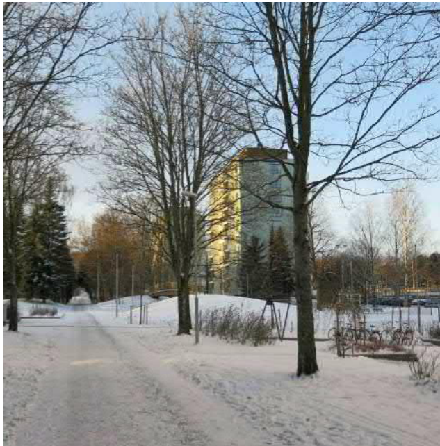
KYY 172 : 20 Amurin pohjoislaidan korkean rakentamisen aluetta. Keskellä Väinö Linnan puistoa, jonka takana kohoaa As. Oy Näsiniemen 9-kerroksinen asuinrakennus. Kuvan oikeassa laidassa polkupyöriä As. Oy Näsinaurin pihassa. . Mirkku Haapasaari 15.12.2015
