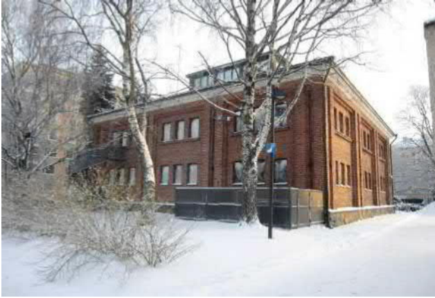
KYY 172 : 105 Tampereen taidemuseon takajulkisivua luoteesta kuvattuna. Talon nurkalla jäteaitaus. Kuvan oikeassa reunassa sivurakennuksen nurkkaa. Mirkku Haapasaari 16.01.2016
