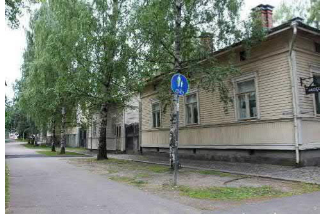
Asunnot vuosilta 1882-1899, Mariankadun suuntaan Kuvattu koillisesta Miia Ryttyläinen
