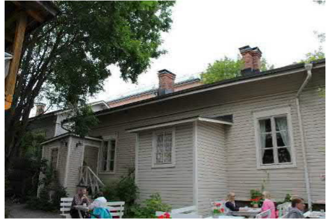
Amurin Helmen sisäpiha Kuvattu koillisesta Miia Ryttyläinen
