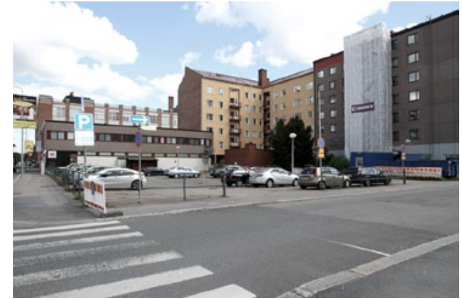
Pinninkadun ja Kullervonkadun risteyksessä on autoilijoita palvelevat laajat näkymät. Katu- ja piha-alueen rajat eivät ole helposti havaittavissa.
