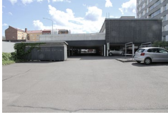
Asunto Oy Metammeloiden Pinnikadun puoleinen piha on lähes kokonaan pysäköintikäytössä. Vasemmassa reunassa päiväkodin leikkiapiha autohallin päällä.
