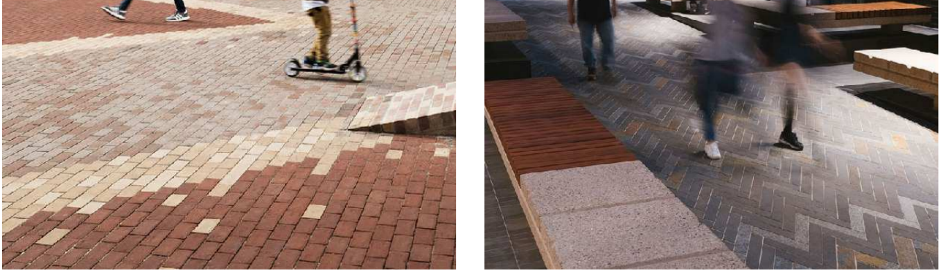
Betonikiveys ja maatiili voivat lomittua esimerkiksi selkeästi asteittain tai maatiili voi sirotta betonikiveyksen joukkoon. Vasen kuva: http://landezine.com/index.php/2019/05/toyen-square-by-grindaker Oikea kuva: Simon London ( http://landezine.com/index.php/2018/08/steam-mill-lane-by-aspect-studios/ )
