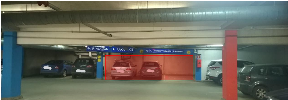
Kuva 16, Liitoskohta Tullintorin pysäköintilaitoksessa
