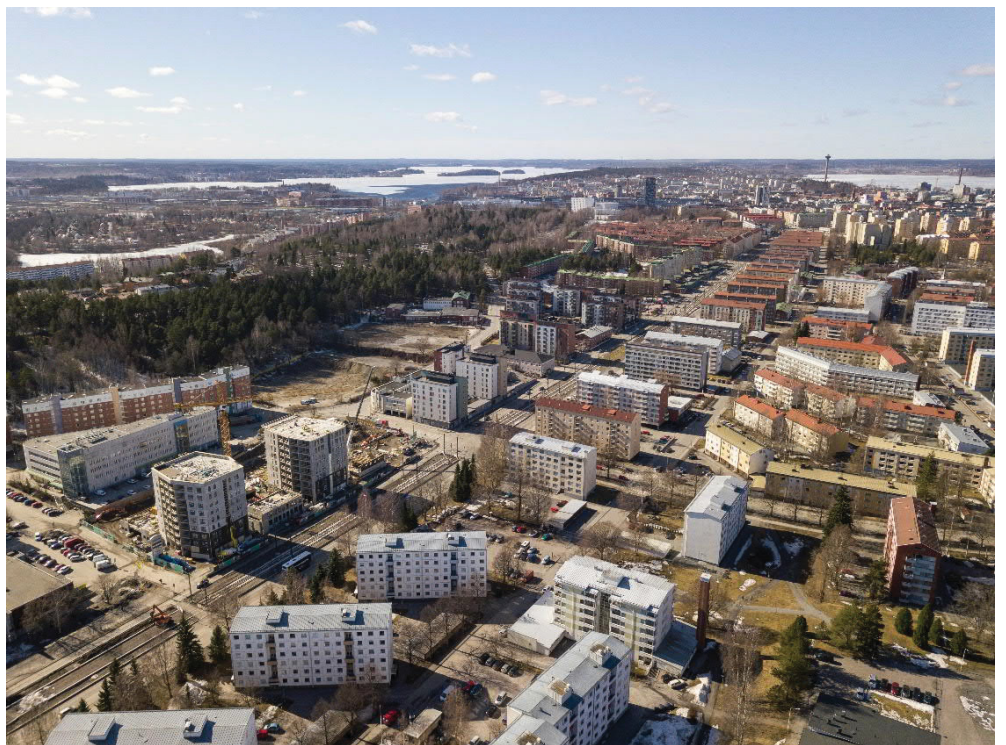
Kuva 6 Alueen tonttien valmistelu ja rakennuskannan purkaminen on aloitettu 2018-19. Dronekuva 2019
