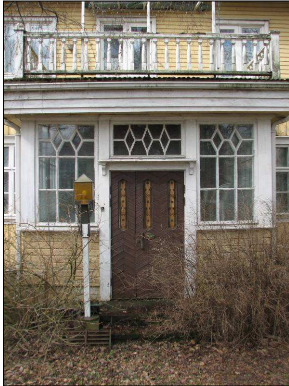
Kuva: Jankan raitin puoleinen lasikuisti, nuorempia osia edustavat 1950-luvun terassi ja 1970-luvun ovi.
