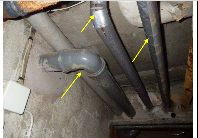
37. Käyttövesijohtoja ja viemäreitä on uusittu
