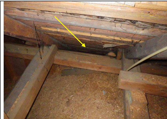
19. Tuuletusrakoa purueristyksen ja vesikatteen aluslaudoituksen välissä
