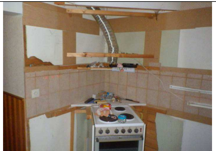
28. Yläkerran asunnon keittiötä on osin purettu
