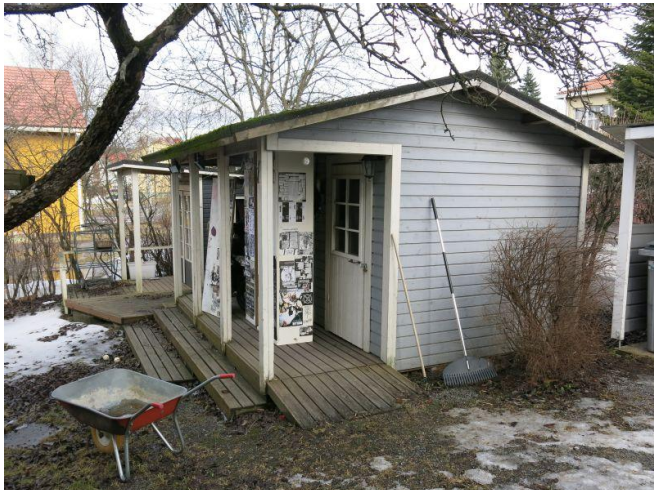
kyy 247 : 191 Jokipohjantie 14 piharakennus lounaasta Miia Hinnerichsen 15.03.2017
