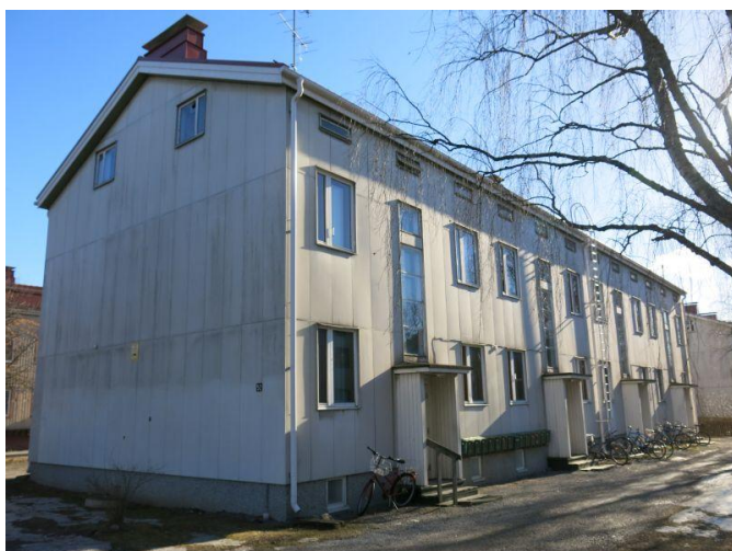
kyy 247 : 263 Nekalantie 52 kerrostalo pohjoisesta Miia Hinnerichsen 16.03.2017
