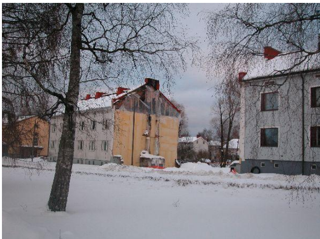
KYY 2 : 62 Lounaantie 10:n palanut puukerrostalo Miinu
