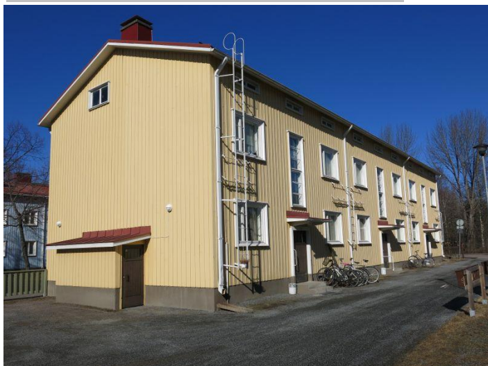
Nekalantie 64 kerrostalo etelästä
