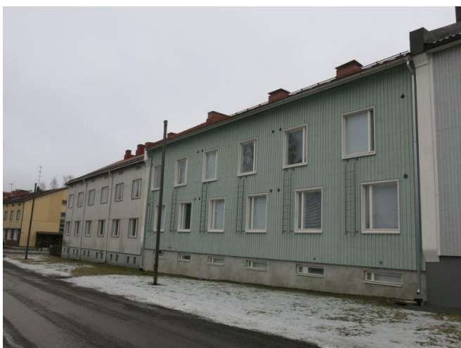
kyy 247 : 230 Riihitie 2 kerrostalo lännestä. Vihreäksi maalattu osa rakennettu 2012 tulipalossa tuhoutuneen tilalle. Miia Hinnerichsen 14.03.2017
