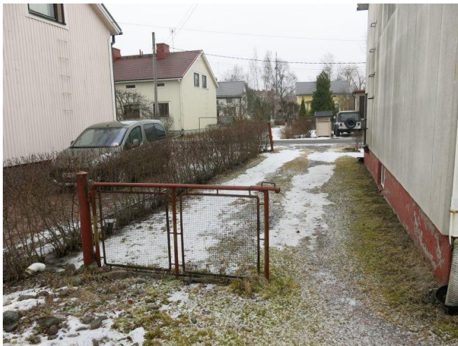
ky 247 : 182 Esantie 5 pihaan johtavat metalliputkiportit Miia Hinnerichsen 14.03.2017
