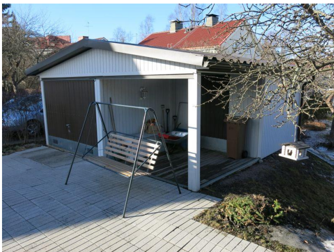
kyy 247 : 213 Kuokkamaantie 45 autotallirakennus kaakosta Miia Hinnerichsen 15.03.2017
