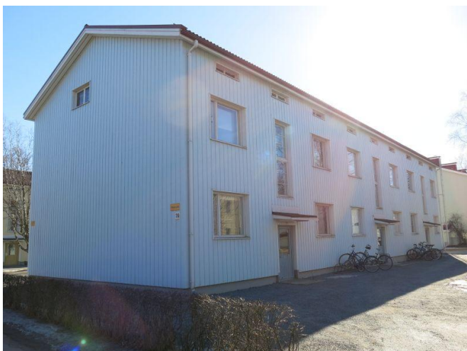
kyy 247 : 303 Nekalantie 70 kerrostalo pohjoisesta Miia Hinnerichsen 20.03.2017
