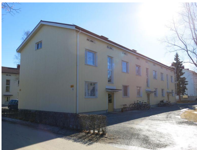
kyy 247 : 304 Nekalantie 72 kerrostalo pohjoisesta Miia Hinnerichsen 20.03.2017
