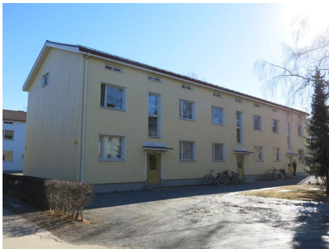
kyy 247 : 302 Nekalantie 68 kerrostalo pohjoisesta Miia Hinnerichsen 20.03.2017
