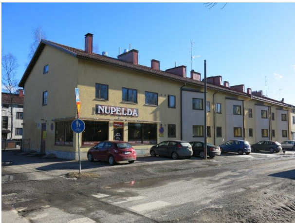
1940-luvun lopussa rakennettu tiilirunkoinen rapattu kerrostalo, jossa on pohjakerroksessa liiketiloja ja julkisivussa alueelle poikkeukselliset erkkerit.
