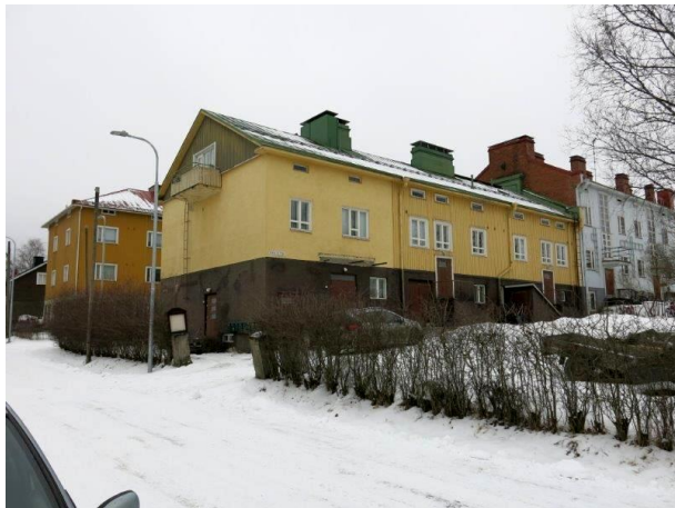
Entinen tehdas- ja asuinrakennus Ahotien ja Lounaantien kulmauksessa on rakennettu 1930-luvulla ja laajennettu 1950-luvulla.
