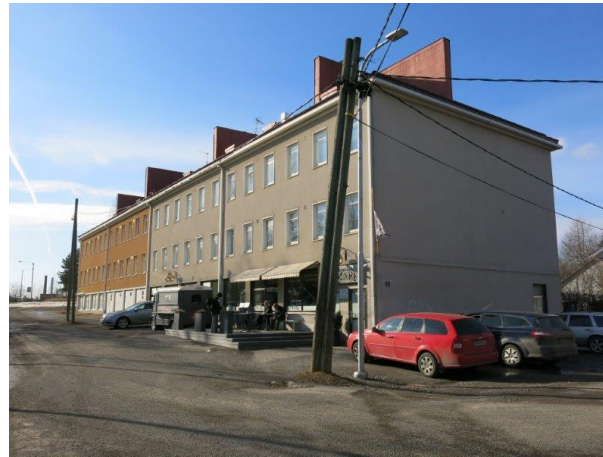
Tiilirunkoiset 1930-luvun lopussa valmistuneet kerrostalot on rakennettu kiinni toisiinsa. Molempien pohjakerroksessa on liiketiloja.
