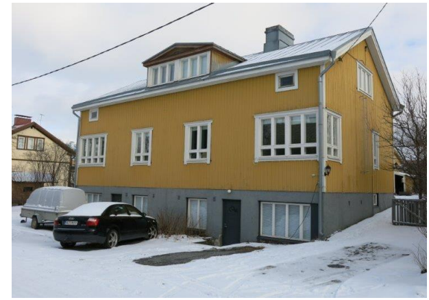
1936–37 rakennetussa paritalossa Erätiellä on orastavan modernismin piirteitä, kuten kulmaan sijoitetut ikkunat ja räystästä alas asti yhtäjaksoinen julkisivulautoitus.
