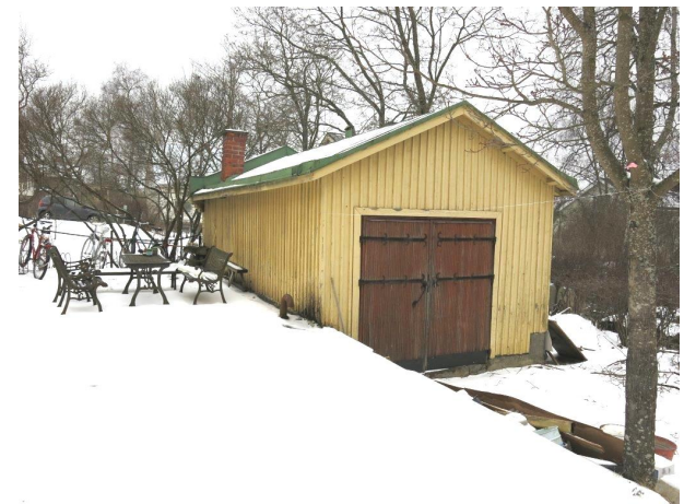
Entisen tehdas- ja asuinrakennuksen pihassa oleva 1930-luvun lopussa rakennettu autovaja. (inv. nro 6.)
