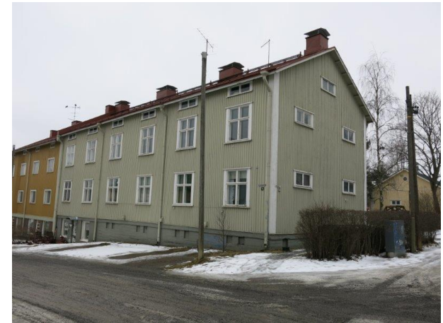
1930-luvun lopun puukerrostalossa Erätien ja Lounaantien kulmauksessa on säilynyt alkuperäiset risti-ikkunat.
