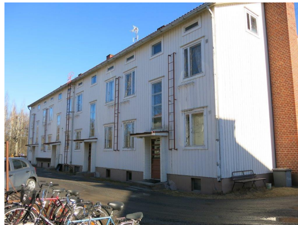
1940-luvun puukerrostalo Nekalantien laidassa on keskuslämmityspiipun lisäämistä lukuun ottamatta säilyttänyt erinomaisesti alkuperäisen ilmeensä ja rakennusmateriaalit.
