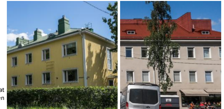
Lunetti-ikkuna ja pieni pulpettikattoinen ikkuna kerrostalojen katoilla.
