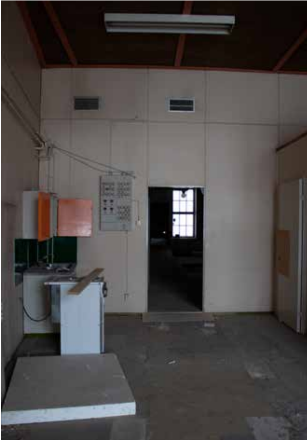
Viimeisimmän rakennusvaiheen tilanjakoa. Huomaa minikeittiö, sähkötaulu, matala toimistokoppi, ilmanvaihtoventtiilit, alakaton levytykset maalattuine saumalistoineen ja loisteputkivalaistus, kvartsiivinyyliälämaalattia.
