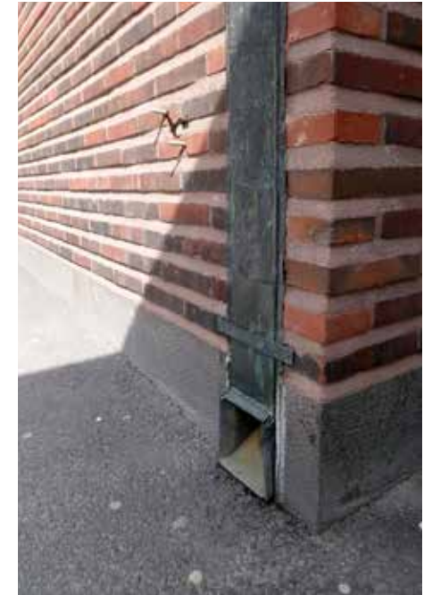
Julkisivun tiilimurausta, jossa kapeat pystysaumot ja korkeat vaakasaumat tekevät julkisivuun hienon struktuurin. Rakennusmassojen selkeyttä korostavat seinään upotetut syöksytorvet, jolloin rakennuksen nurkat jäävät "vapaiksi" ja teräviksi.
