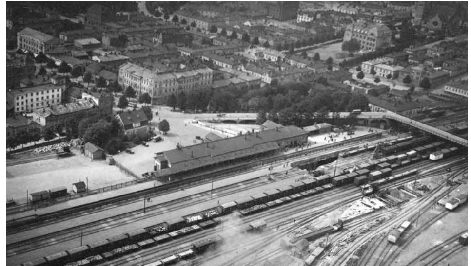
Asema, ratapiha ja Tammelan silta vuonna 1933 juuri ennen vanhan aseman purkamista. Kulku välilaiturille on Tammelan sillan vierestä, reunimmaisen radan yli tasossa. Aseman edustan aukio nousee loivasti kohti asemaa. Kuvassa radan alikulktunnelia on jo alettu kaivaa. Kuva Museokeskus Vapriikki.
