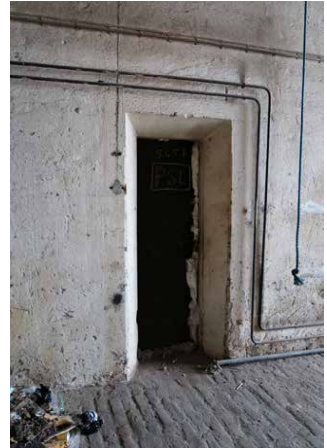
Ovisyvennys pilttuu 5:een. Oven viereen on jäänyt jälki aieman käyttövaiheen valokatkaisijasta.
