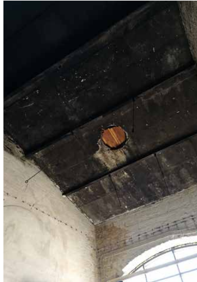
Pyöreä reikä katossa ilmeisesti konekäytön savunpoistoa varten. Vastaava reikä löytyy pilttuu 3:n katosta, jossa on myös nokeentunut kattolaudoitus.
