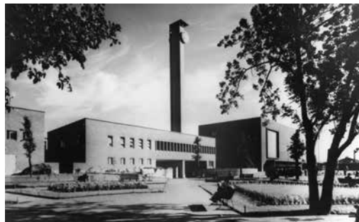
Vasemmalla kilpailuvaiheen julkisivu. Iso ikkuna on pohjoiseen ja valtava kello on pääjulkisivun katseenvangitsija. Pääsisäänkäynti on paikoillaan, mutta "kehys" on vain oven ympärillä kun se lopulta ulottui koko näyteikkunarivistön ylle. Ravintolan ikkunarivistö oli jo valmiina kilpailuvaiheessa. Torni tuli mukaan vasta jatkosuunnittelun myötä. Piirros Arkkitehti-lehti 2/1934 ja valokuva Vapriikin kuva-arkisto.
