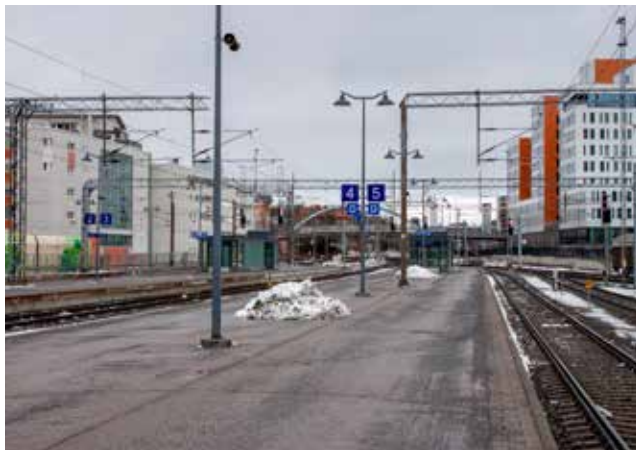
Näkymä pohjoiseen, Rongankadun tunnelin porras- ja hissikatokset.
