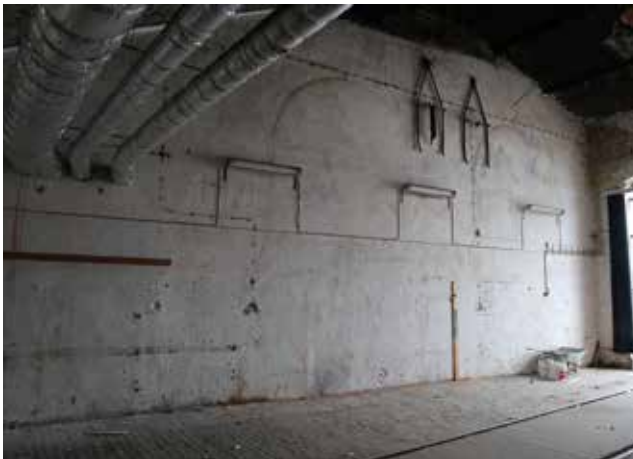
Etelänpuoleinen seinä. Uusi lämpölinja vanhan holviaukon muuratun yläosan kautta. Loisteputkivalaistus seinillä.
