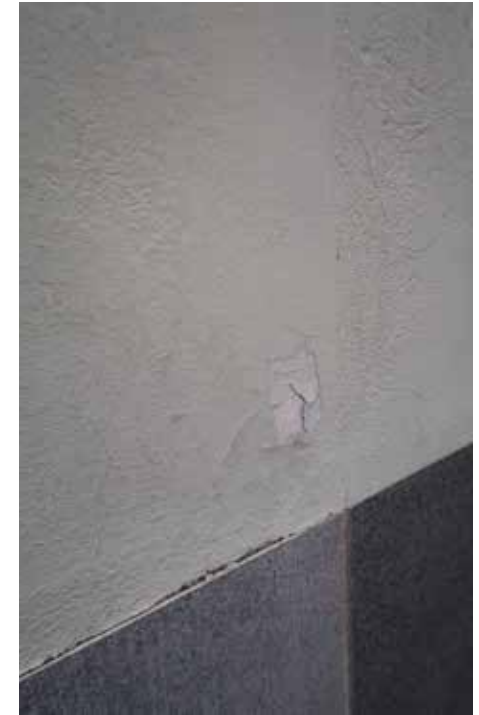
Laiturin puolella on julkisivussa jäljellä rappaus, mutta sen sävy on vaalean vihreä. Hilseilevän vihreän maalin alta näkyy paikoin vanha vaalea kalkkimaali.
