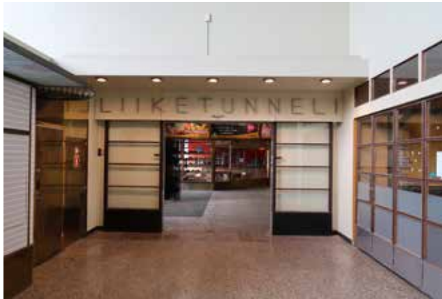
Kulku Asematunneliin. Aukon yläpuolinen "Liiketunneli"-teksti ehkä muistuttaa vuoden 1935 tekstityyppistä mutta ei ole sen mukainen. Huomaa teräslasiset liukuovet
