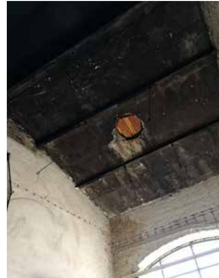
Savuaukko katossa. Aukko on suunnilleen höyryveturin piipun kohdalla ja sen aukosta on ollut torvi tai kupu alaspäin ja savutorvi ulos. Kuva 115.b Nosturi yhdessä pilttuussa.
