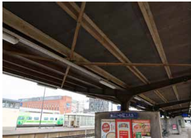
L-teräsdiaagonaalijäykistys, niitattu Z-palkkeihin.
