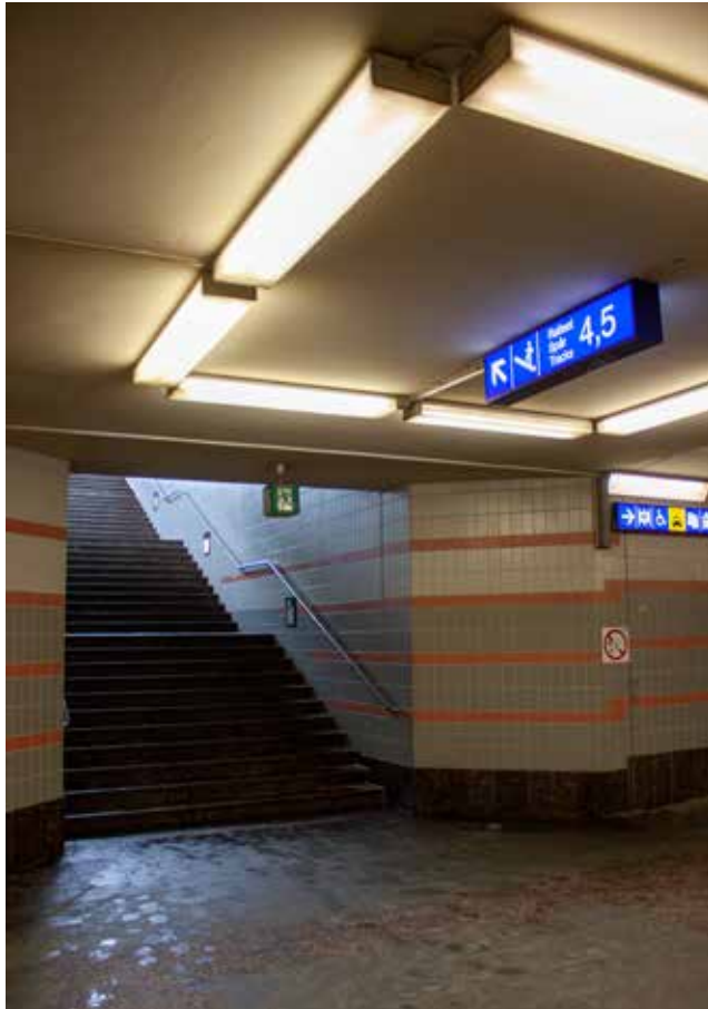
Portaat toiselle välilaiturille Laituritunnelin jatketussa osassa. Portaat ovat 1989-90 Asematunnelin mukaisesti punaista pallograniittia.
