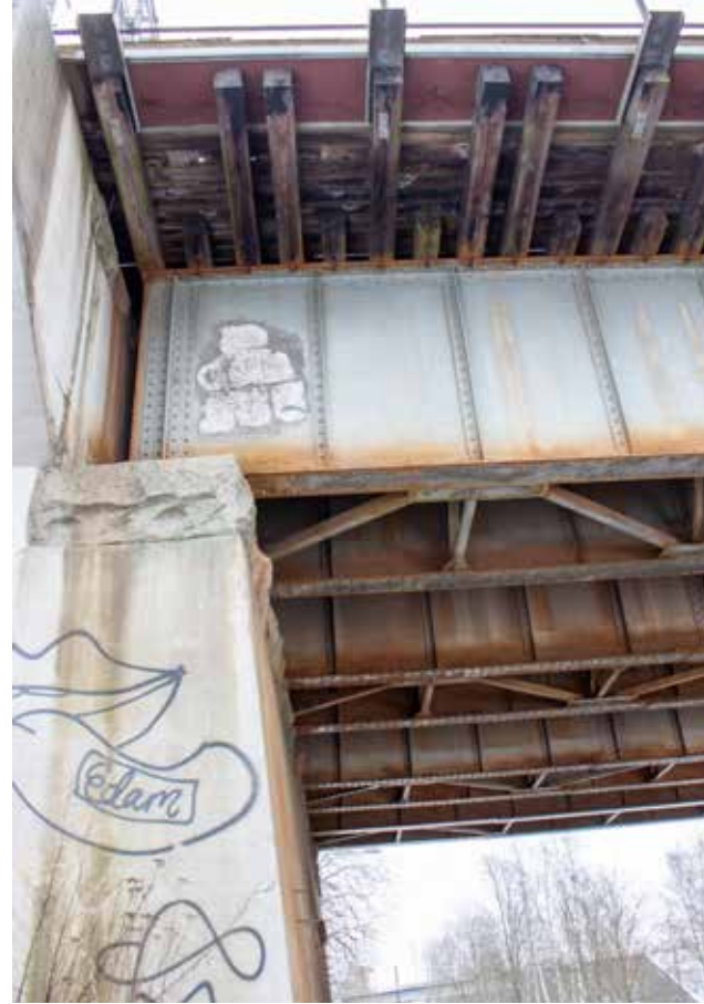
Läntisimmän raideparin reunan kansilevytyksen palkkituenta ja kaiteen kiinnitys.
