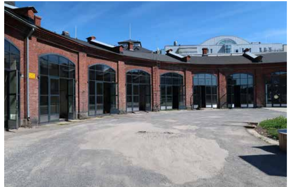
Veturitallien voimakas muoto ja aukotus ovat kestäneet kohtuullisesti ovien vaihtamisen ”liian tyylikkäisiin” teräslasi-ikkunaoviin ja maan pinnan kiveämisen siistiksi.
