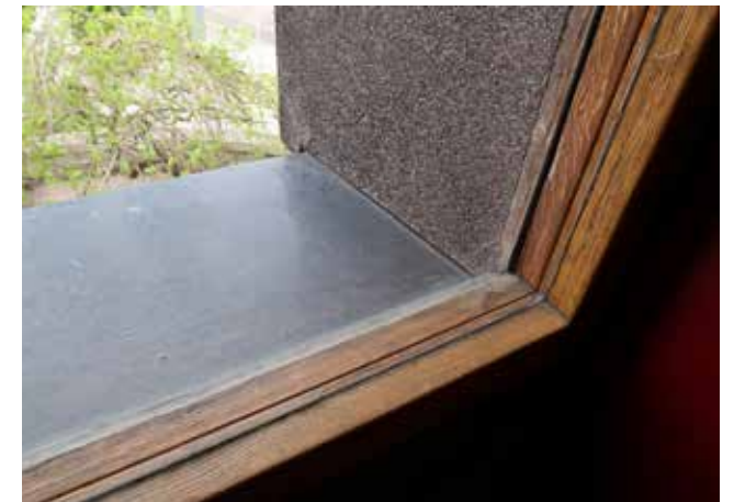
Ravintolasalin alkuperäiset ikkuna ja terastirapattu ikkunapilari.
