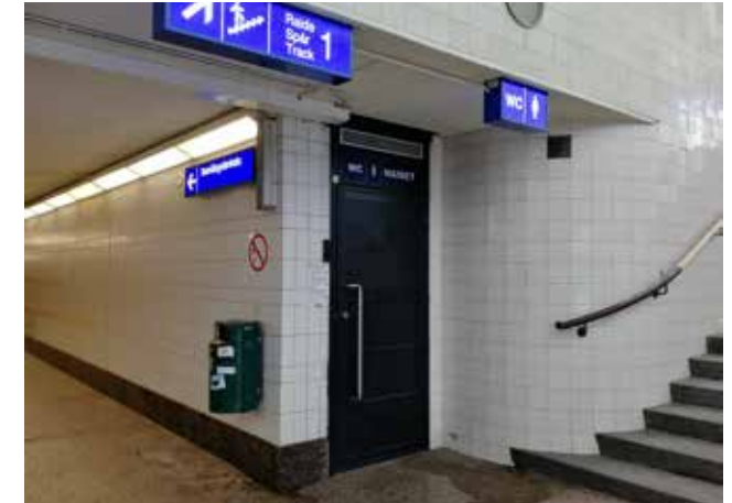
Naisten WC:n ovi. Huomaa uusi laatoitus WC:n kulkusta tunneliin 1989-90 Asematunnelin rakentamisen yhteydessä. Laatoitus alkaa valkoisena ja muuttuu asteittain Asematunnelin väriskeeman mukaiseksi.
