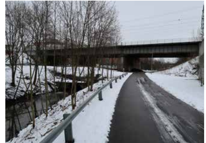
Näkymä lounaasta Viinikanojan varrelta Viinikanpolulla. Huomaa siltarummun suuaukko.
