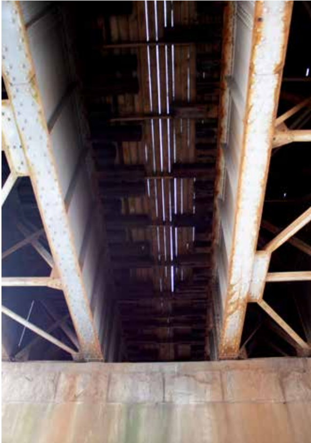
Raideparien välissä puupalkkien päät ja pitkittäinen lankutus.
