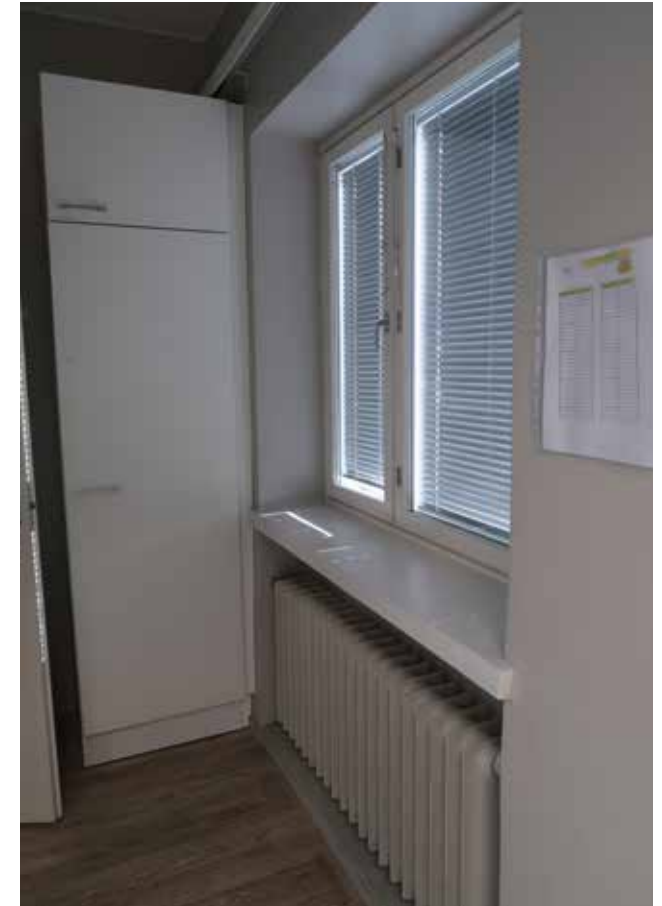
Patterit ovat alkuperäisiä valurautapattereita. Ikkunat uusittu myöhemmin.
