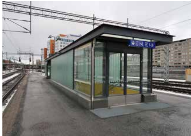
Rongankadun porras- ja hissikatos.
