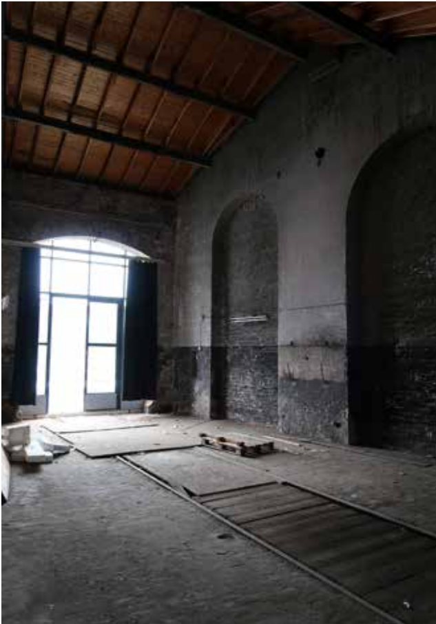
Pilttuun etuosa holviaukkosityvennyksineen. Verhojen tarkoitus pilttuiden ikkunaseinillä on peittää näkyvyys sisään.
