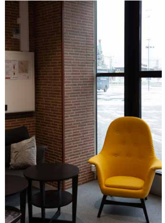
Pilttuiden tiilipinnat on verhoiltu sisustuslevyillä, veturitalin pintamateriaaleja ei ole näkyvissä.
