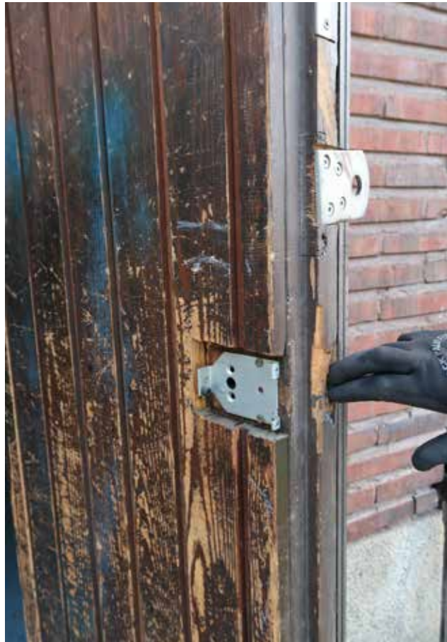
Ovien rungot vaikuttavat alkuperäisiltä. Ovet on kunnostettu ja uudelleenverhoiltu.
