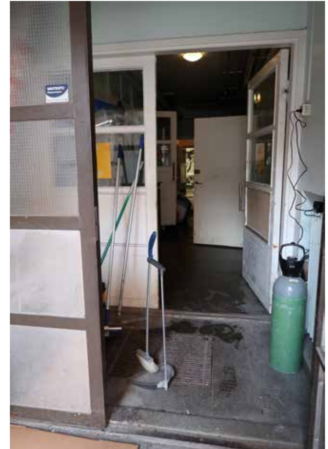
Kellarikerroksen sisäänkäynnin tuulikaappi ja alkuperäiset sisäovet.
