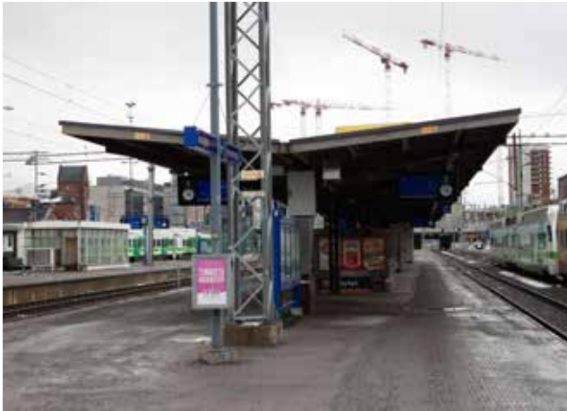
Ensimmäisen välilaiturin katos pohjoisesta katsottuna.
