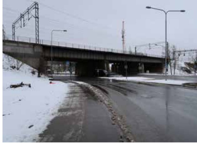
Näkymä luoteesta Tampereen Valtatiellä. Huomaa 1998 levennetty betoninen maatuki vasemmalla.
