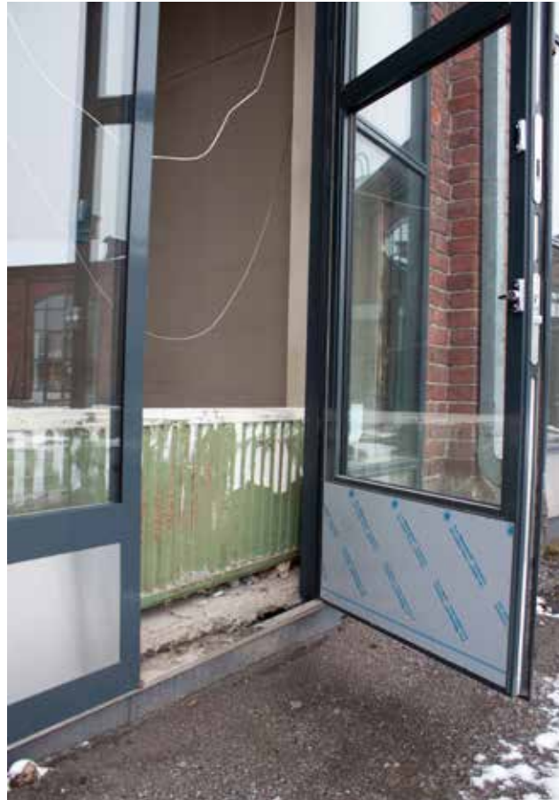
Lattian korotusvalu ja oven eteen jätetty, ilmeisesti toiminnassa oleva seinäpatteri.
