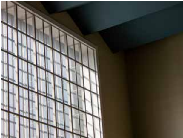
Asemahallin suuri ikkuna. Maalatut teräspuitteet ovat ulkoseinän ulko- ja sisäpintojen tasalla. Ikkunapintoja välissä tukiraudat kahden ruudun välein.
