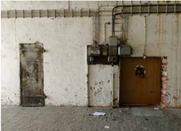
Pilttu 4:n vastainen seinä. Vasemmalla vanha alkuperäinen teräsovi taottuine saranoineen, oikealla mahdollinen lämmitys-uunin syvennys. Veturitallikäytön aikaisia sähköjohtoja pinta-asennuksena.
