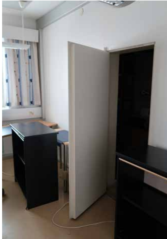
Eteläisimmän toimistuhuoneen päädyn arkiston kassakaappi- ovi.
