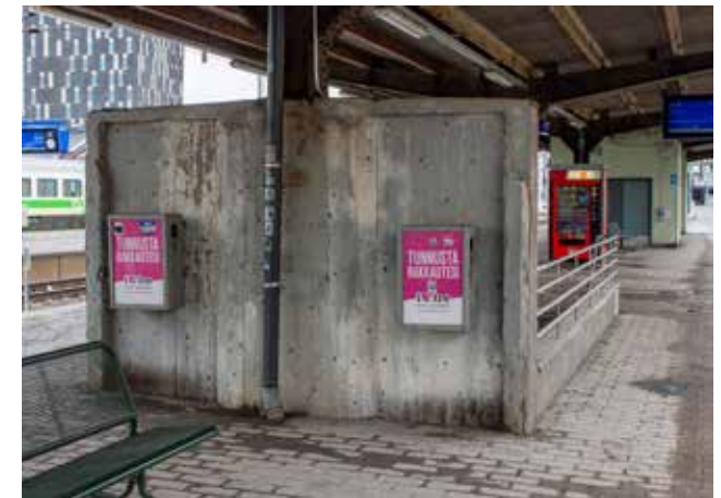
Seinä portaikon yläpuolella. Paikalla oli alun perin kioski. Kioskit on purettu vuoden 1974 jälkeen.
