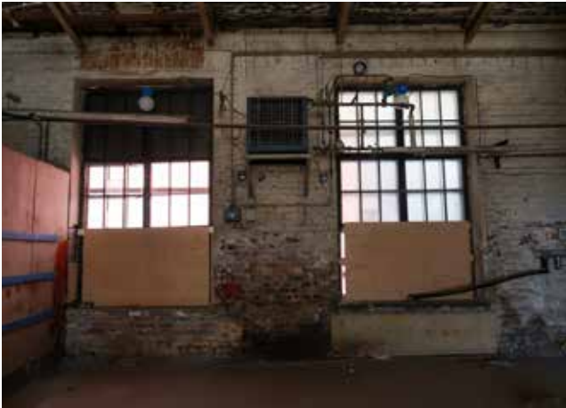
Takaseinä levyillä suojattuja ikkunoita.
