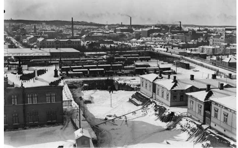
Itsenäisyydenkadun tunnelin rakennustyömaa 1933. Kuvasta näkyy hyvin, miten katu- tasoa on kaivettu alemmas aivan talojen vierellä. Maiseman muutos on ollut merkittävä. Taustalla näkyy vielä Tammelan ylikulkusilta. Kuva Vapriikin kuva-arkisto, kuvaaja E. M. Staff.
