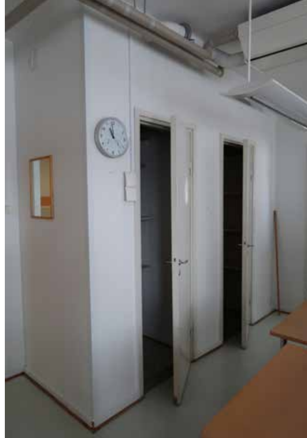
Komeroiden ovet varhaisimmasta toimistotilojen rakennusvaiheesta, alkuperäiset helat.
