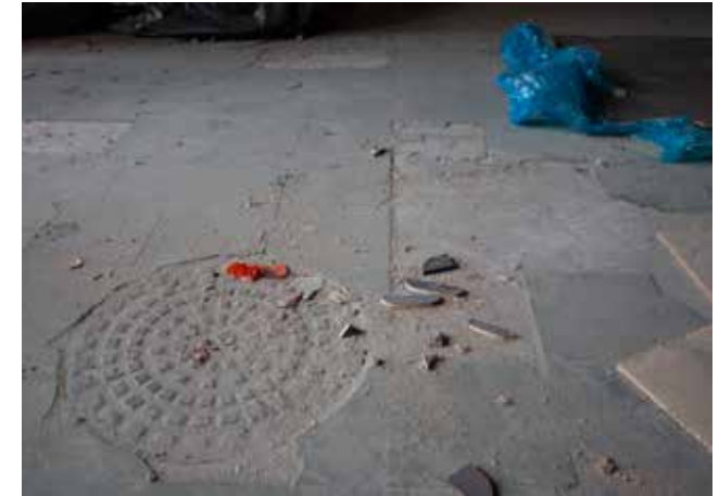
Kvartsivinyylilaatta ("hovilaatta") tasoitelaastin päällä. Pyöreä teräksinen tarkastusluukku pilttuumontun kohdalla.
