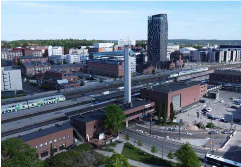
Pohjoinen talousrakennus jää irralliseksi rakennukseksi, kun sitä asemaan yhdistävä yhdistävä muuri on purettu. Lisäksi ravintolan kohdalle on rakennettu terassin kioski kiinni asemaan, joka estää hahmottamasta lisärakennusta kunnolla. Kuva Riku Karjalainen.
