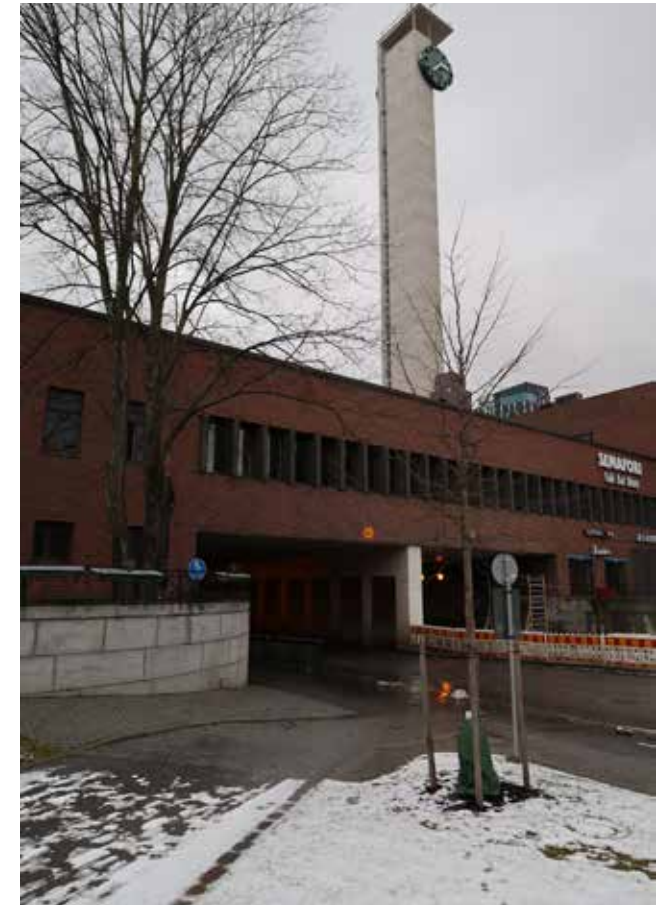
Tunnelin länsisuu asemaravintolan alla. Raitiotien tunnelityöt käynnissä kuvanottohetkellä 2.4.2020.
