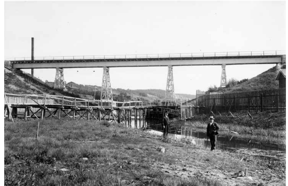
Viinikanojan ensimmäinen silta. Alun perin siltaa kannatti vain kaksi ristikkotuokea keskellä, mutta hyvin pian sen sillan valmistumisen jälkeen siihen on lisätty matalammat tuet. Kuva Museokeskus Vapriikki, kuvaaja William Lomax.
