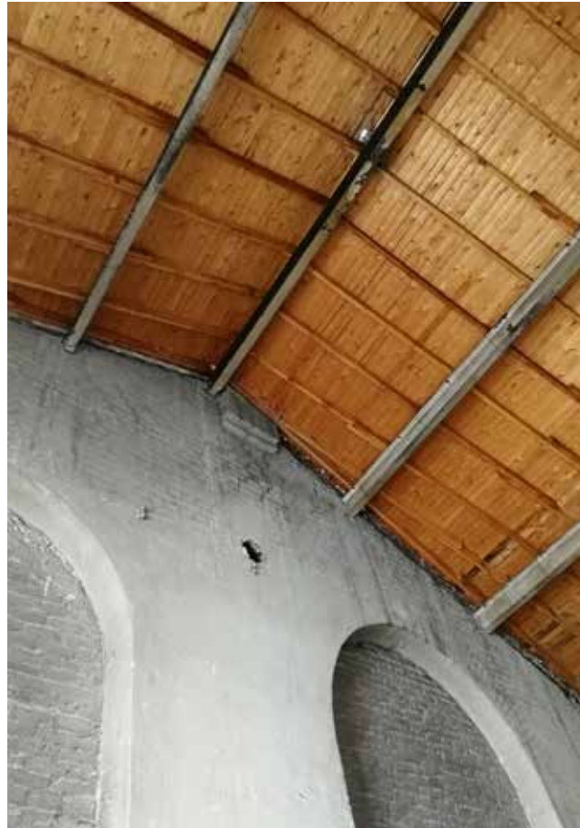
Katon aluslaudoitus, huomaa valumat seinän yläosassa.
