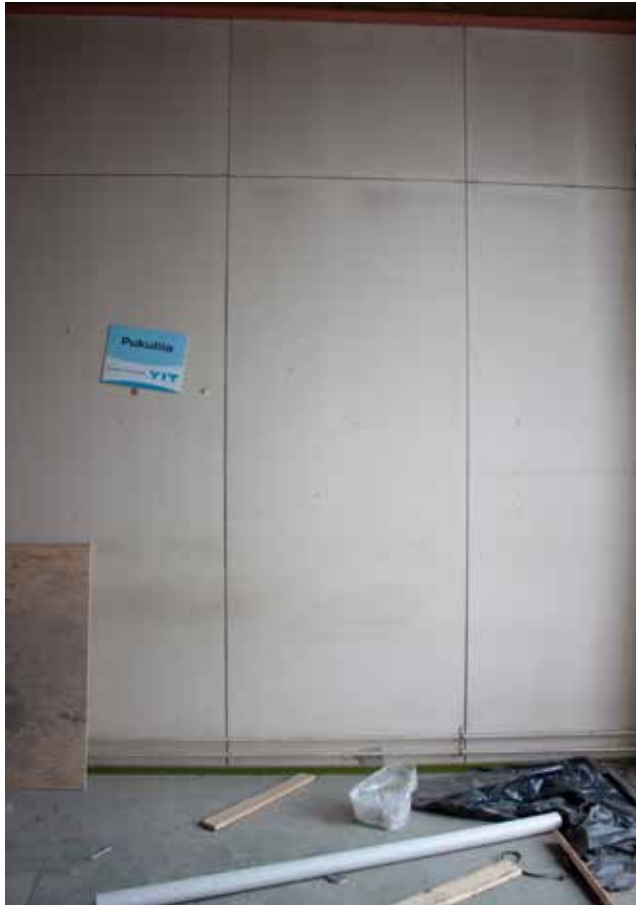
Maalattu lastulevy pilttuiden tiilisen väliseinän päällä. avosau- mat. Huomaa vihreäksi maalattu jalkalista ja oranssi kattolista.
