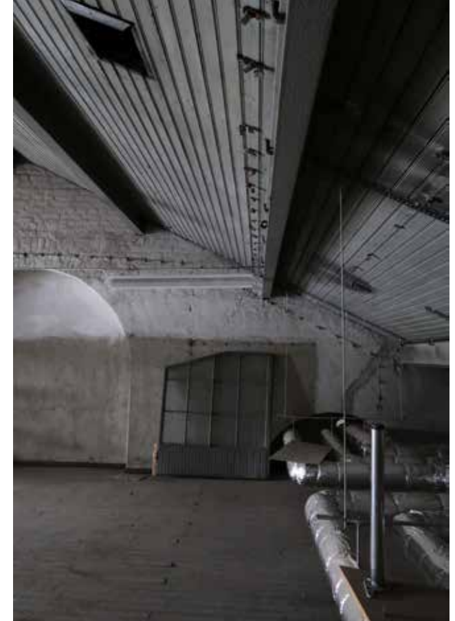
Toisen kerroksen takaosan kattopanelointi. Seinää vasten vanha pilttuun oven fragmentti.
