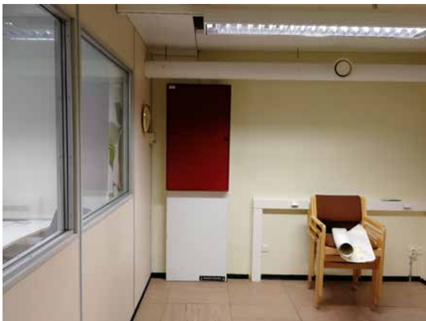
Länsisiiven toimistohuone, korotettu lattia ja ikkunallinen väliseinä.
