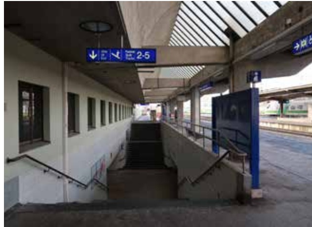
Asemalaiturin liittyminen asemarakennukseen, kattoikkunat ja portaat Laituritunneliin ja asemahalliin. Huomaa julkisivun materiaalirajaukset, ikkunat toimistotiloihin ja porraskaiteen muotoilu sinisen julistevitriinin takana.
