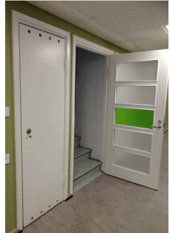
Entisen hissien yläpuoliseen varastohuoneeseen johtava lasipeiliovi. Vieressä alkuperäinen varastokomeron ovi.
