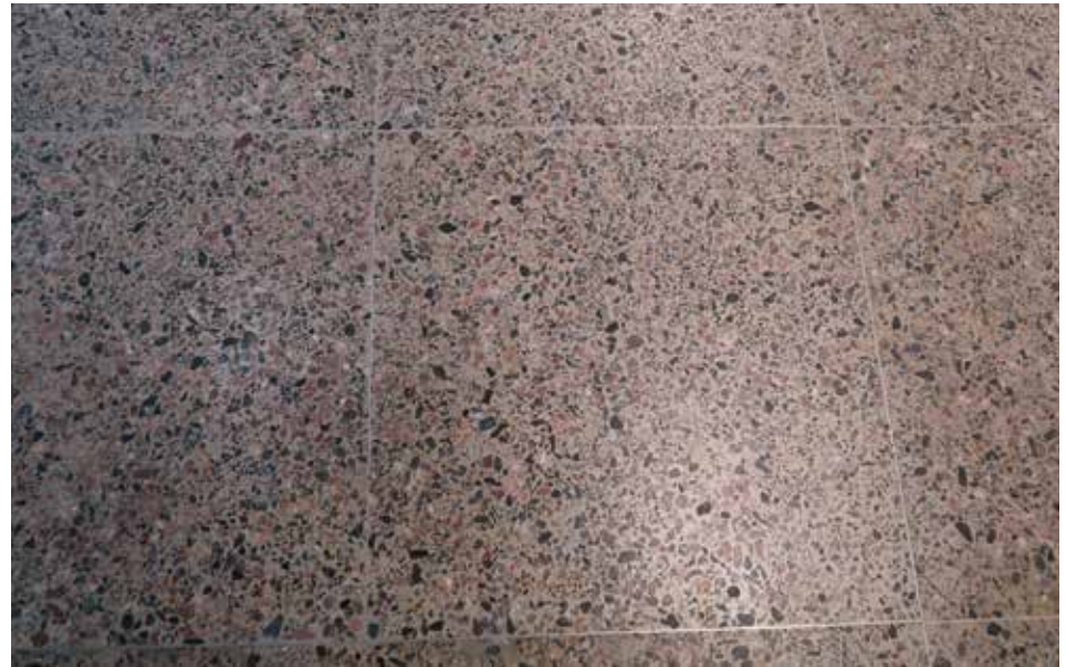
Aseman alkuperäinen graniittisepelimosaiikkilattia on ollut kestävä ja kulunut kauniisti.
