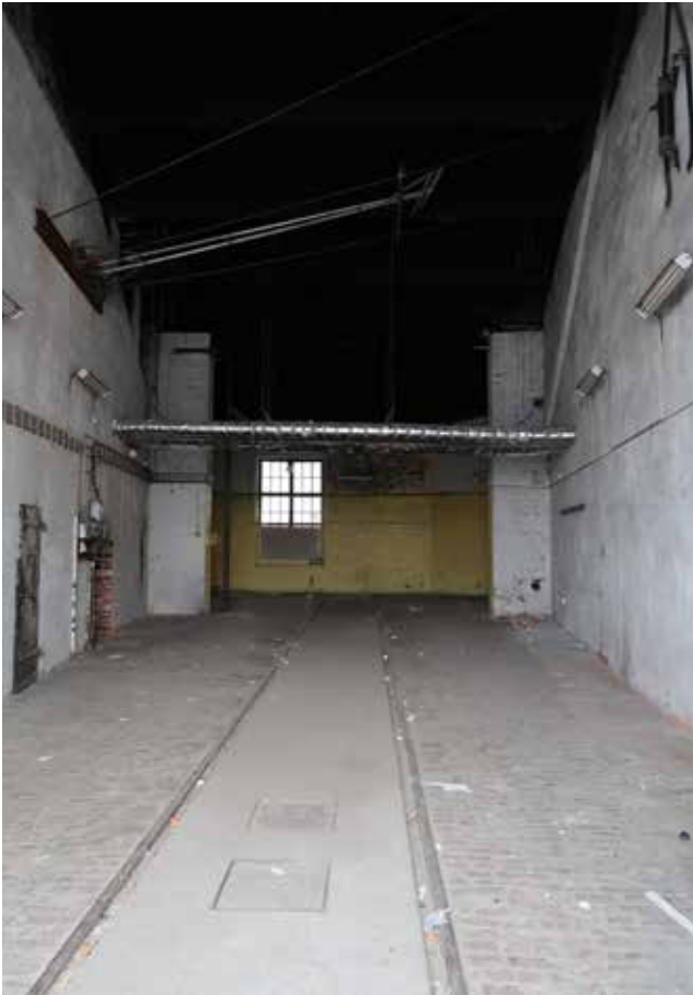
Pilttuu 5, jota on laajennettu vuonna 1934. Huomaa raiteiden väliin tehty betonivalu monttuluukkuineen ja äskettäin lisätty lämpölinja eristeineen.
