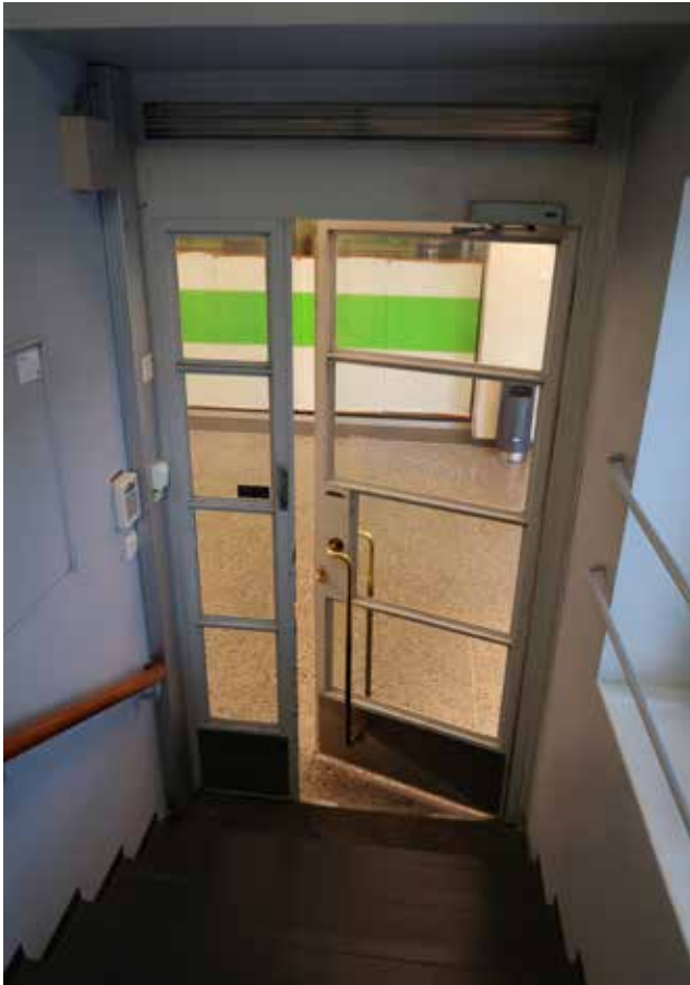
Ovi asemahallin käytävältä porrashuoneeseen.
