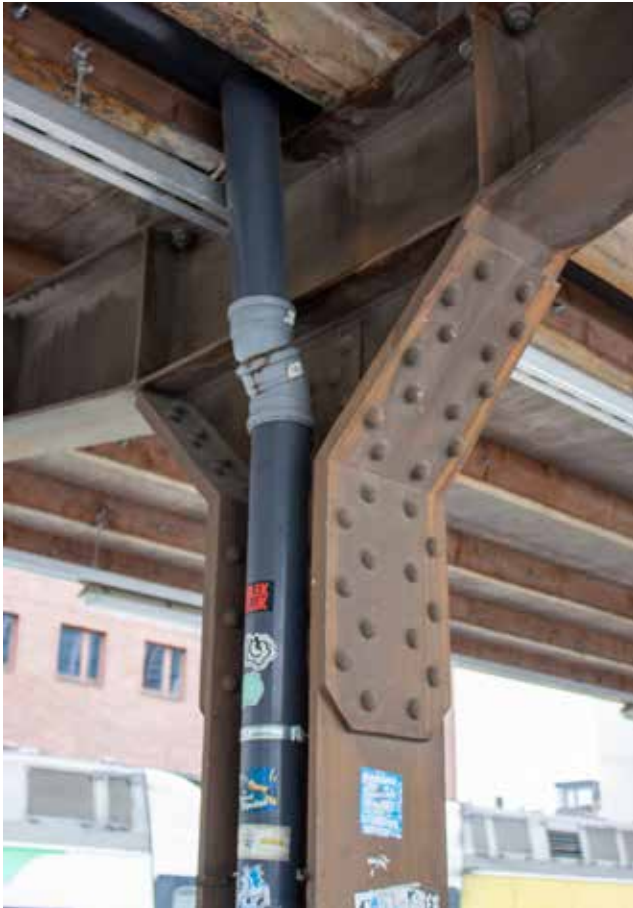
Niitattu pilarin ja pääkannattajan liitos.
