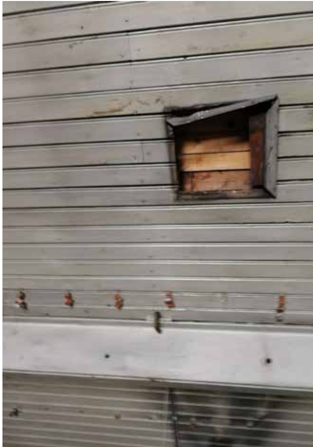
Kattopanelointi ja alta näkyvää vesikaton aluslaudoitusta.
