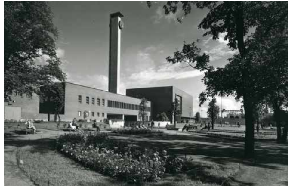
Asema pohjoisesta katsottuna juuri valmistumisen jälkeen. Ravintolasiiven ja pohjoisen lisäsiiven välissä on muuri, jonka taakse jää "keittiöpiha". Mataluudestaan huolimatta muuri yhdistää lisäsiiven muuhun rakennusmassaan ja tekee julkisivusta entistäkin monumentaalisemman. Ravintolan keittiön ikkunat ovat alun perin olleet vaakajaolla varustettuja. Kuva Rautatiemuseo.
