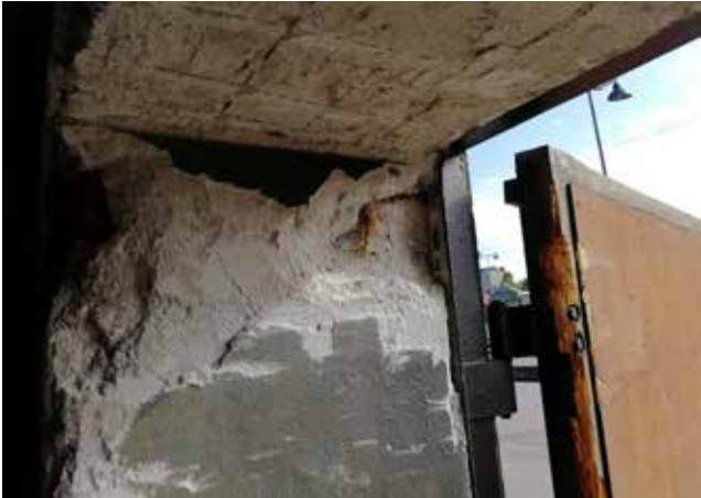
Varastojen ovien rungot ovat alkuperäisiä saranoineen, ovet on kunnostettu ja verhoiltu uudestaan.
