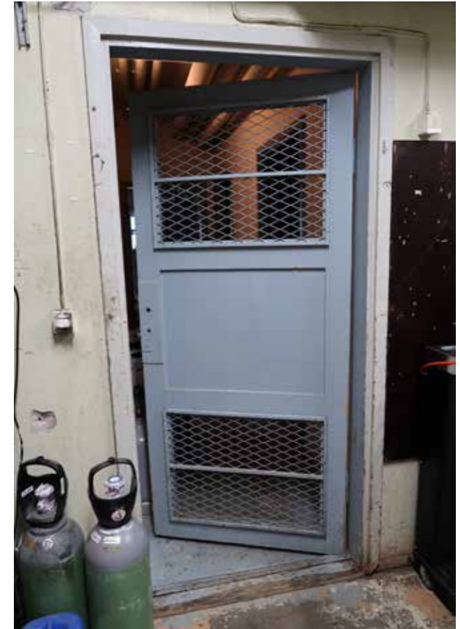
Ovi varastokäytävään eteläpään varastosta.
