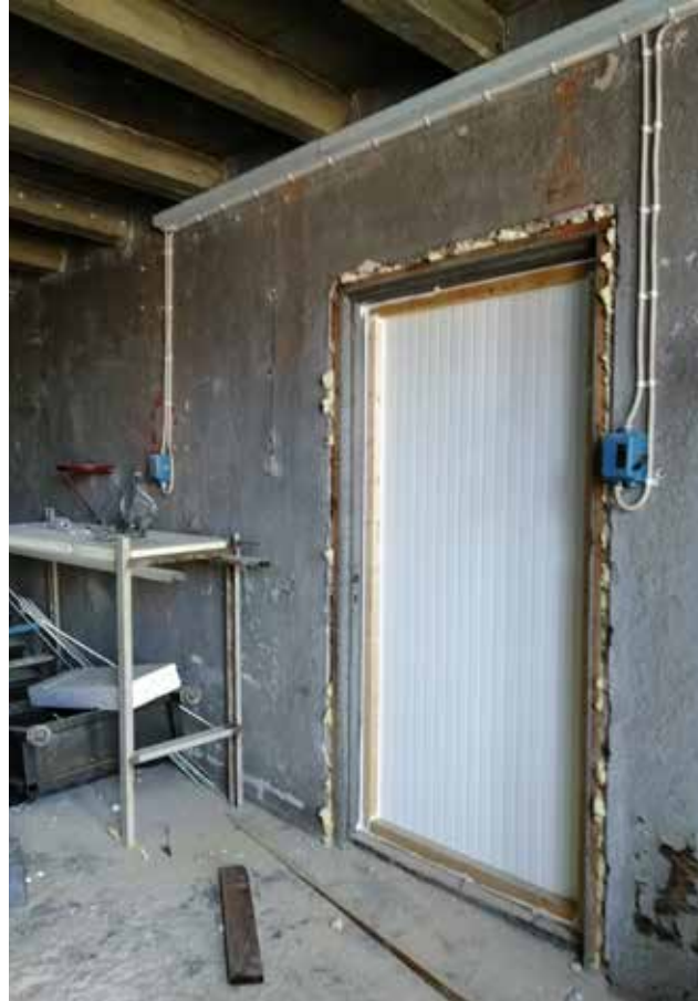
Visit Centerin työmaa-aikainen oviyhteys pilttuuseen 9.
