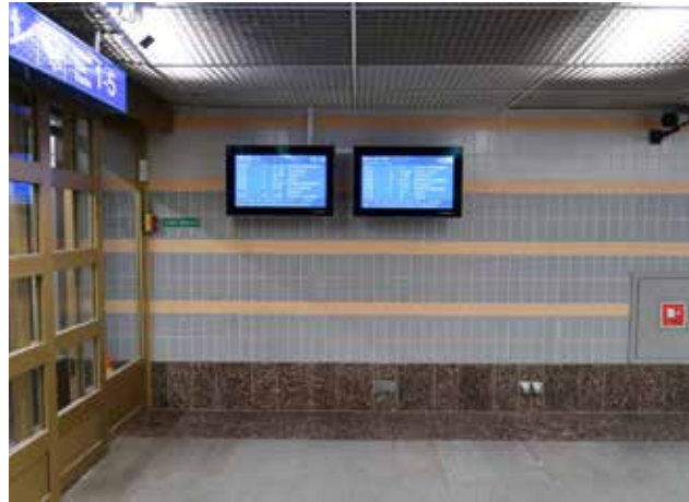
Yhteyskäytävä Laituritunneliin ja 1988-90 materiaalivalinnat: seinälinkkeri, kiillotettu punagraniitti seinänvieri- ja jalkalista-laattana. Harmaa graniitti varsinaisena lattialaattana. Ritiläkatto. Eloksoidut alumiinilasiliukuovet laituritunneliin.
