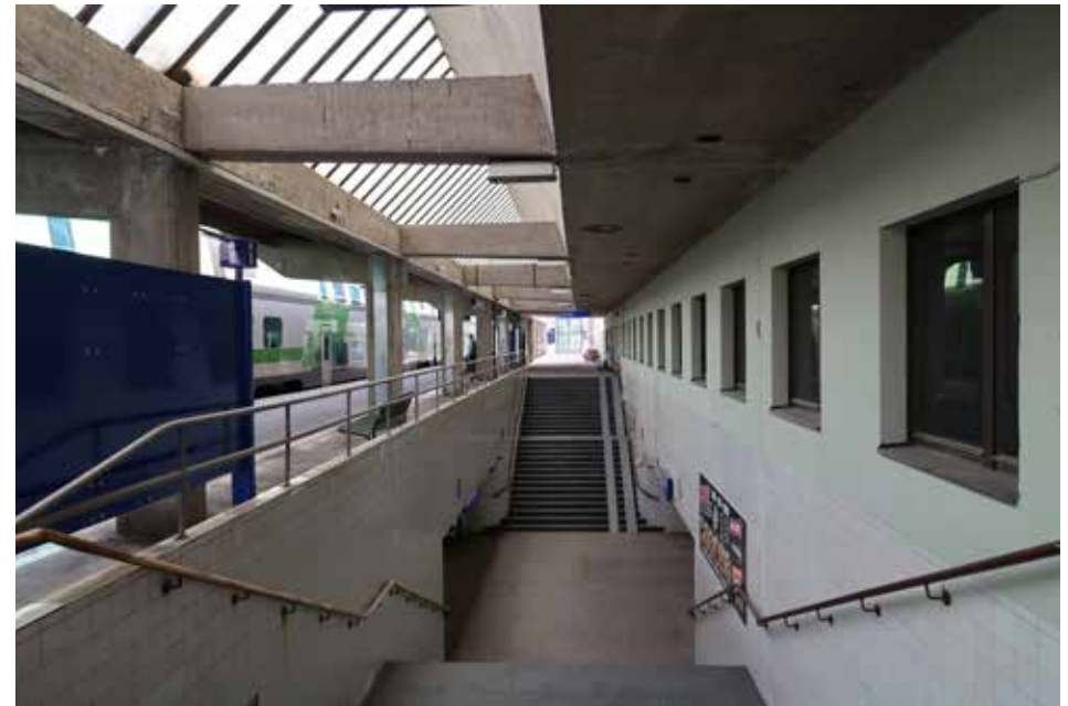
Asemalaiturin katos vuonna 2020. Ylävalo on jäljellä ja kuvasta näkyy hyvin, miten valoisaa on aseman julkisivun vierellä, kohdassa, jossa laiturikatot on irti seinästä.
