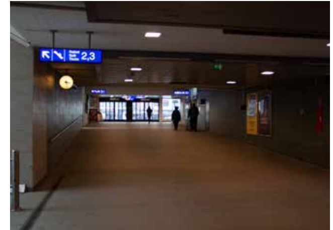
Näkymä länteen ensimmäisen välilaiturin kohdalla. Huomaa lasketun alakaton katkaisu laiturien kohdalla.
