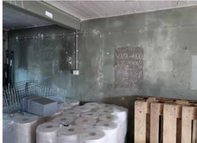
Akkujen lataushuoneen sivuseinä.
