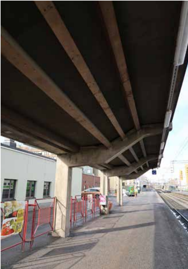
Näkymä pohjoiseen asemaravintolan kohdalta, katoksen kannatusrakennetta. Kuvan punaiset teräsaidat liittyvät ravintola-toimintaan.
