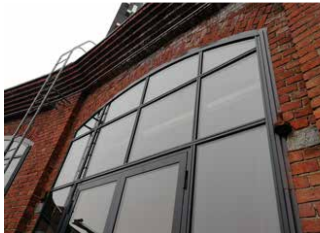
Ikkunaseinät. Pielissä jäänteet saranan tapeista kivitukineen.
