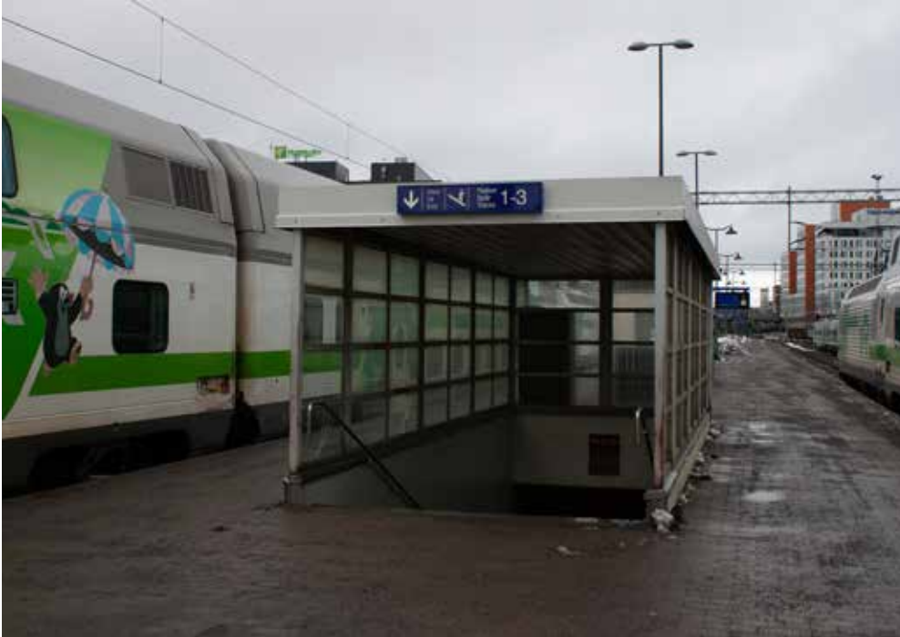
Asematunnelin porraskatos vaikuttaa aikansa rautatieasemien standardiratkaisulta. Asematunnelin porraskatoksen räystäään otsapelti ja teräsrakenteet vaaleanharmaat, pintamaali teräsosissa paikoin huonossa kunnossa, pohjamaali tullut näkyviin. Alumiiniset ikkunalistat.
