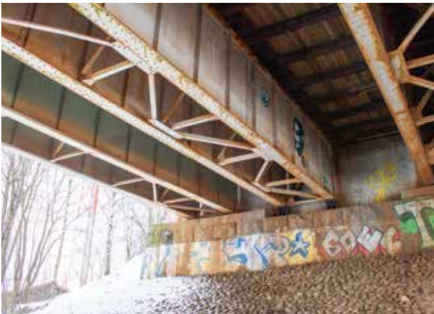
Eteläinen maatuki. Vasemmanpuoleinen, itäisin palkisto hitattu, muut niitattu. Huomaa uudemmat betonipinnoitteet ja maatuen kenttäkiveys tässä päässä siltaa.
