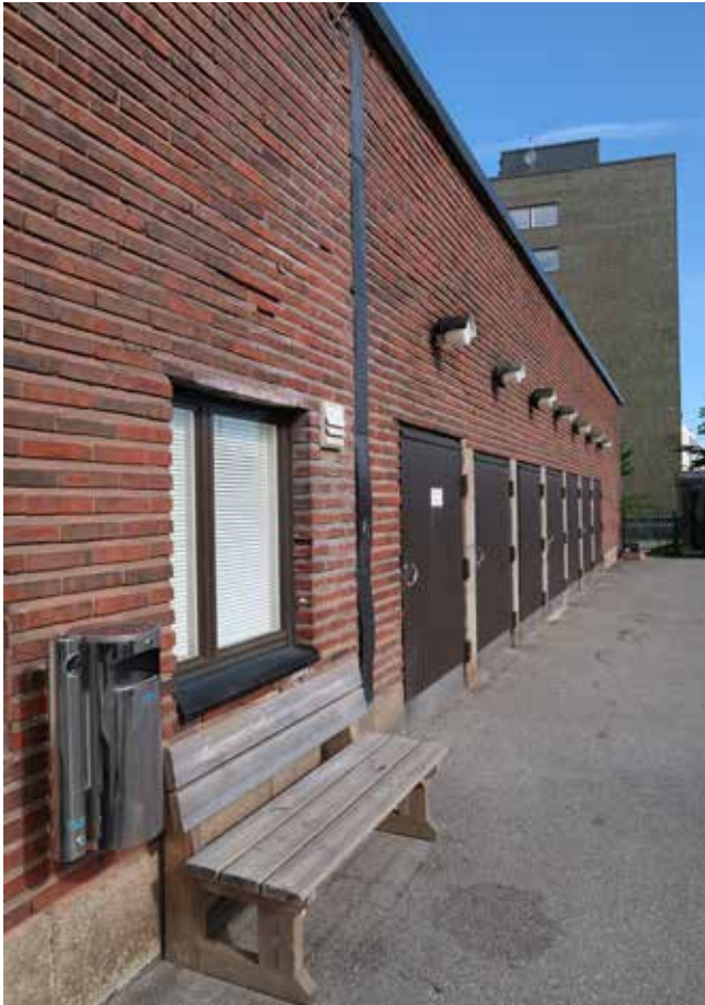
Asemalaiturin julkisivu, toimiston ja varastojen ovet.
