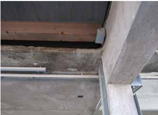
Puretun betonisen katoksen alapinnan rajausta ja väliaikainen katerakenne.
