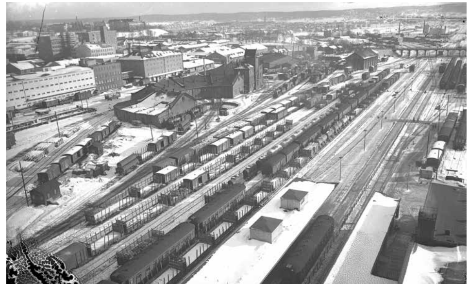
Ilmakuva Tampereen asemasta ja ratapihasta vuodelta 1955. Ratapiha on avoin ja veturitallien ja aseman yhteys selkeä. Kuvassa näkyy, miten välilaituri kapenee kohti etelää. Kuva Vapriikin kuva-arkisto, kuvaaja Reino Branthin.
