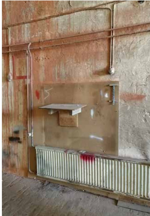
Työnkirjauspiste ja puhelinteline seinässä. Punainen tiilipöly peräisin uuden lämpölinjan asennuksesta.
