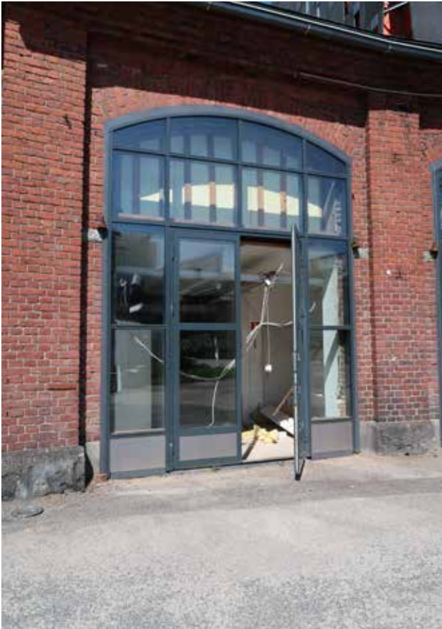
Pilttuun ikkunaseinä ja toisen kerroksen seinälevytys.
