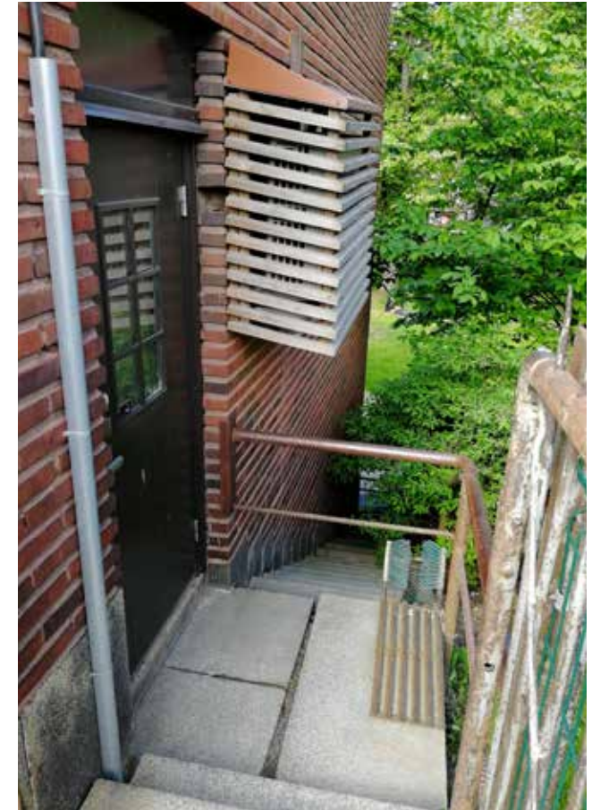
Kiinteistöyksikön käyntiovi. Suljettu porrasyhteys Asemapuiston puolelle.
