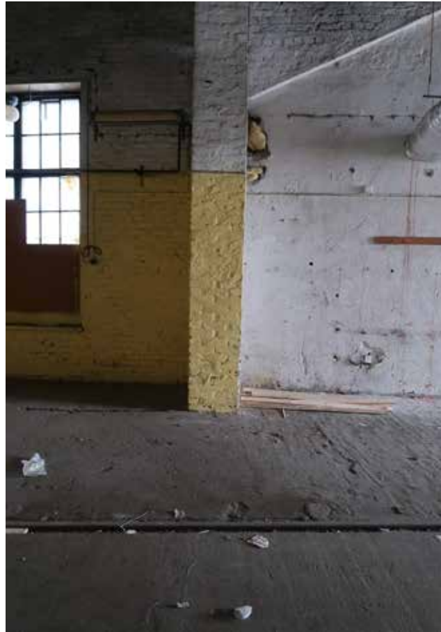
Vuoden 1934 laajennuksen tukipilariksi jätetty vuoden 1896 takaseinä.
