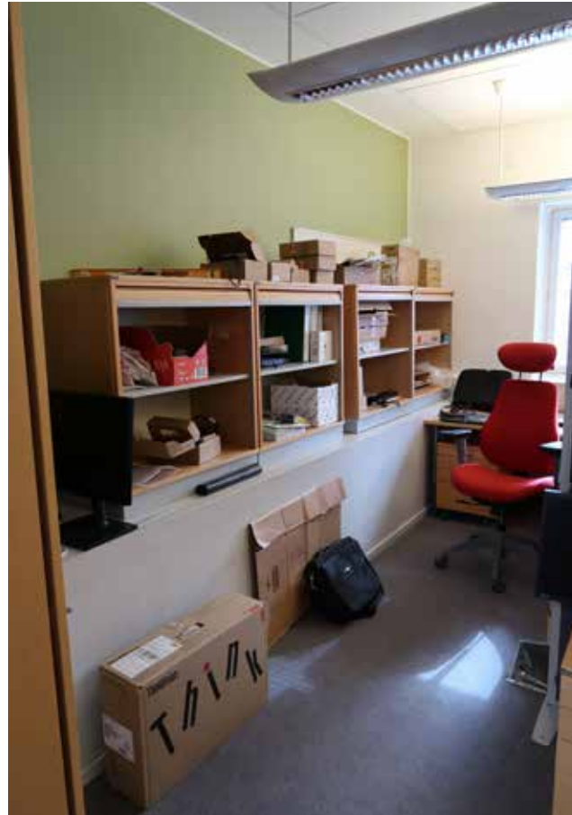
Hissikuilun kantavan seinän yläosa ulokkeena vasemmalla.
