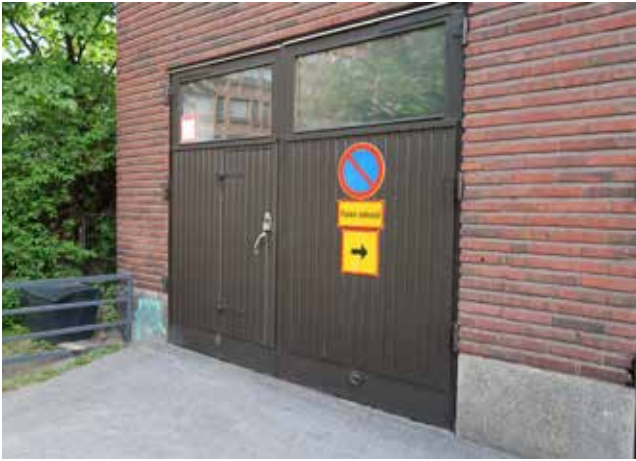
Autotallin ovi Asemapuiston puolella.
