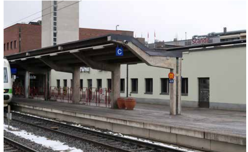
Asemalaiturin katoksen keveys hahmottui parhaiten alun perin katoksen päädyissä. Nyt päädyt on pellitetty hyvin raskaasti ja katoksen sileäpintaisten betonitaitelaattojen tilalle on kertonpuupalkeilla kannatettu, kulunut vaneri.
