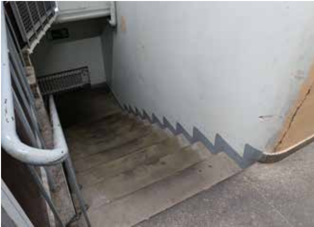
Portaikön yläpää: panssaribetonilattia ja porrasaskelmat, maalatun ja keraamisen jalkalistan yhtymäkohta, teräksinen maalattu käsijohde.
