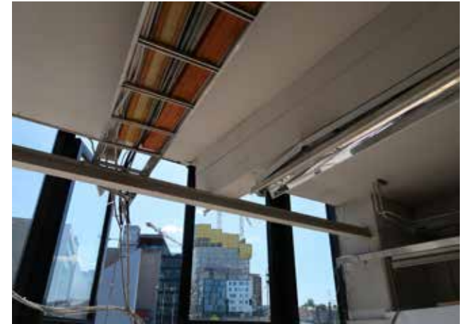
Välipohjan kannatusrakenteita. Toimistovaiheen talotekniikka, loisteputkivalaisimet ja sähkökourut.
