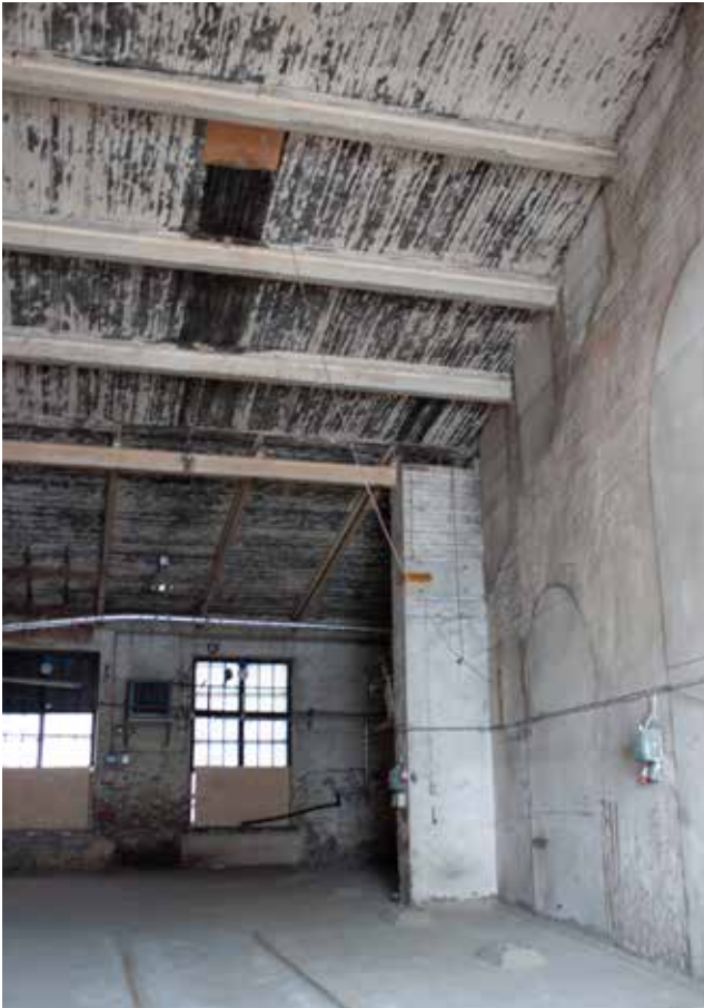
Pilttuun 3:n kattorakennetta teräspalkkeineen ja aluslaudoitukseen. Huomaa äskettäin asennettu lämpölinja pilttuun takaosassa.
