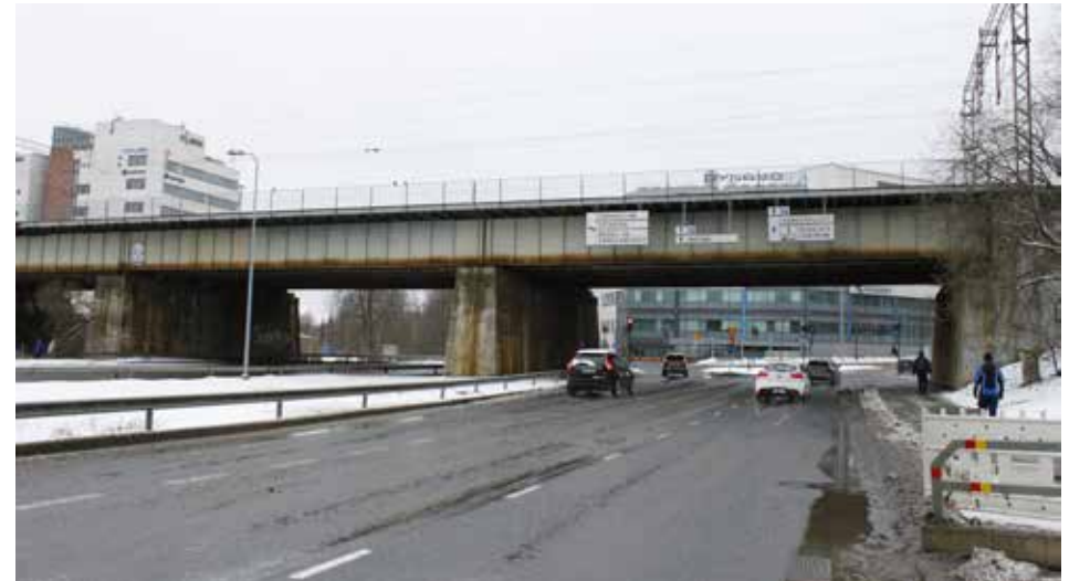
Kuva sillan itäpuolelta kohti Pyhäjärveä vuonna 2020.
