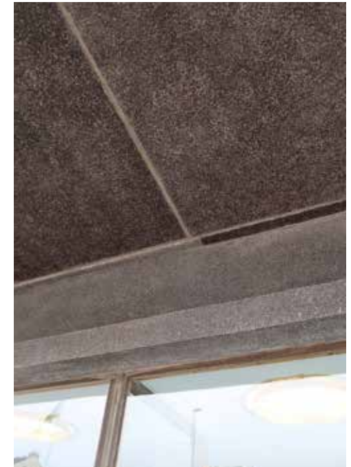
Julkisivun ikkunoiden ja pääsisäänkäynnin korostuksessa käytettyä terastirappausta. Lähikuva sisäänkäyntikatoksen alapinnasta, jonka rappaus on uusittu ja jossa uusi ja vanha pinta erottuvat selvästi.
