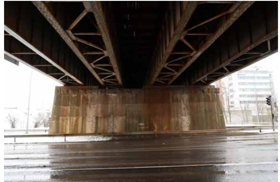
Reunimmainen levypalkki kuvassa vasemmalla on tehty hitsaamalla, kun muut on niitattu. Niitattut palkit ovat visuaalisesti kevyemmän näköisiä kuin hitsattu. Hitsattu palkki on puolestaan oikeasti kevyempi kuin niitattut, koska siinä on vähemmän terästä.
