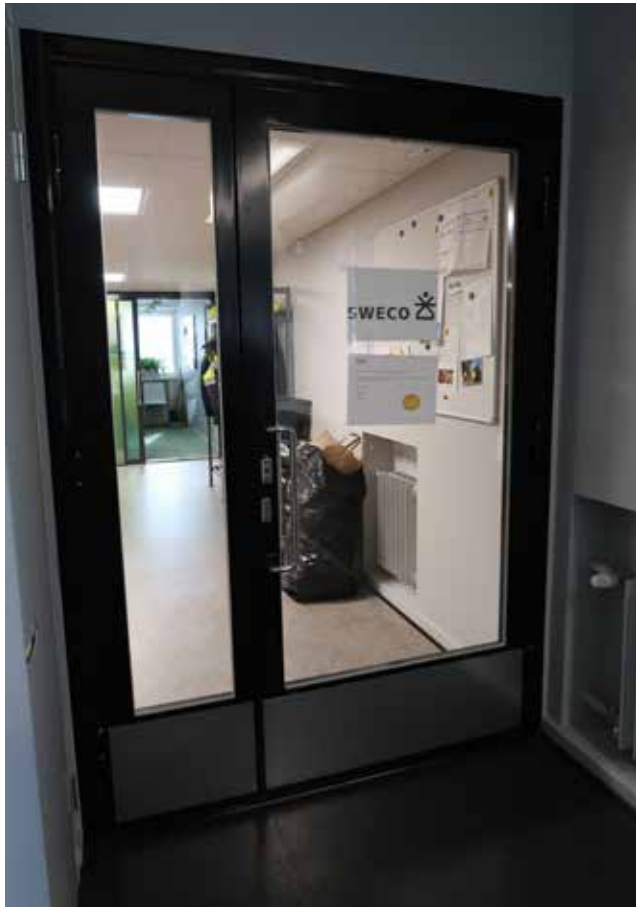
Porrashuoneen ovi toimistoon.
