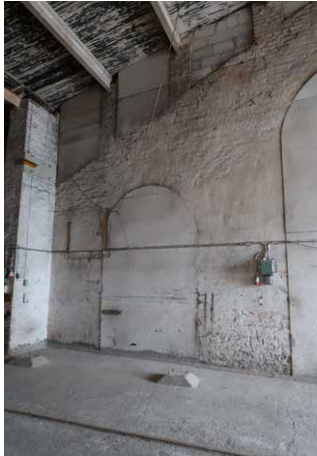
Ensimmäisen vaiheen 1896 kattolinjaa ja 1934 lisätyn osan seinätäytteet.
