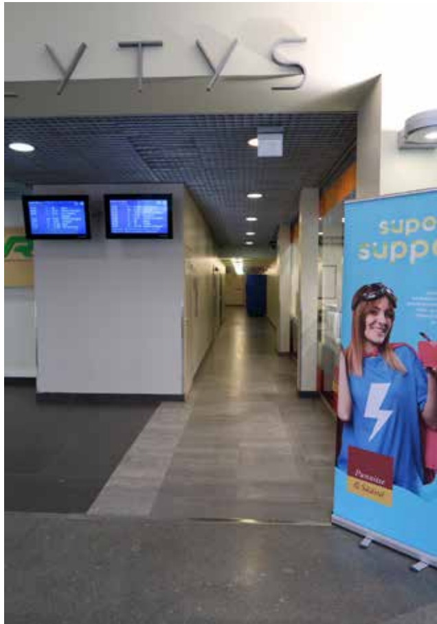
Kulku Matkatavaratunneliin asemarakennuksen käytävältä. Huomaa lattiamateriaalit ja niiden rajapinnat. Tunnelin lattia on hiottua betonilaattaa vuodelta 2008.
