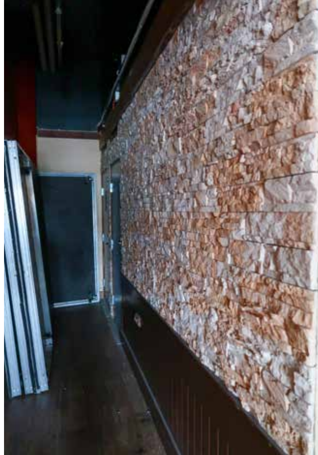
Käytäväkäynti keittiön viereisiin yleisö-wc-tiloihin. Alkuperäinen ravintolaseinä ja Eino Kaurian seinämaalaus on sijainnut kuvan valelohkokiviseinän tasalla. Seinän takana rakennuksen hormistoa.
