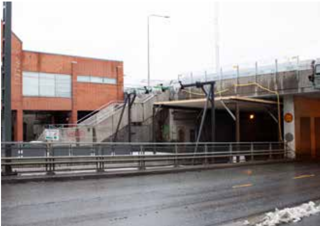
Tunnelin itäinen suuaukko työmaan ajalta 2.4.2020.
