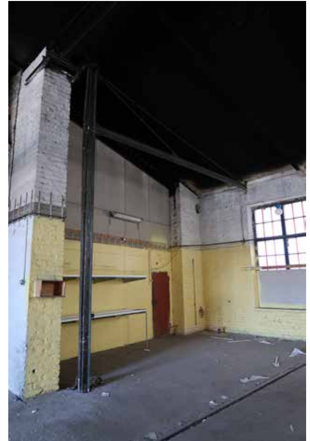
Kääntyvän pilarinosturin runko.
