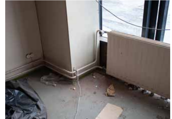
Viimeisimmän rakennusvaiheen patteri pintavetoiseen. Huomaa kolmipiikkiset puhelinpistokkeet.
