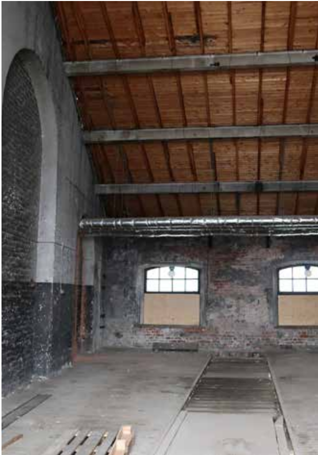
Pilttuu 6. Alkuperäinen katon aluslaudoitus. Huomaa alkuperäiset ikkunat ja säilynyt montun osa peitelankkuineen raitteiden välissä pilttuun perällä.
