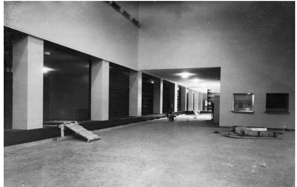
Asemahallin matkatavaratilat rakennusvaiheessa. Matkatavaratiski oli sijoitettu pilareiden väleihin ja sen päätteenä käytävällä oli "Matka- ja kiitotavarakoju" ulko-oven vieressä. Asemahallin eteläseinällä lipunmyyntiluukut. Kuva Vapriikin kuva-arkisto.
