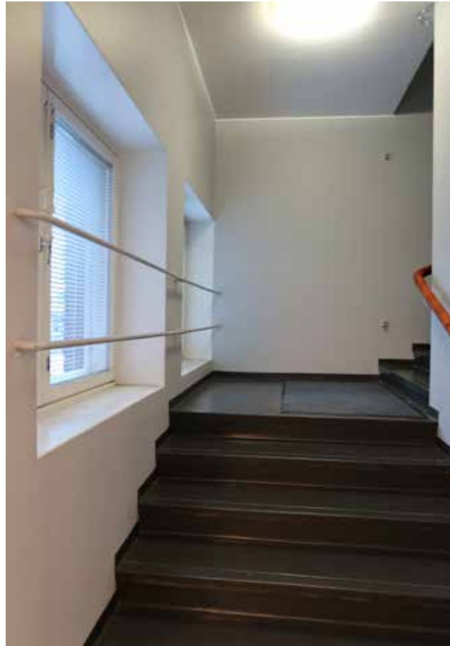
Portaat asemahallin tasolta ensimmäiselle tasanteelle. Seuraavan porrassyöksyn edessä on ollut kalteriportti, mistä jäänteenä saranat ja rajoittimet seinässä ja katossa. Maalatut teräskateet ikkunan edessä.
