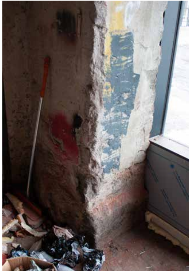
Pilttuun oviaukon pieli. Kivinen sokkeli alimmaisena, useita väri- ja laastikerroksia.
