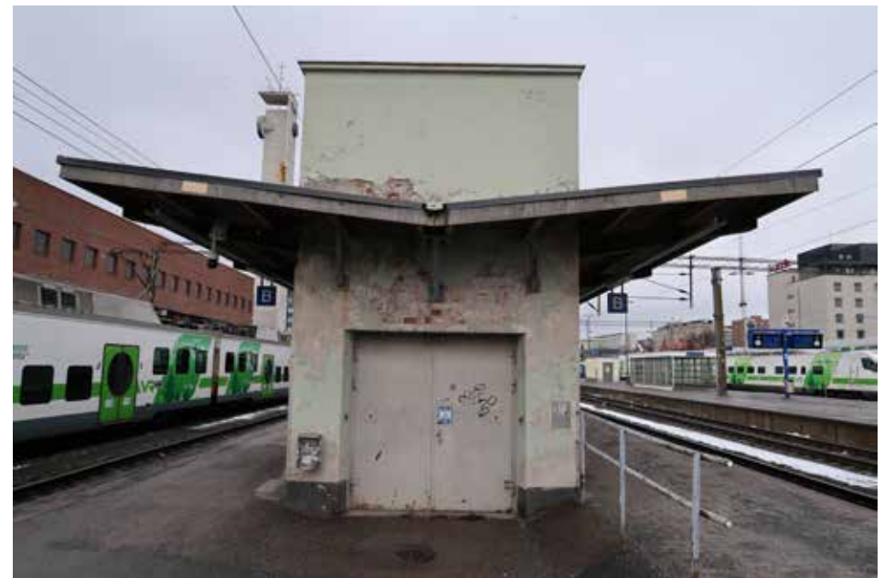
Asemalaiturin katoksen keveys hahmottui parhaiten alun perin katoksen päädyissä. Nyt päädyt on pellitetty hyvin raskaasti ja katoksen sileäpintaisten betonitaitelaattojen tilalle on kertonpuupalkeilla kannatettu, kulunut vaneri.
