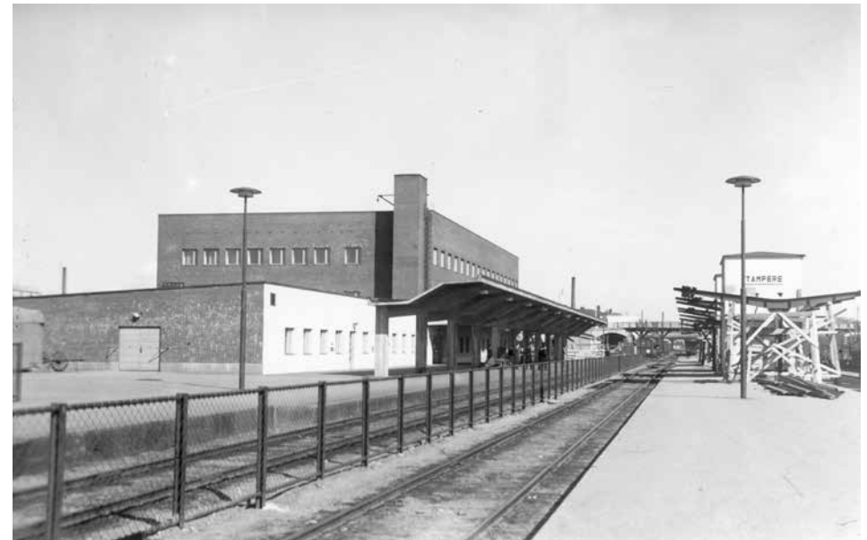
Rakentamisen aikaisessa kuvassa hahmottuu laiturien puoleinen valkoiseksi rapattu julkisivu hienosti. Se on kuin naamio muuten punatiilisen rakennuksen kasvoilla. Myös asemalaiturin katoksen keveys on kuvassa merkillepantavaa. Kuva Vapriikin kuva-arkisto, kuvaaja Atelier Laurent.
