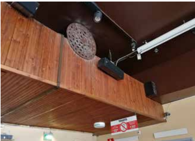
Ravintolasalin itäisivun paneloitu alaslasku ja IV-kotelo.
