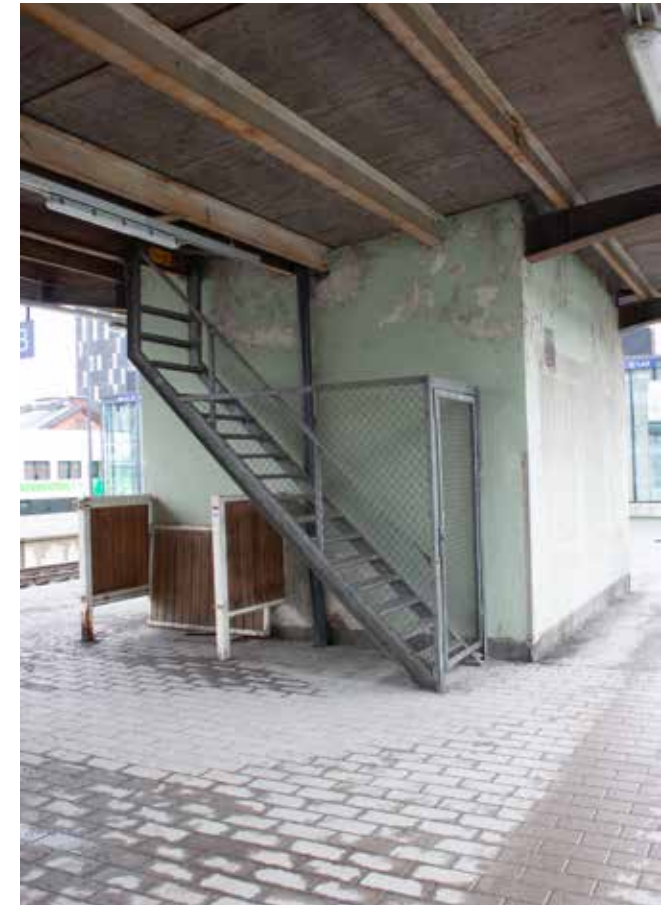
Eteläisen hissitornin pohjoispuoli, huoltoyhteys katolle.
