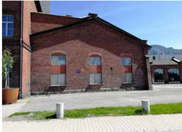
Veturitalin päätyseinä eli pilttuun 1 sivuseinä, jossa näkyvissä vuoden 1947 jako kahteen kerrokseen. Ikkunarivien välissä punaiseksi maalattu vaakalaudoitus.
