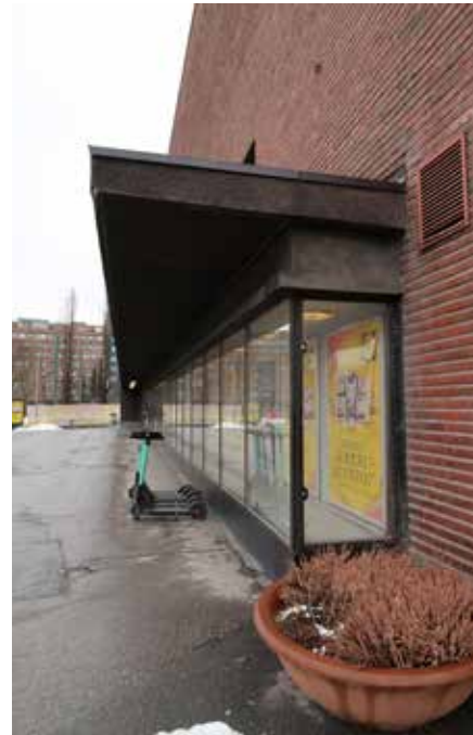
Julkisivun ikkunoiden ja pääsisäänkäynnin korostuksessa käytettyä terastirappausta. Lähikuva sisäänkäyntikatoksen alapinnasta, jonka rappaus on uusittu ja jossa uusi ja vanha pinta erottuvat selvästi.
