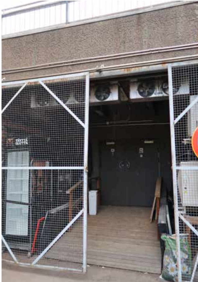
Ravintolan ja Talousrakennuksen väliin on rakennettu asiakas-wc ja esteetön wc luiskineen Asemapuiston puolen terassi-ravintolaa varten.
