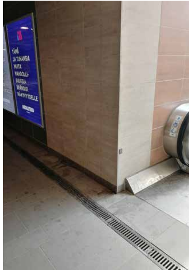
Ensimmäisen välilaiturin kulma, pintamateriaaleja ja lattiakaivo-ritilät.
