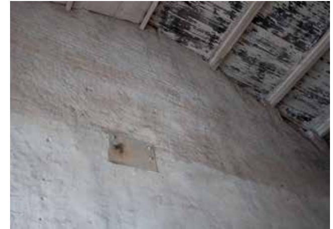
Pilttuun 2 vastainen seinä, huomaa vetotangon tai muun myöhemmin katkaistun asennuksen vaatima laippa. Vastaava laippa löytyy tämän pilttuun vastapäiseltä seinältä.
