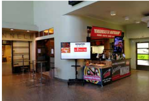
Vuoden 1935 Rautakirjakioskin ja parturiliikkeen seinäaukot hallin koillisnurkassa. Yhdistetyssä liiketilassa on nyt ruoka-baari. Aukkoja suurennettu ja niihin tehty ovet.
