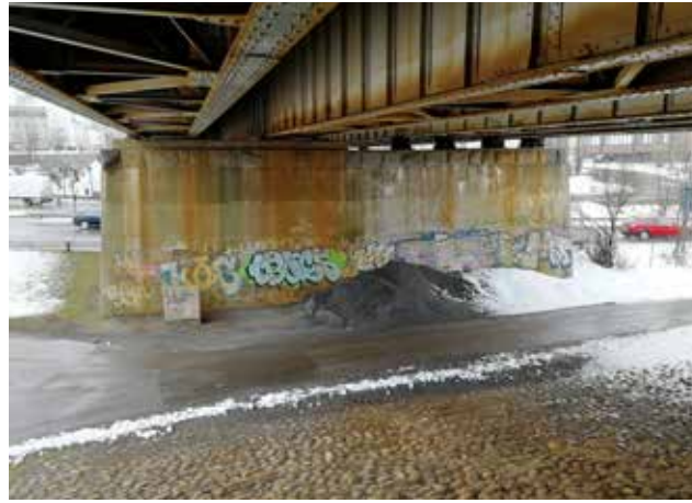
Eteläisempi välituki ja sillan ali kulkeva Viinikanpolku. Huomaa välituen ylin kiviladonta ja sen alapuolinen betonointi. Huomaa myös kahden läntisen raideparin tuennan korkeusero kahteen uudempaan itäiseen raidepariin nähden ja viisto sauma välituessa näiden kahden välillä.
