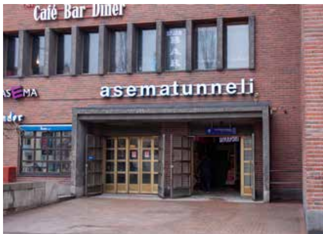
Asematunnelin sisäänkäynti Asema-aukion puolelta. Eloksoidut alumiinisiliukuovet käyttöovina. Saranaovent ovat mahdollisesti 1989-90 Asematunnelin rakentamisen ajalta ja liukuovet lisätty myöhemmin.
