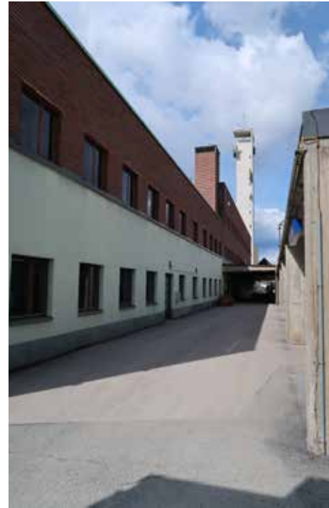
Laiturin puolella on julkisivussa jäljellä rappaus, mutta sen sävy on vaalean vihreä. Hilseilevän vihreän maalin alta näkyy paikoin vanha vaalea kalkkimaali.
