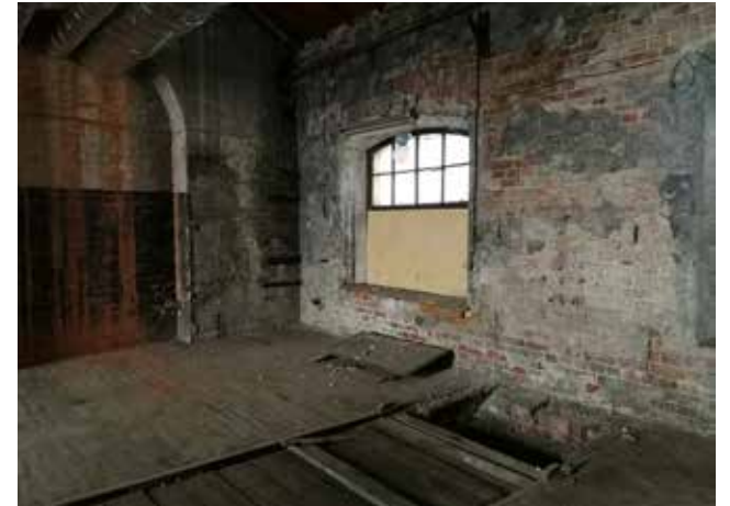
Pilttuun takaosa ja portaat monttuun.
