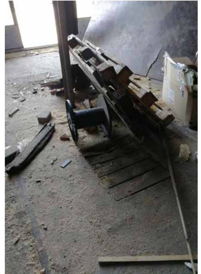
Lattian betonivalu ja pilttuumonttua varten jätetty ja laudoilla peitetty tarkastusaukko.
