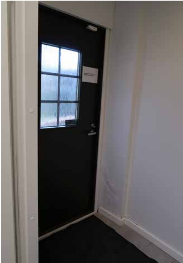
Kiinteistöyksikön käyntiovi Talousrakennuksen päädyssä.
