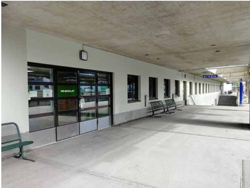
Aulan sisäänkäynti asemalaiturilta. Sivuovi pohjoissiipeen taempaan portaiden edessä.
