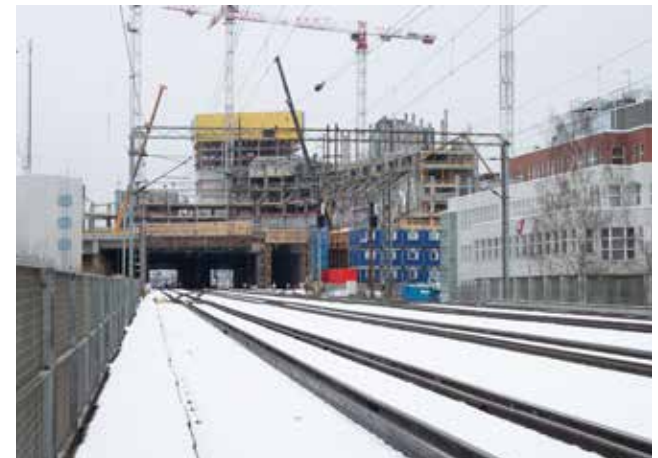
Näkymä neljän raideparin sillalta pohjoiseen.
