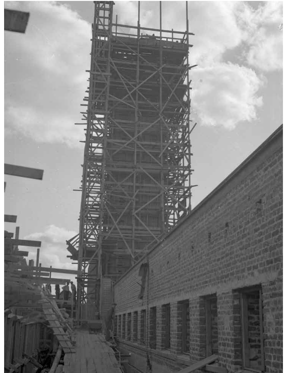
Torni rakenteilla. Samassa kuvassa huomataan, miten rapattavaksi suunniteltu julkisivu on muurattu. Kuva Vapriikin kuva-arkisto, Aamulehden arkisto, kuvaaja K. O. Lumme.
