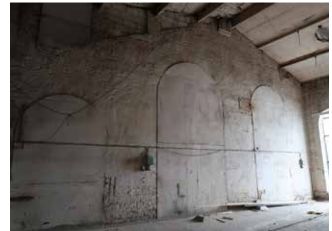
Vuoden 1934 laajennuksen katto-osan tuenta.
