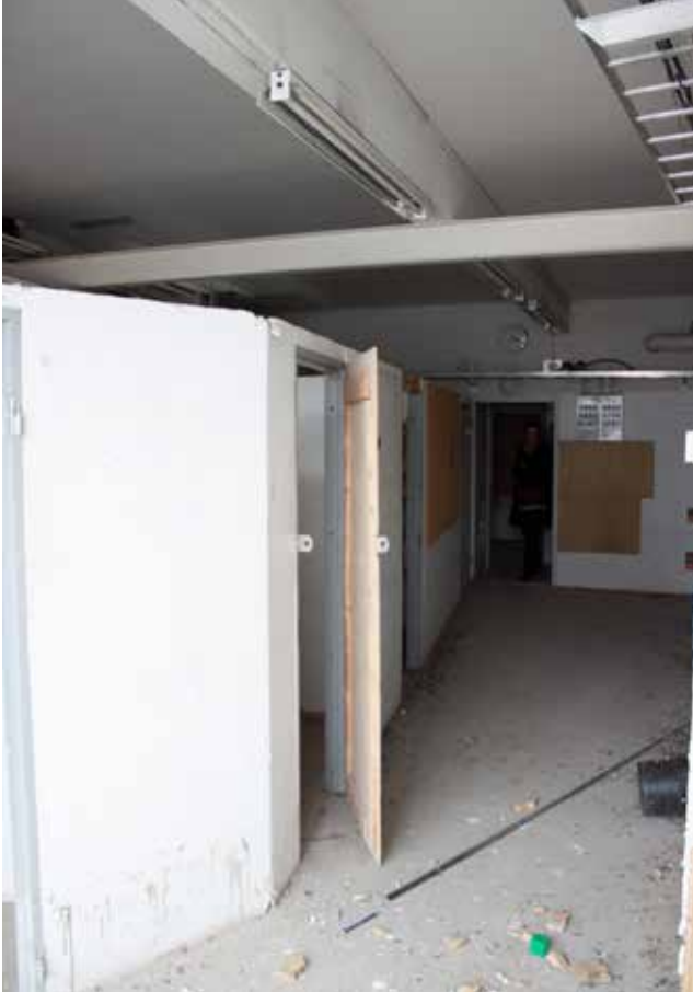
Entiseen toimistotilaan rakennettuja työaatoimistovaiheen koppeja.
