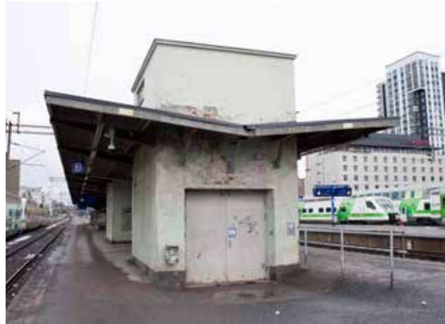
Ensimmäisen välilaiturin katos etelästä katsottuna. Kuvassa käytöstä poistettu eteläinen Matkatavaratunnelin hissitorni. Huomaa teräskaide luiskan reunalla. Luiska on syntynyt laiturialuetta korotettaessa 2001.
