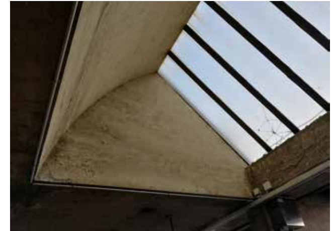
Asemalaiturin vino, lankalasettu kattoikkuna.
