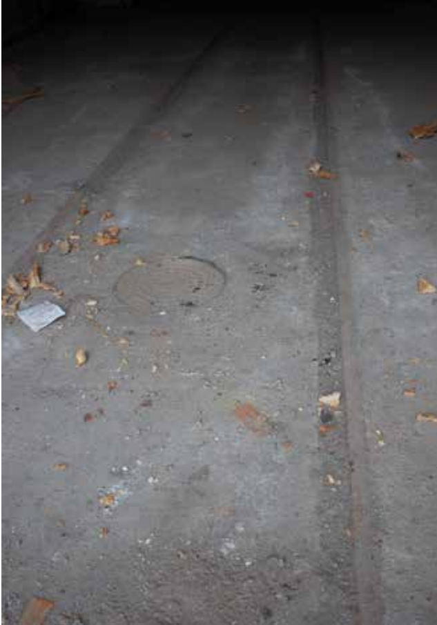
Valettu betonilattia on mahdollistanut raiteiden käytön, vaikka piltuumonttu on peitetty. Raiteiden ura on täytynyt tai täytetty myöhemmin irtonaisella maa-aineksella.
