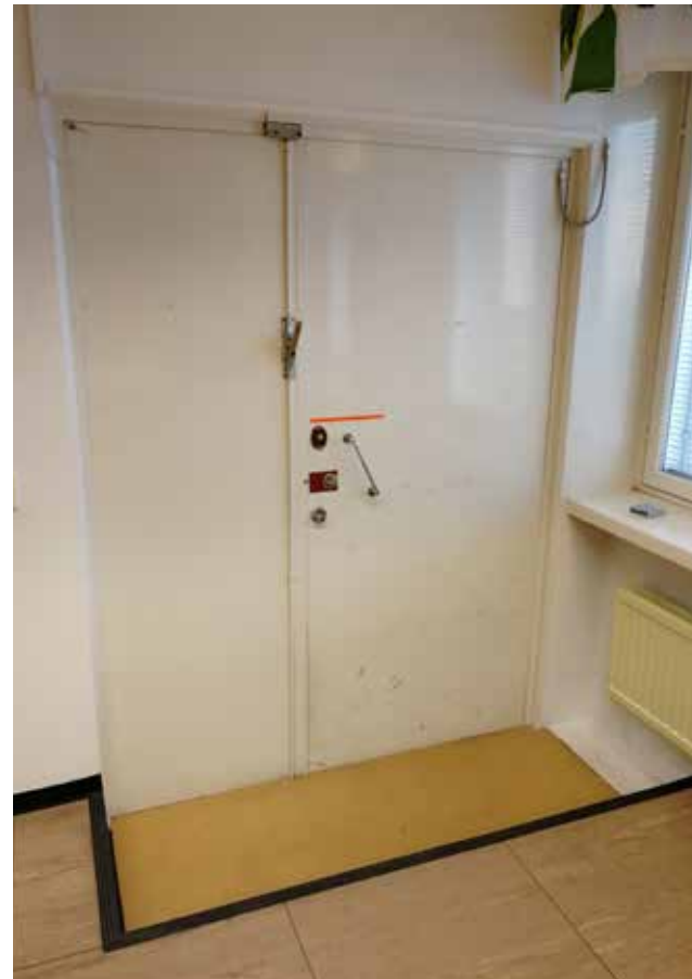
Lattiankorotus länsisiipeen astuttaessa alapuolisten sähkökaapelointien takia.
