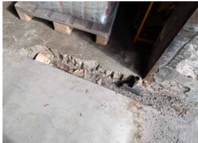
Lataushuoneen sisäänkäynnin ramppi.
