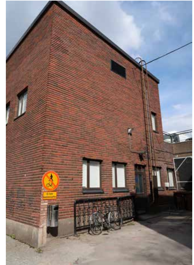
Kellarikerroksen eteläpään sisäänkäynti entisiin tauko-, pesu- ja pukutiloihin ja toimistoon. Nyt VR:n ravintolapalvelujen, Avecran, tukikohtana. Huomaa myös seinäritilä IV-konehuoneen kohdalla. Tämä on entinen "keittiöpiha", joka oli alun perin rajattu tiilimuurilla, joka kulki länsijulkisivun tasossa.
