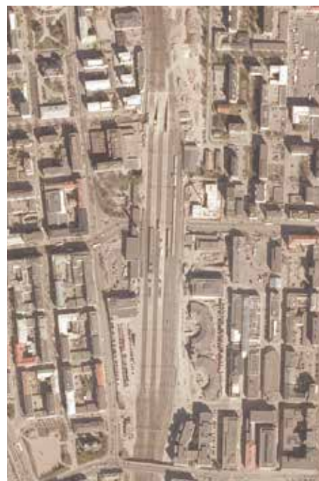
2011 Aseman eteläpuolelle on valmistunut Matkakeskustunneli, josta nousee uusia portaita ja hissejä laitureille. Asema-aukiolle rakennetaan P-Hämpin sisäänkäyntiä aseman eteläisen siven eteen. Välilaituri on levennetty myös pohjoispäädystään tasalevyiseksi. Eteläisin veturitalli on purettu ja paikalla on uudisrakennus. Tullin puolella on valmistunut uudisrakennus pohjoisen veturitallin viereen ja veturitallien taakse on tehty pysäköintikansi. Veturitallien edestä on johdettu uusi katulinja.
