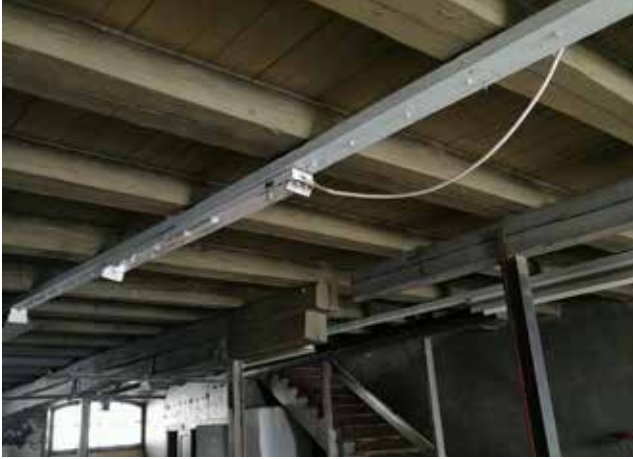
Pilttuun välipohja teräspilareineen ja puupalkkeineen.
