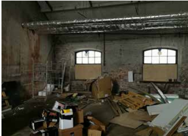
Takaseinän ikkunat ja eristetyt lämpölinjat ripustusrautoineen.
