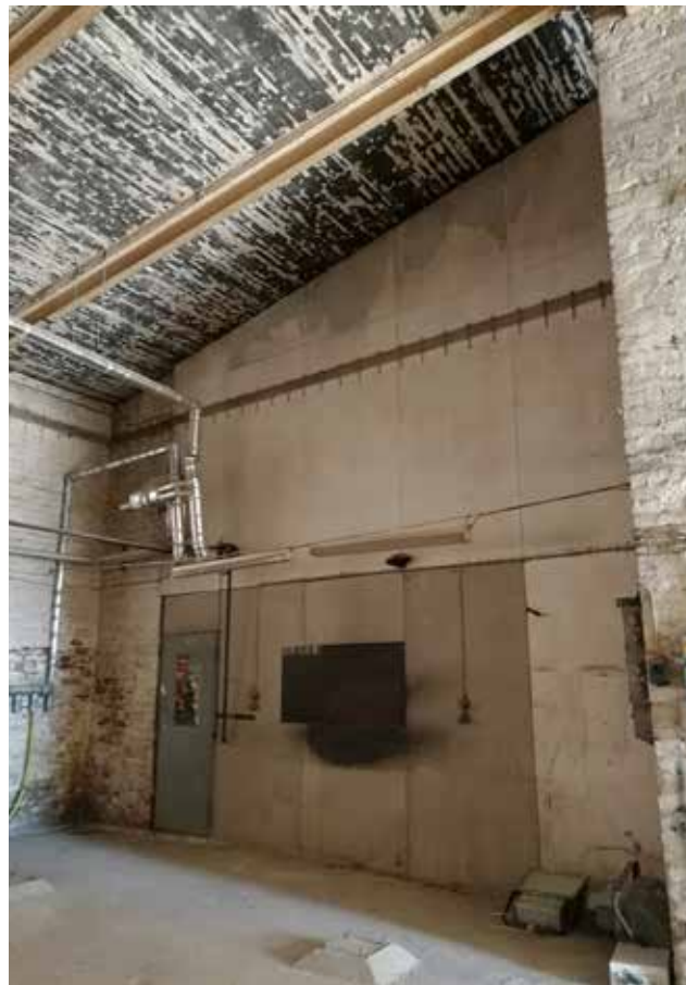
Pilttuun takaosan nurkka, teräspalo-ovi ja pilttuiden välinen palo-osastoiva levytys. Vuoden 1934 suunnitelmassa näissä kohdissa on aukko, ei seinää.
