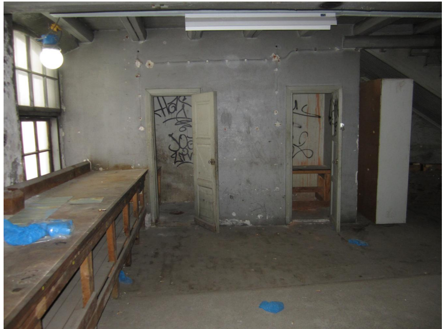
Etelästä lukien viidenteen pilttuuseen vuonna 1934 rakennetut suihkukopit. Valokuva: Panu Savolainen.
