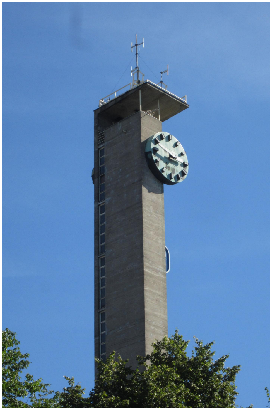
Torni Itsenäisyydenpuistosta. Erityisesti luoteesta (kuvassa) mutta myös lännestä ja lounaasta nähtynä tornin rakenteellinen oivaltavuus ja ohuen massan vaikutelma pääsee oikeuksiinsa. Valokuva: Panu Savolainen.
