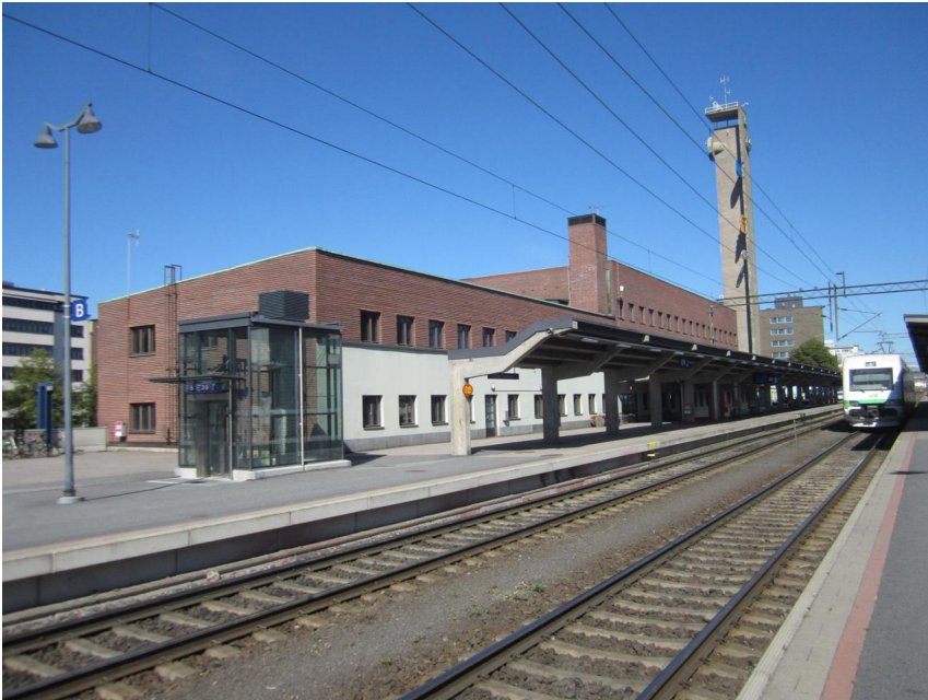
Rautatieaseman julkisivumateriaalien nelijako tiili–rappaus–klinkkeri–betoni (sekä länsijulkisivun koristeosien terastirappaus) on alkuperäinen, ja se noudatti käytännöllisiä lähtökohtia. Laiturialueen valkoisen julkisivun oli tarkoitus parantaa katoksen alaisen alueen valaistusta. Valokuvat: Panu Savolainen.
