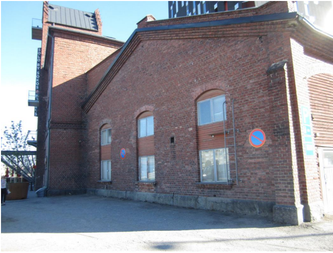
Veturitallin pohjoisessa länsiseinässä ikkunat ovat peräisin vuonna 1947 toteutetusta muutoksesta, jolloin pilttuu jaettiin kanteen kerrokseen. Valokuva: Panu Savolainen.
