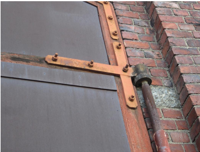
Kahden pilttuun ovesa on yhä jäljellä alkuperäisiä saranoita. Valokuva: Panu Savolainen.
