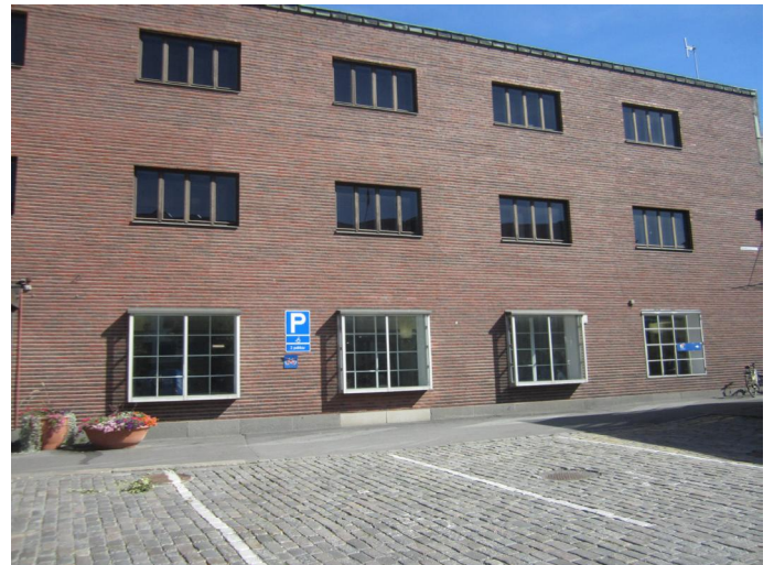
Eteläisen siiven läntisen julkisivun ikkunoissa ja ovissa 1930-luvun jälkeiset muutokset (2008) ovat näkyvimmin esillä. Muutokset johtuvat julkisten tilojen esteettömyysvaatimuksista. Valokuvat: Panu Savolainen.
