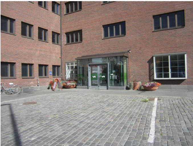
Eteläisen siiven läntisen julkisivun ikkunoissa ja ovissa 1930-luvun jälkeiset muutokset (2008) ovat näkyvimmin esillä. Muutokset johtuvat julkisten tilojen esteettömyysvaatimuksista. Valokuvat: Panu Savolainen.
