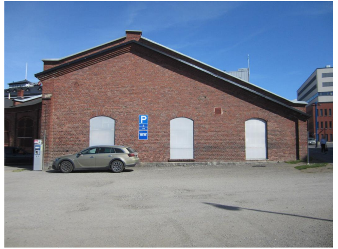
Veturitallin eteläisessä länsiseinässä ikkunat ovat säilyneet alkuperäisinä, mutta lämmöneristyssyistä ne on sittemmin laitettu umpeen. Valokuva: Panu Savolainen.
