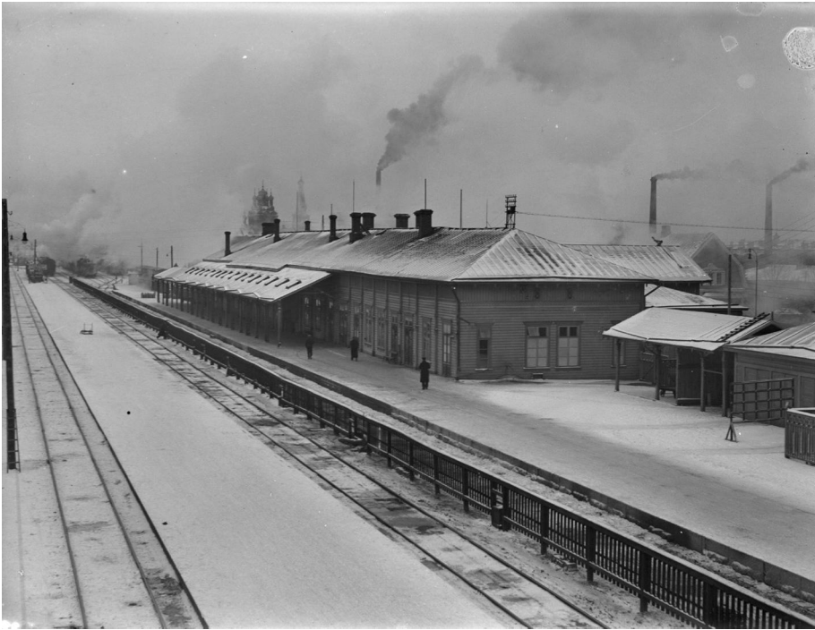
Tampereen vanha rautatieasema (valmistunut 1876) juuri ennen purkamistaan marraskuun lopussa 1933. Kuva on otettu rautatien ylittäneeltä puurakenteiselta sillalta, jonka korvaaminen alikululla oli yksi vuoden 1933 arkkitehtuurikilpailun vaatimuksista. Tampereen museoiden kuva-arkisto.
