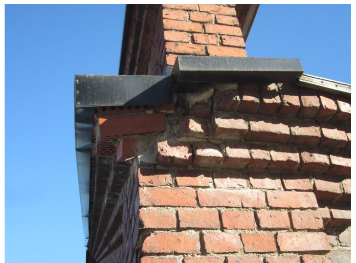
Veturitallin lounaisnurkan räystääs on päässyt vaurioitumaan ja sitä on korjattu aavistuksen huolimattomasti. Valokuvat: Panu Savolainen.
