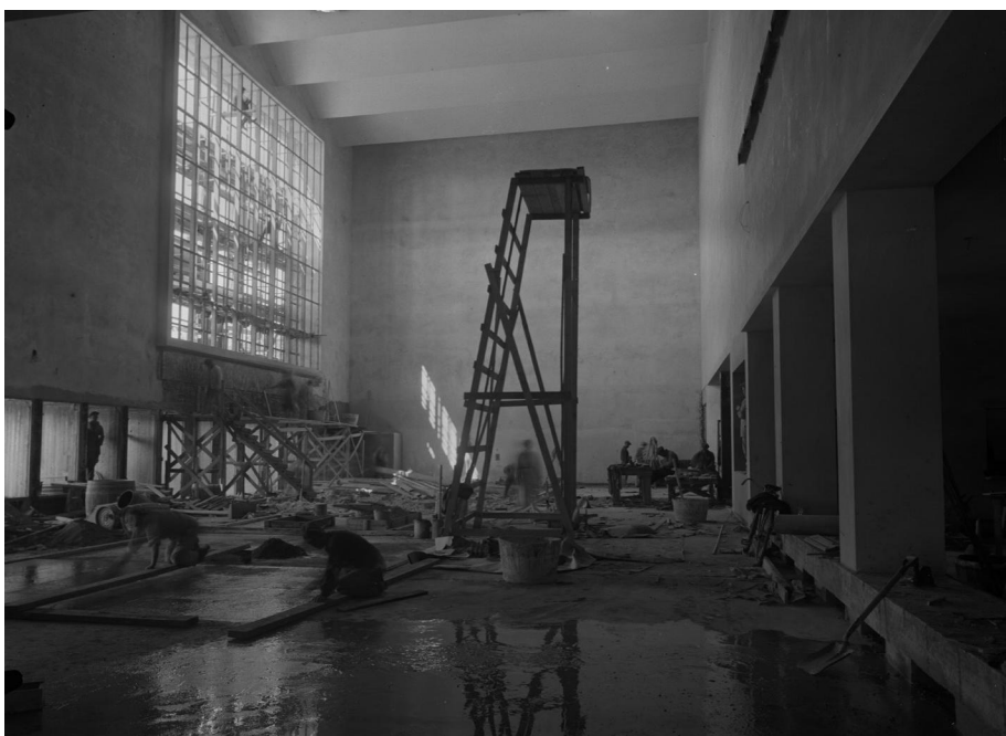
Asemahallin lattian betonivalu 10.7.1935. Tampereen museoiden kuva-arkisto.
