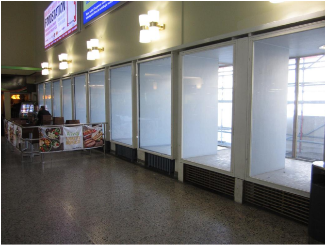
Näyteikkunoiden detajjiikka on alkuperäistä piirustuksissa määrättyä ikkunapenkkinen "norsunluunväristä linoleumia" myöten Valokuva: Panu Savolainen.
