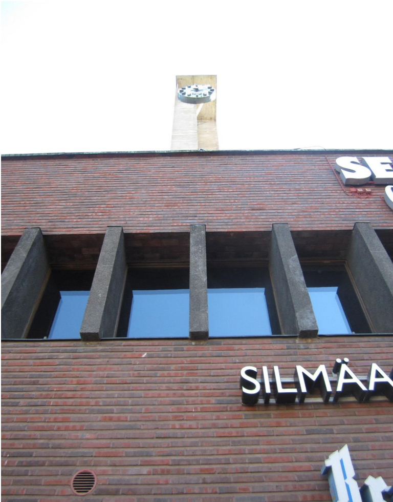
Asemaravintolan aukotusta ja asemahallin ikkunaa artikuloiva terastirappaus on säilynyt alkuperäisenä kauttaaltaan. Valokuva: Panu Savolainen.
