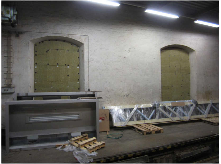
Eteläisimmän pilttuun länsiseinän ikkunat on peitetty lämmöneristeillä. Valokuva: Panu Savolainen.
