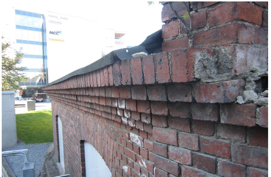
Räystäiden, kontreforien ja muurinharjojen tiiliprofiloinnit ovat veturitallin arkkitehtuurille yhtä olennaisia kuin rakennuksen kokonaishahmo. Valokuvat: Panu Savolainen.
