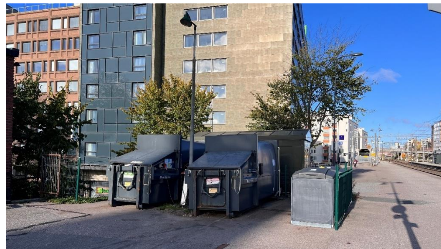
Kuva 19. Rautatieaseman jätepiste laiturin 1 pohjoisosassa.
