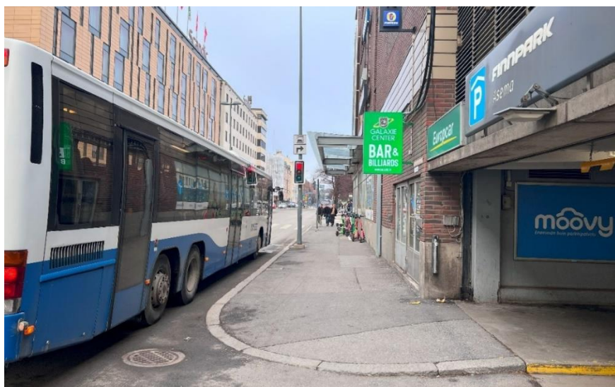
Kuva 9. Rautatienkadun itäreunan kapea yhdistetty pyörätie ja jalkakäytävä.
