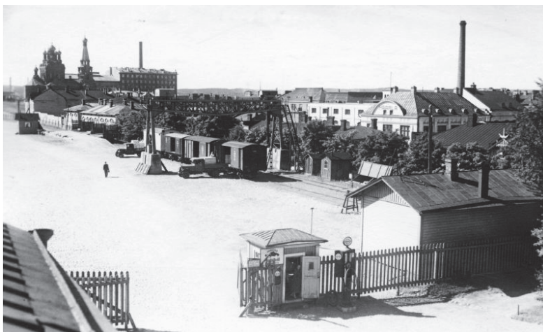
Tampereen ratapihaa etelään 1930-luvun tienoilla ennen uuden aseman rakentamista. Rautatienkadun varrella on matalia puutaloja. Katua reunustaa puurivi. Taustalla korttelin 188 sisäosaan sijoittunut Haaran paperitehdas takanaan Tampereen Pukutehdas. (Kuva: Tampereen museot, 1927-1939)
