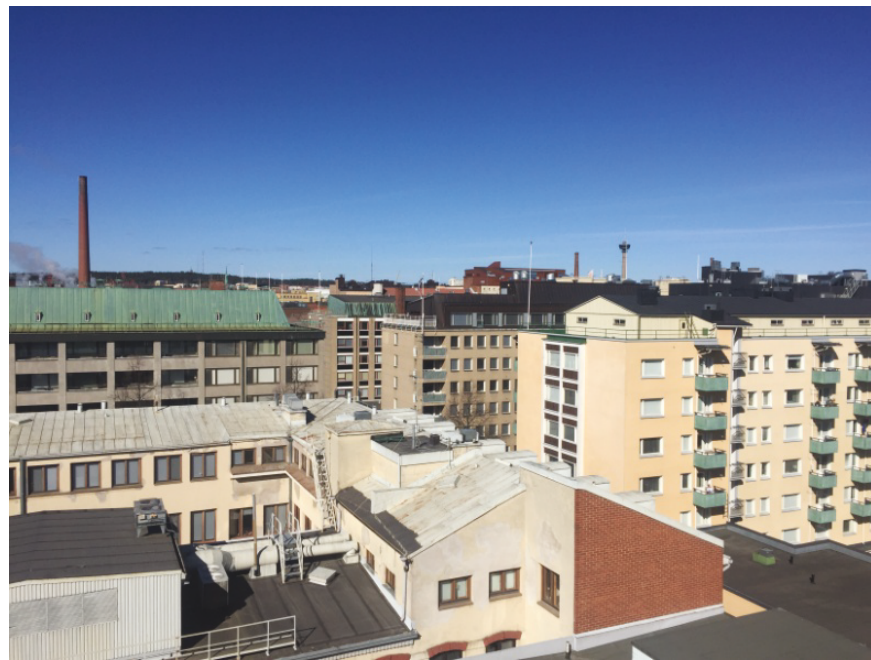
Tuomiokirkonkatu 19:n ylimpiä kerroksia.
