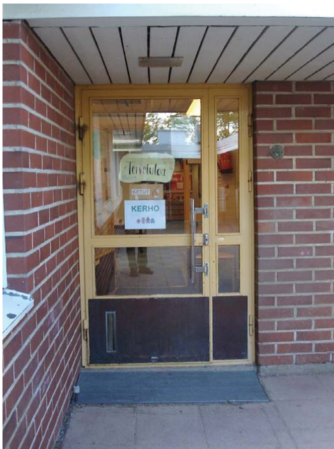
Kuva 17. Alkuperäinen teräslasiovi, myös helat ovat alkuperäisiä.
