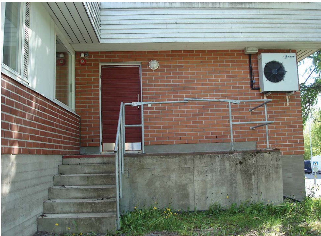
Kuva 11. Keittiön laajennus länsisivulla. Uusi muuraus poikkeaa sävyiltään alkuperäisestä ja oven vaakapanelointi vanhojen ovien pystyvuorauksesta.
