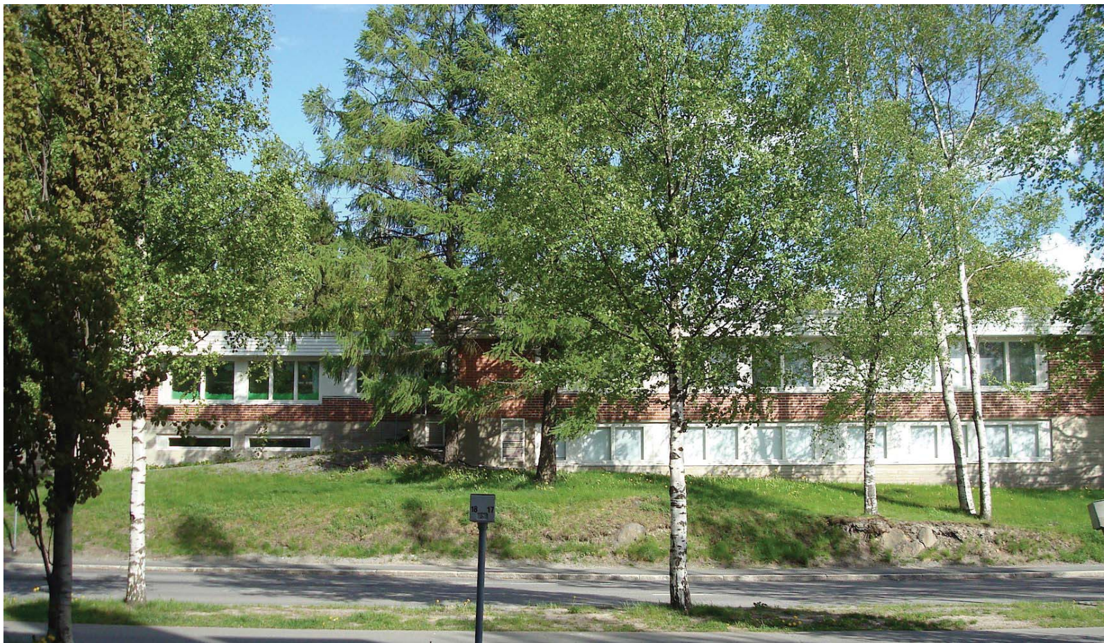
Kuva 12. Rakennuksen länsijulkisivu Pohtolankadulle.
