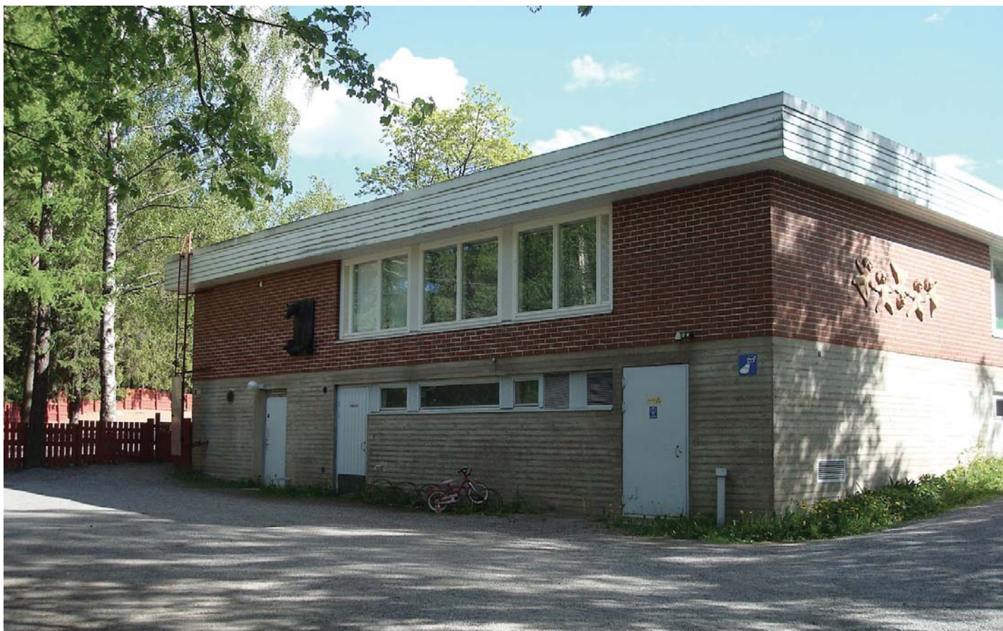
Kuva 8. Rakennuksen pohjoispääty ja huoltopiha.
