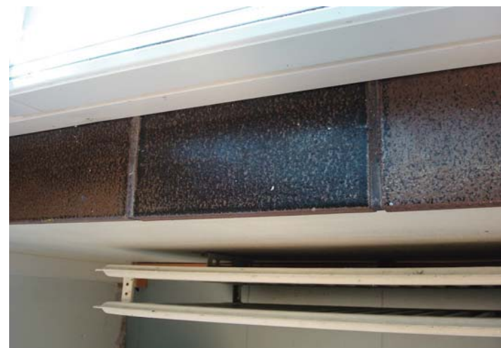
Kuvat 28-29. Pienten lasten osasto, uudempaa Hovi-laattaa ja alkuperäistä vinyylasbestilaattaa
