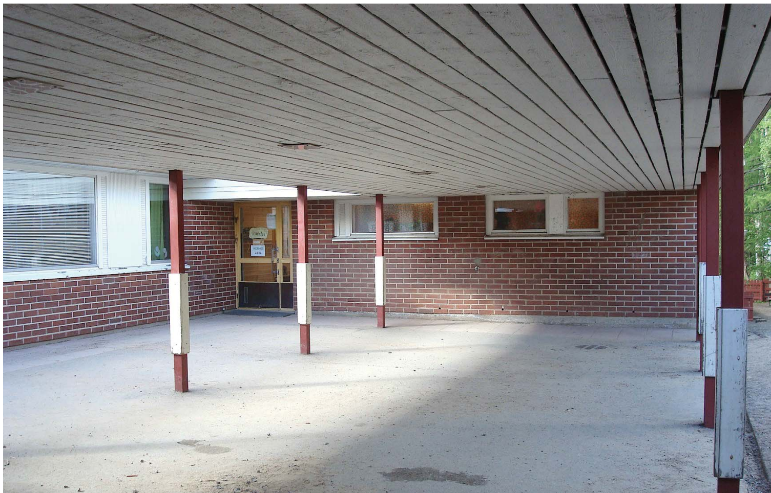
Kuva 16. Sisäpihan sadekatos ja tarhan pääsisäänkäynti.
