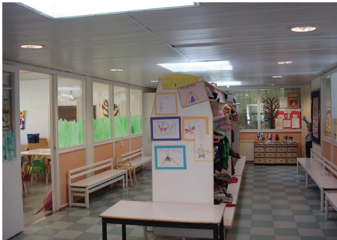
Kuva 22. Alkuperäisiä sisälaseineitä, kattoikkunat ja Lautex-kattoa aulassa.
