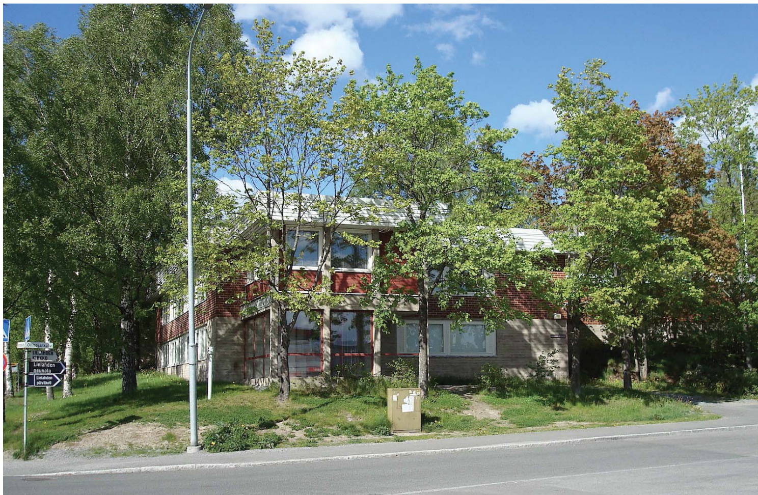
Kuva 13. Rakennuksen eteläpääty Ollinojankadulle.
