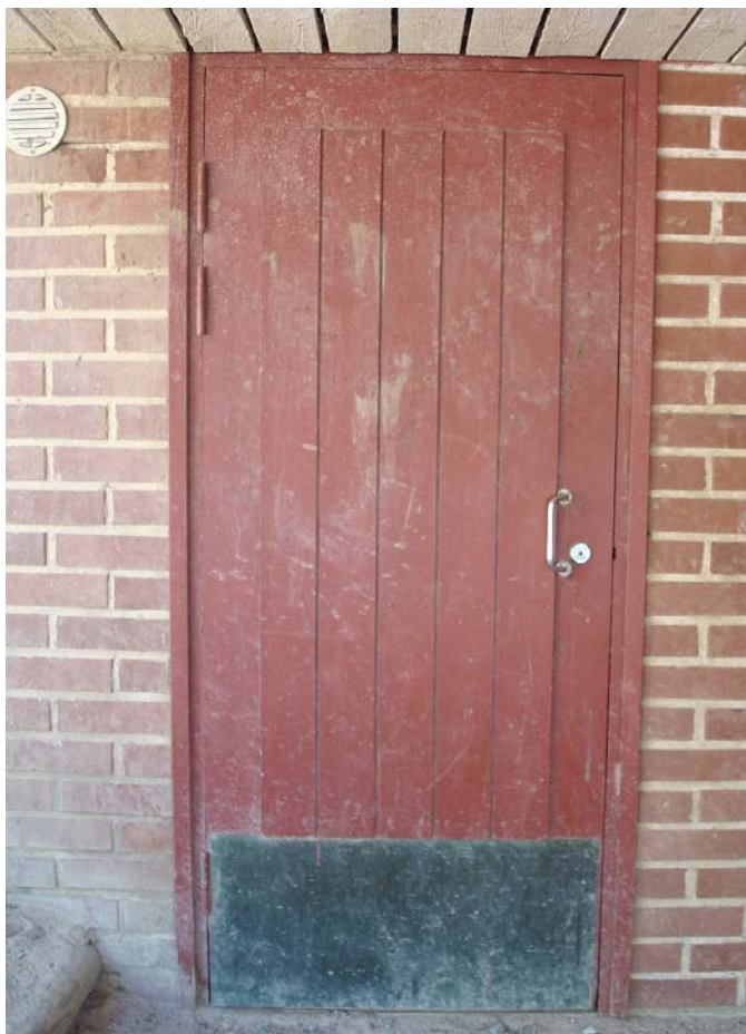
Kuvat 18 ja 19. Alkuperäisiä paneliovia, jotka suunnitelmissa on kuvattu lakatuiksi. Tähän viittaa myös potkupellin kupari, jota on käytetty ajalle tyypillisesti juuri kuultokäsiteltyjen ovien kanssa.
