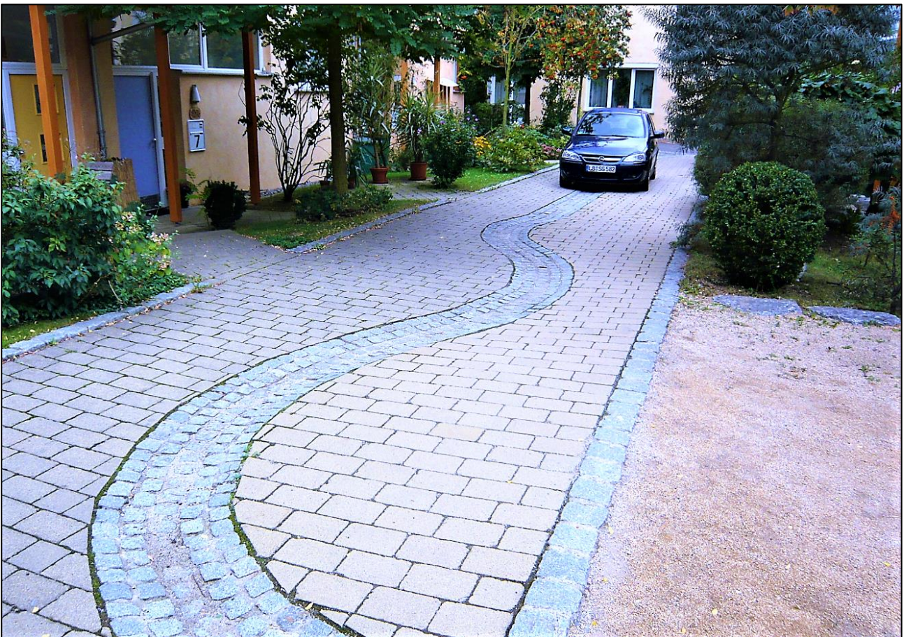
Kuva 10. Hulevesiä voidaan johtaa pihaa elävöittävässä kourussa (FCG).
