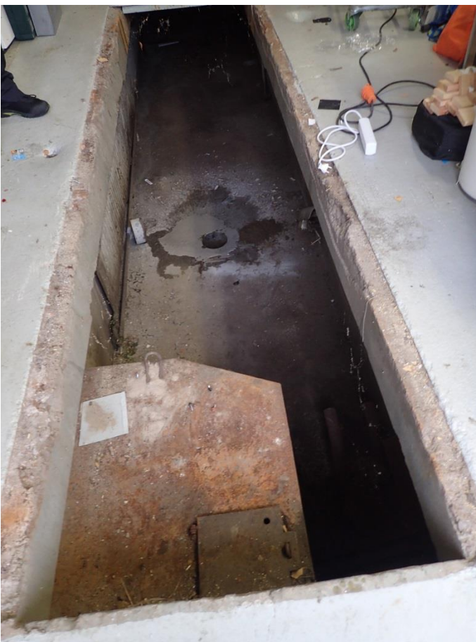
Kuva 4. Timanttikorattu näytteenottoreikä öljymontussa, P1.
