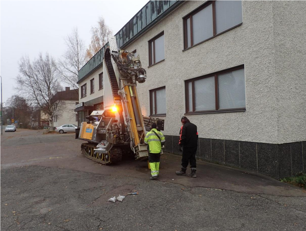
Kuva 1. Näytteenottoa kairakoneella Messukylänkadun puolella, KN4.
