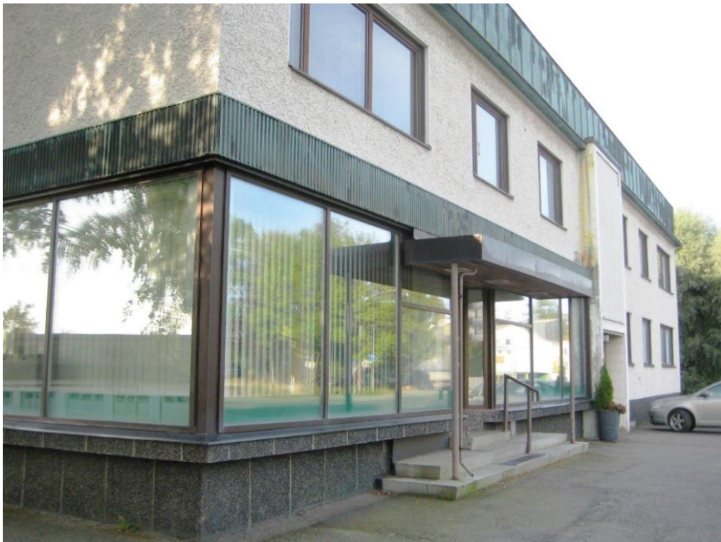
1960-luvun tyhjillään oleva liikehuoneisto toisen asuinrakennuksen alakerrassa.
