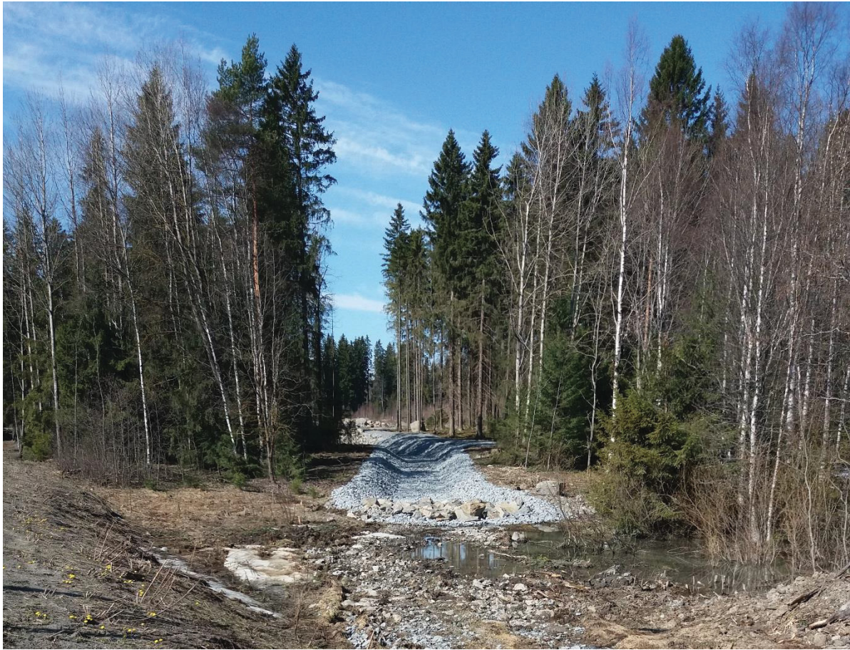
Kuva 3. Alueelle on rakennettu hulevesitulvareitti vuosina 2017 ja 2018 soveltuvan elinympäristön eteläosaan. Kuvattu 18.4.2018.
