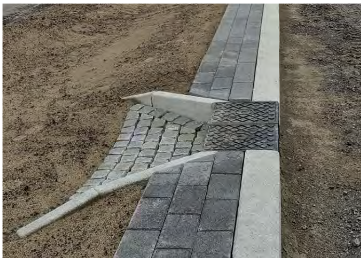
Kuva 4. Läpivirtaava kitakansisto Ojala-Lamminrahka -työmaalta, jolla ajoradan vesiä ohjataan reuna-alueelle + valmis suodatuspainanne Kuninkaantammessa (Ramboll).
