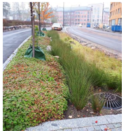
Kuva 4. Läpivirtaava kitakansisto Ojala-Lamminrahka -työmaalta, jolla ajoradan vesiä ohjataan reuna-alueelle + valmis suodatuspainanne Kuninkaantammessa (Ramboll).
