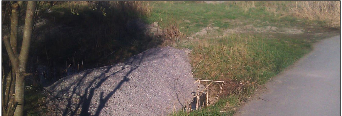
Kuva 8. Avo-ojan eteen rakennettu väliaikainen suodattava murskepato. Turku, Haarlanlahti. 8
