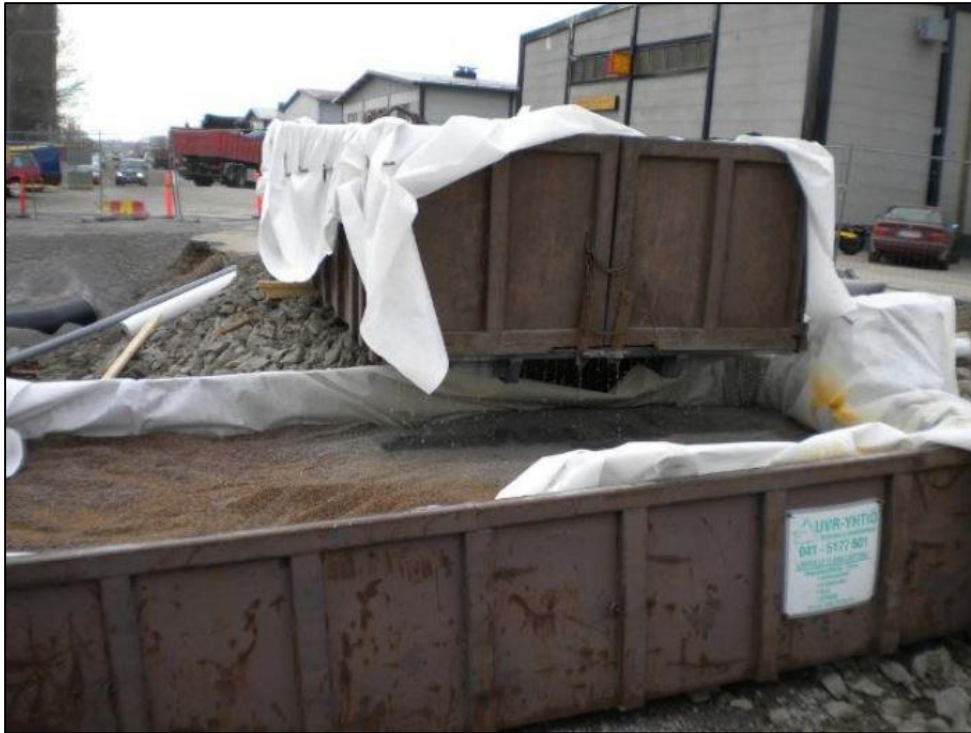
Kuva 9. Esimerkkikuva konttiselkeyttimestä. 9
