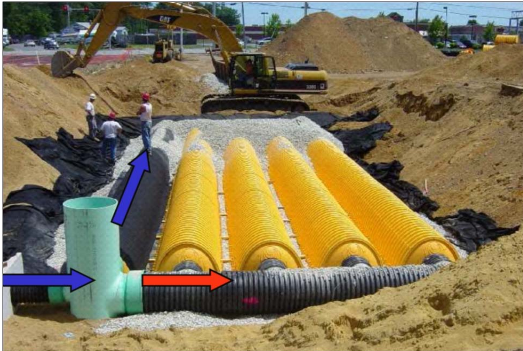
Kuva 10. Maanalainen viivytysrakenne, jossa myös hulevesien laadun hallintaa 18 .
