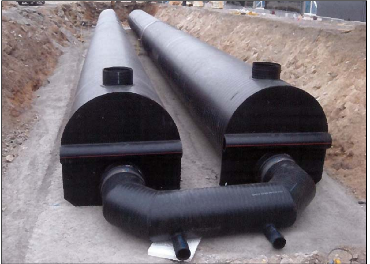
Kuva 9. Maanalainen viivytysjärjestelmä. 17
