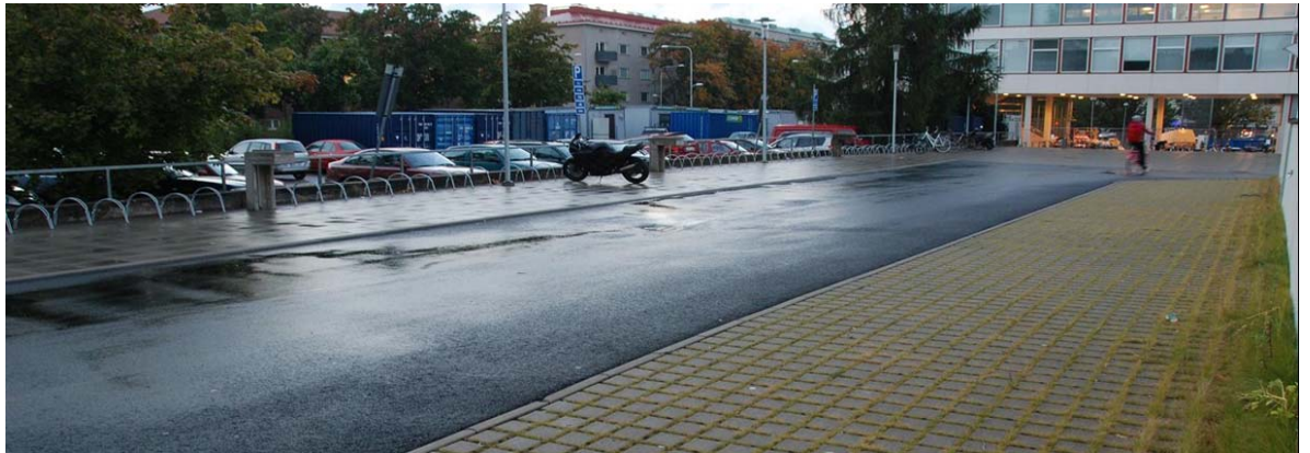
Kuva 7. Vettä läpäisevä päällyste Tampereen Sampolassa. 12
