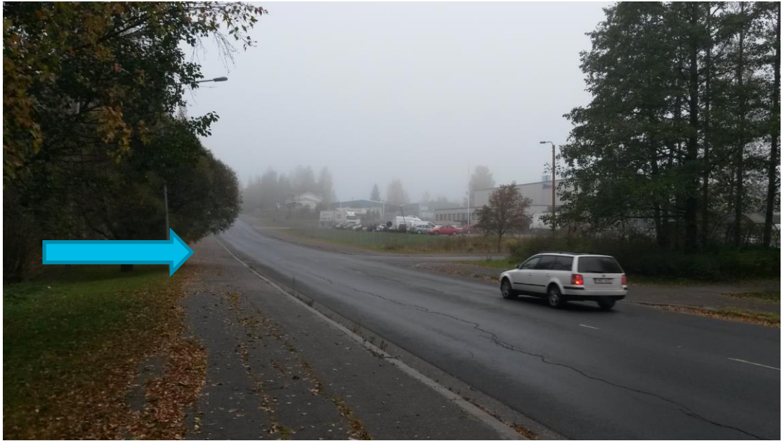
Kuva 14. Niittyhaankadun ja Keskuvainionkadun risteys, vesi voi levitä kadulle nuolen suunnasta
