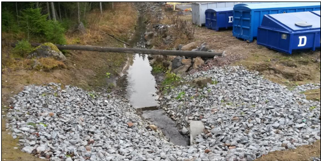
Kuva 19. Yhtenäinen avouoma päättyy Deleten tontin alittavaan 800B rumpuun.
