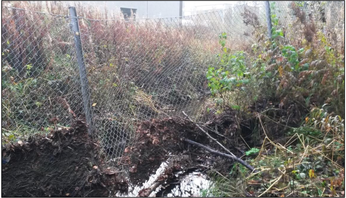
Kuva 12. Tauskonoja alittaa Santenin verkkoaidan, joka kerää roskia ylivirtaamalla
