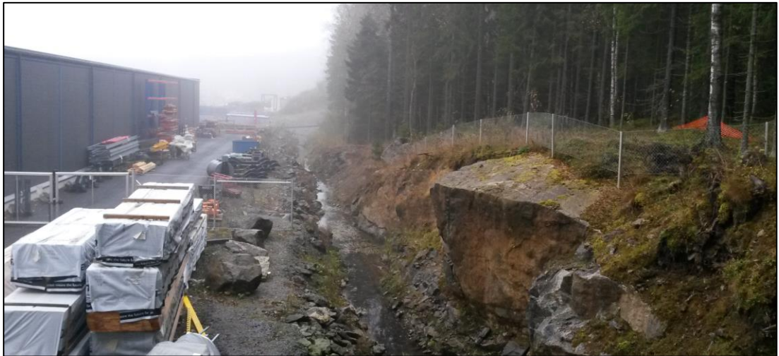
Kuva 18. Tauskonkatu 22 eteläreunassa uoma on osin louhittu kallioon.
