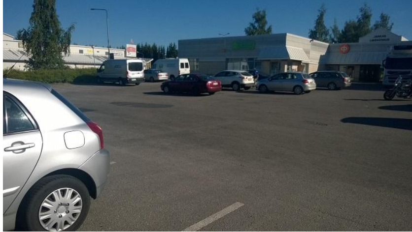
Kuva 2. Tontilla 2 sijaitsevan liikerakennus ja paikoitusalue.
