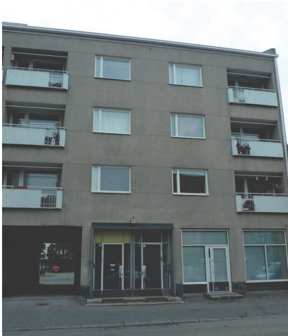
Näsilinnankatu 40:n katuulkisivua. (kuva: LSV Arkkitehdit Oy 2015)
