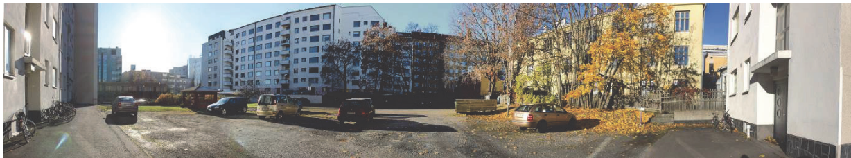
Näkymä korttelin 31 sisäpihalta lokakuussa 2015. (kuva: Tampereen kaupunki)
