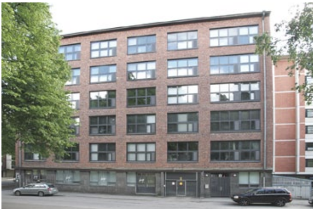
Branderin kenkätehdas (Bertel Strømmer 1919) on valittu arvokkaaksi rakennuskulttuurikohteeksi Tammelassa. Rakennus on muutettu asuin- ja liikekäyttöön.
