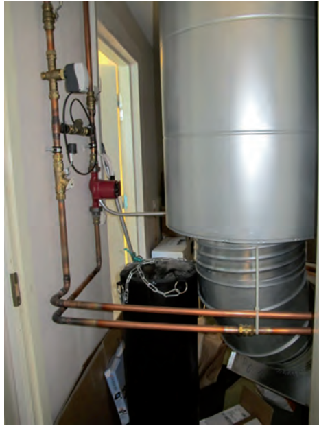
Pirtin iv-laite on sijoitettu komeroon.
