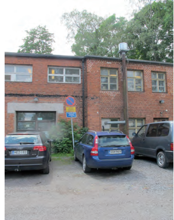
Vanhimman osan päälle rakennettiin toinen kerros vuonna 1959 (arkkitehti Jaakko Ilveskoski). Vanhimman osan pohjakerroksen ikkunat ovat 4-ruutuisia ja toisen kerroksen ikkunat 6-ruutuisia.
