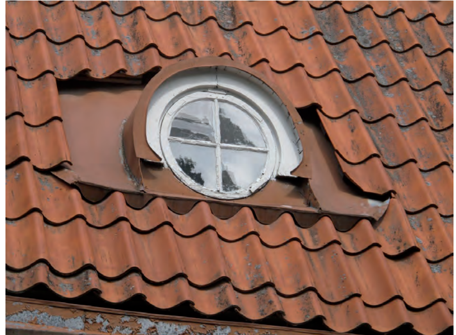
Alkuperäinen kattolapteen ikkuna.
