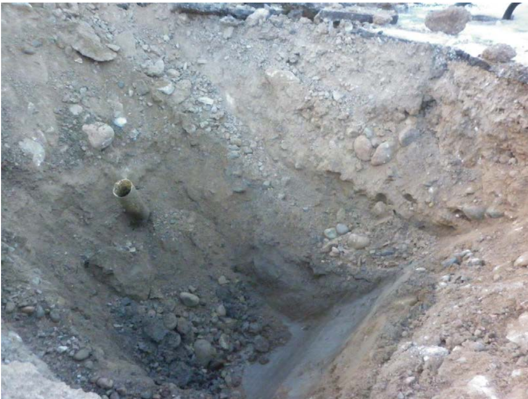
Kuva 4. Koekuoppa KK2. Kuvassa myös salaojaputki.
