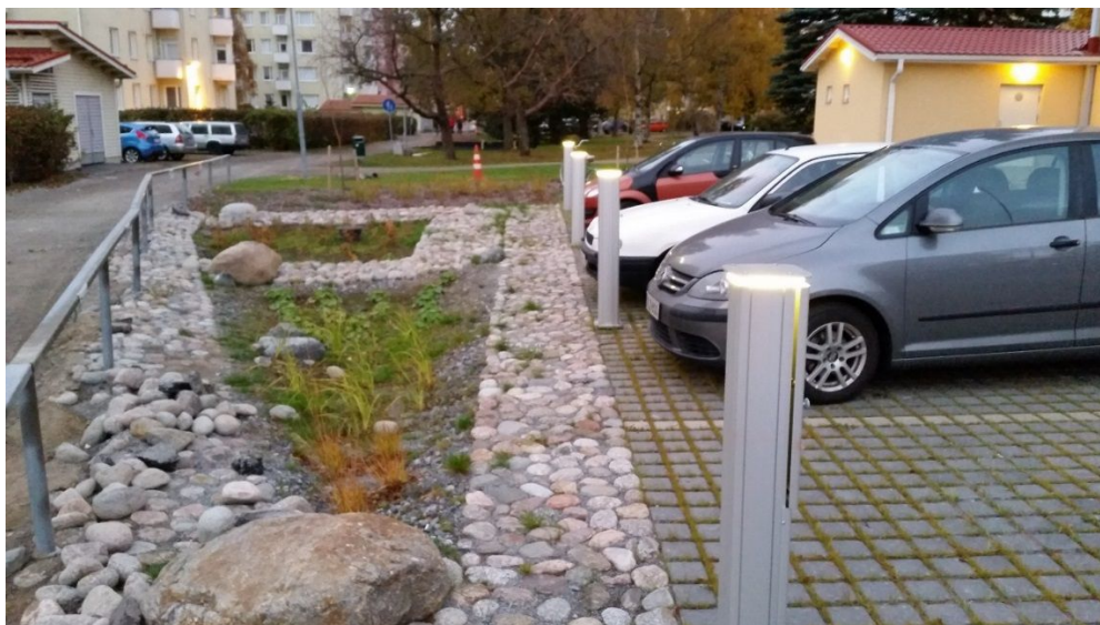
Kuva 2 Esimerkki pysäköintialueen huleveden imeytys- tai viivytysoikeudesta (kuva: Pekka Heinonen)
