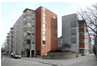
Palvelukeskuksen puolta Itsenäisyydenkadun kulmasta.
