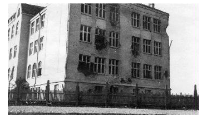
Vuoden 1918 taistelujen jälkiä Tammelan kansakoulun seinässä. Lähde: Siiri.
