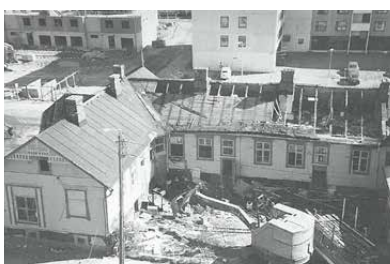
Purkutyömaata. (kuva: Mattilan Perheen kokoelma; Wacklin 1997, 104.)
