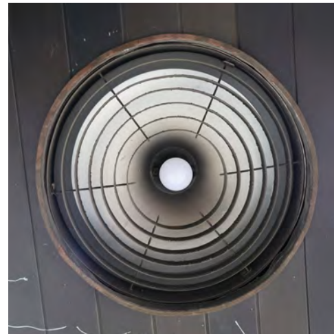
Pyöreä muototeema ulottuu myös rakennuksen alkuperäisiin valaisimiin. Sisäänkäyntien tummiin alumiinipintoihin on upotettu ympyrävalaisimia.
