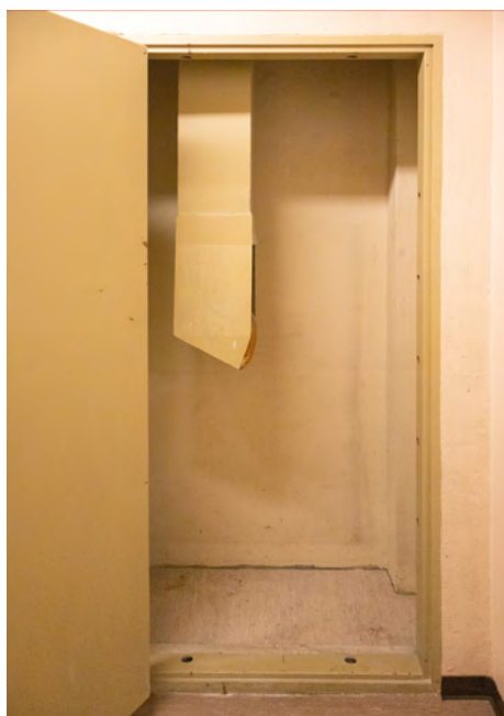
Valokuvia kellarikerroksen tallelokero-tilasta. Yläkerran pankkiholvista sai siirrettyä rahaa suoraan kellariin omaa kuljetuskanavaa pitkin. Tilassa on säilynyt alkuperäinen keltainen metallialakatto. Toinen oviaukoista on puhkaistu tilaan 1990-luvulla.
