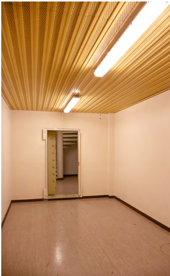
Valokuvia kellarikerroksen tallelokero-tilasta. Yläkerran pankkiholvista sai siirrettyä rahaa suoraan kellariin omaa kuljetuskanavaa pitkin. Tilassa on säilynyt alkuperäinen keltainen metallialakatto. Toinen oviaukoista on puhkaistu tilaan 1990-luvulla.
