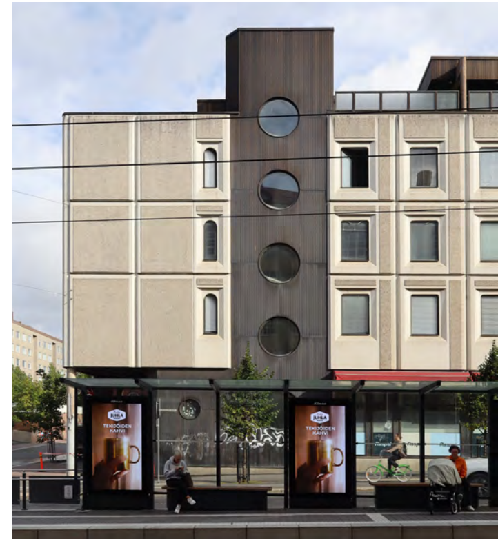
Etelään avautuvaa TOAS Ilmarin julkisivua; Pesubetonipintaa, elementtiruudukkoa, porrashuoneen pyöreitä ikkunoita ja tummaa anodisoitua alumiiniverhoilua
