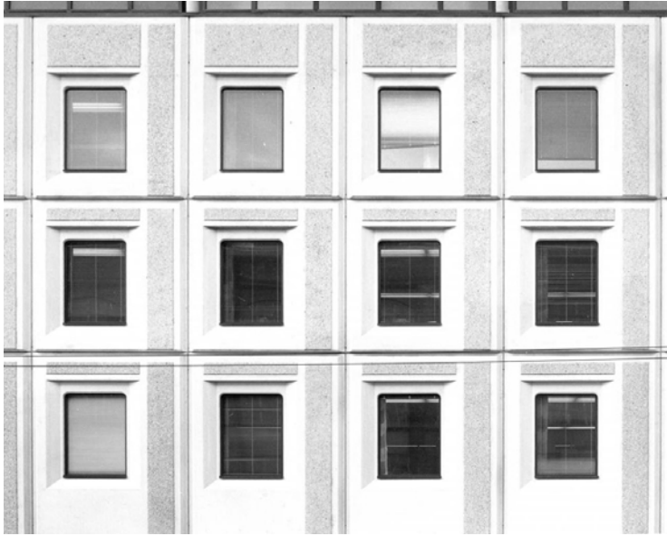
Suomen Työväen Säästöpankin konttorin betonielementtejä 1970-luvulla. Rakennuksen alkuperäiset julkisivuelementit toimitti Rakennusvalmiste Oy:n elementtitehdas Forssasta. FM
