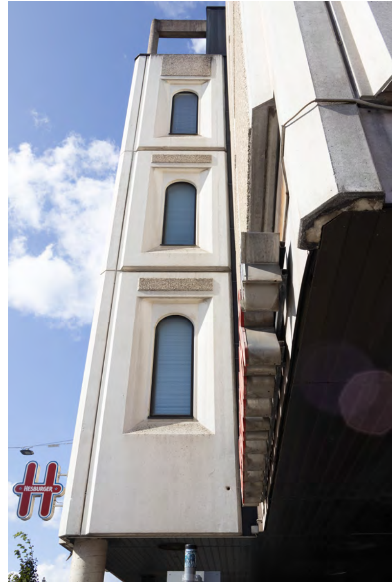
Tammelan puistokadun ja Itsenäisyydenkadun risteyksestä näkee, kuinka rakennuksen kantava pilari-palkkilinja jatkuu ullakkokerrokseen saakka.
