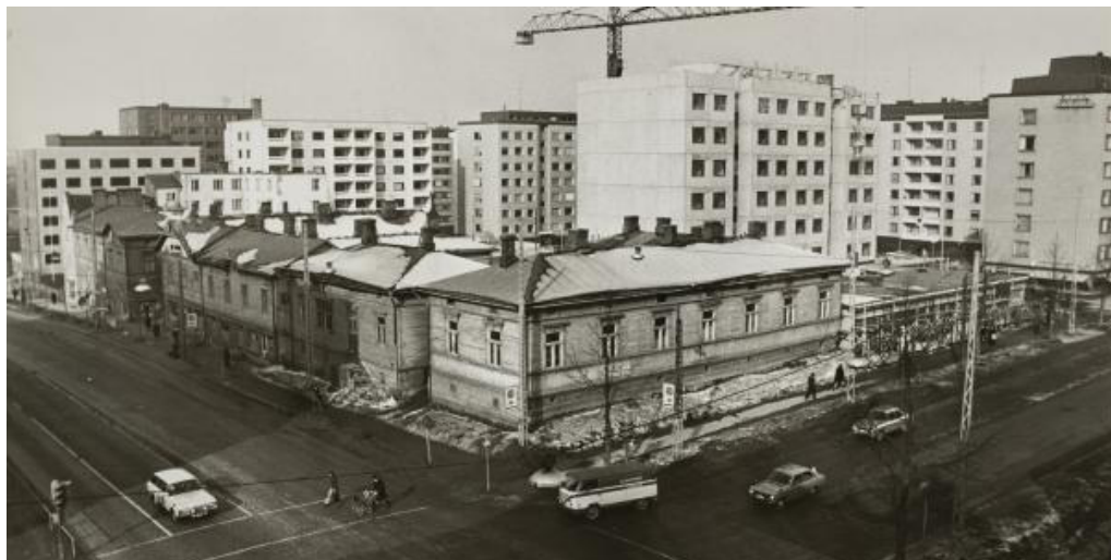
Tammelaa vuonna 1975. Ennen STS:n toimitaloa Itsenäisyydenkadun ja Tammelan puistokadun risteyksessä sijaitsi puurakenteisia kauppa- ja asuinrakennuksia, joissa toimi muun muassa Valion kauppa sekä Arvo Tanskasen elintarvikeliike. Puutalot purettiin Tammelan uudistumisen myötä 1960-luvun lopulta alkaen. Nyt on käynnissä jo seuraava uudistumisvaihe, jossa 1960- ja 70-luvuilla rakennettuja on jo purettu tai ovat purku-uhan alla. Esimerkiksi puutalojen takana näkyy vuonna 1961 valmistunut Rastin opiskelijatalo, joka purettiin vuonna 2018. Veikko Sepänen 1975. TA
