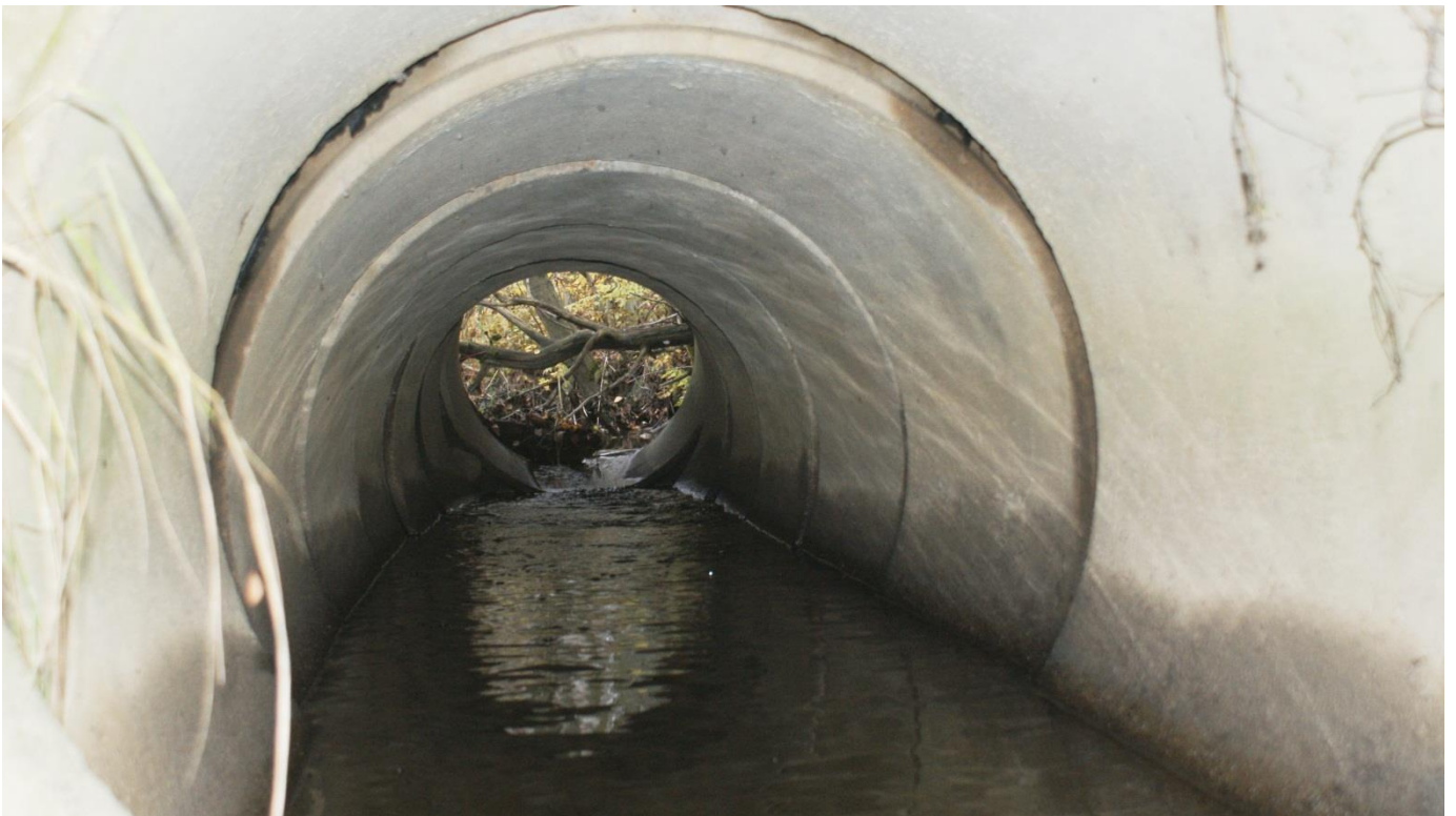
Kuva 3. Kevyen liikenteen väylän alittava rumpu 1000 B (notkahtanut)
