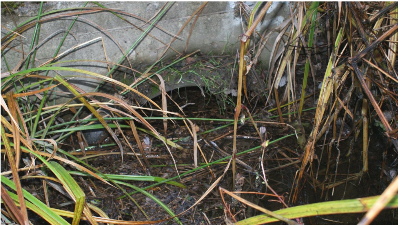
Kuva 1. Ratarummun (800 T) purkupää. Vapaata aukkoa n. 15 cm. Aukosta lietteessä noin 20 cm
