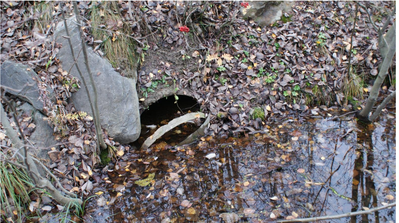
Kuva 14. Meluvallin rummun yläpää.
