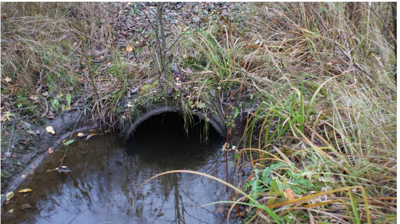
Kuva 4. Ratarummun (800 B) alapää. Pohjalla lietettä.
