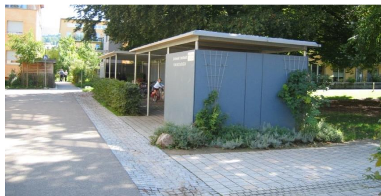
Esimerkki polkupyöräkatoksesta (Freiburg)
