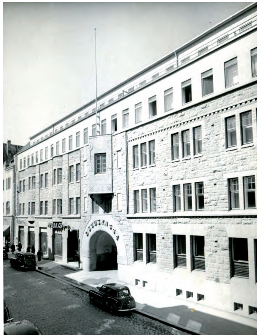
Korotettu pankkirakennus 1950-luvun puolella välissä. Kuva Tampere - Seura ry.
