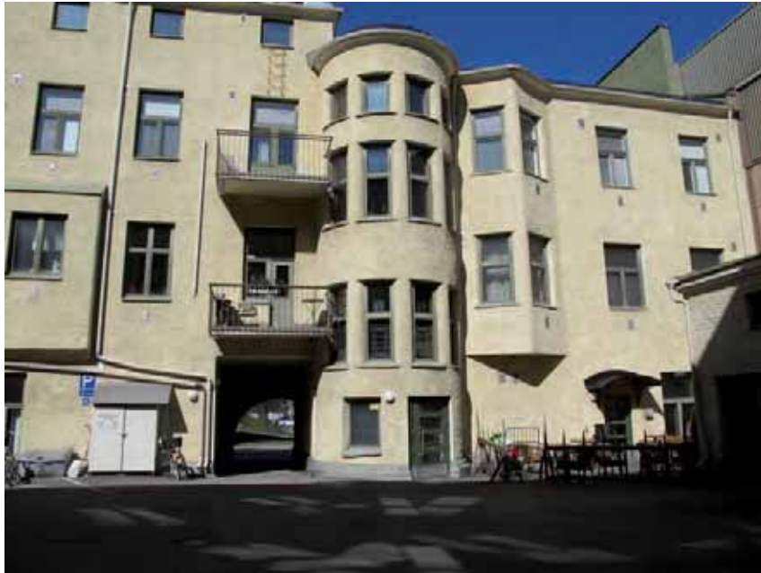
Ravintolan/päärakennuksen takajulkisivu, jossa on pyöreä porrashuone ravintolakerrokseen.
