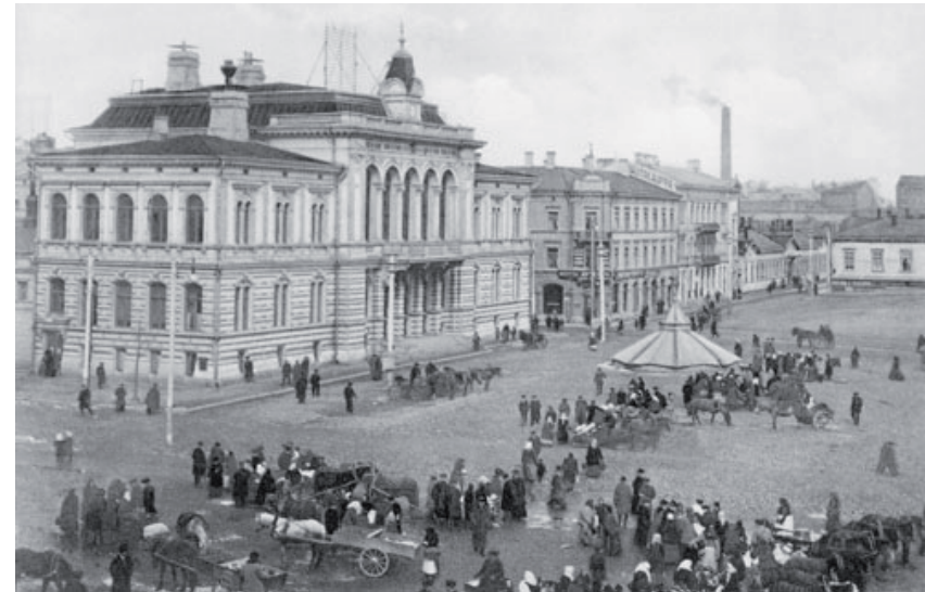
Keskustori 1900-luvun alkupuolelta. Sandbergin talon jatkeena on vielä Seura-huoneen talo, joka purettiin vuonna 1979. Kuva Tampere-Seura.
