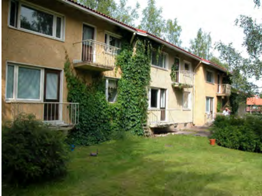
1950-luvun puolivälin rapattupintainen 7-asunnon rivitalo (Majavankatu 4).
