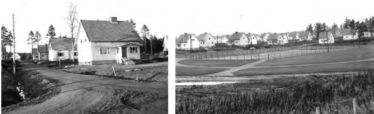
Vasemmalla: Omakotitaloja Ahmankadun varrella keväällä 1953. Etualalla Ahmankatu 15 kuvattuna Sundenkadun risteyksestä kohti pohjoista. Kuva: Tampereen museot/ Kuva-arkisto.
