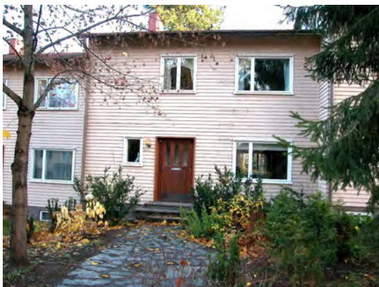
Julkisivuiltaan limilaudoitettu ja rakennusmassaltaan yhden asunnon osiin porrastettu rivitalo (Karhunkatu 6).
