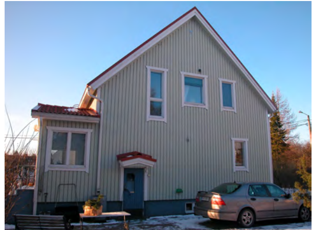
1950-luvun alun omakotitalo, jonka seinät on vuorattu peiterimoitettulla pystylaudoituksella (Näädänkatu 1).
