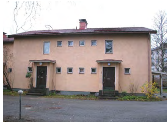
1950-luvun puolivälin Bertel Strömmerin suunnittelema, osittain elementtirakenteinen rivitalo (Majavankatu 8).
