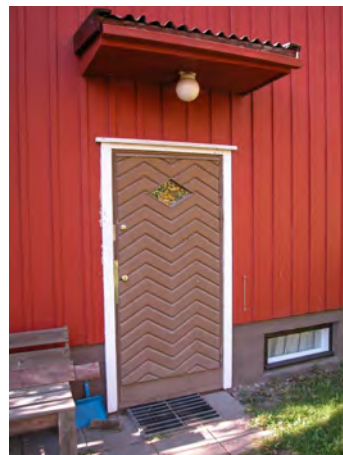
1950-luvun alun kaunis alkuperäinen m-paneloitu puuovi (Karhunkatu 55).
