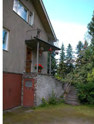
Sisäänkäynti 1950-luvun paritalon päädyssä (Karhunkatu 1).
