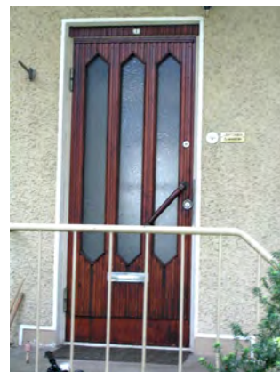
Kaunismuotoinen alkuperäinen 1950-luvun puolivälin pystyikkunallinen puuovi (Majavankatu 4).
