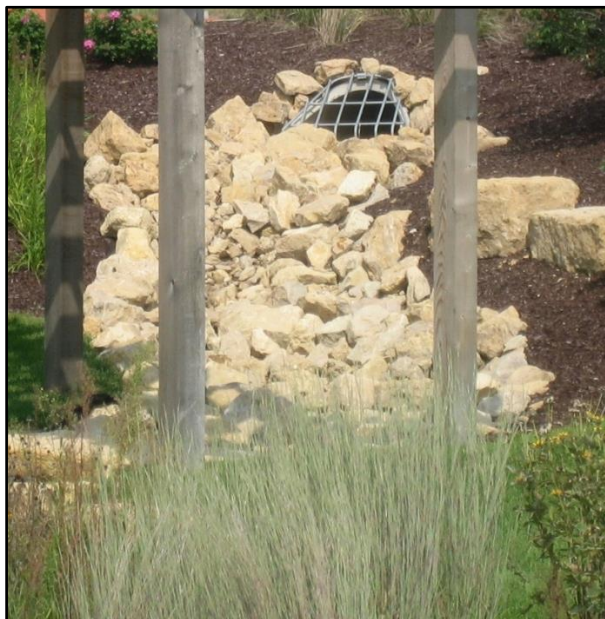
Kuva 13 Eroosiosuojausta Minnesotassa (FCG)
