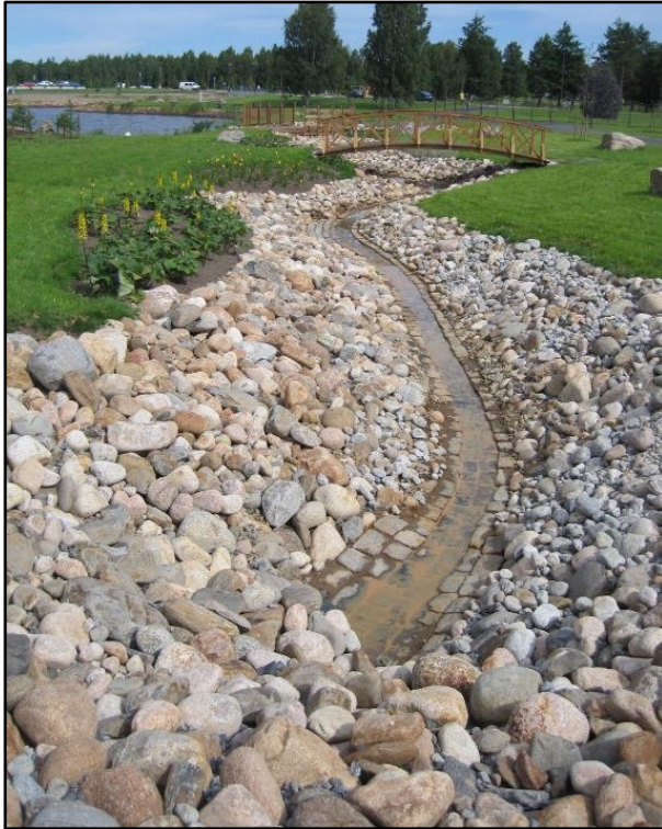
Kuva 12 Eroosiosuojausta Kokkolassa (FCG)
